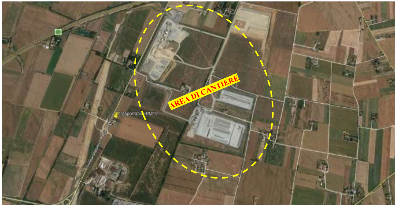
Punto di monitoraggio ARPA e aree di cantiere a Pozzolo f.ro – loc. Romanellotta UTMX 484011 UTM Y 4962693
