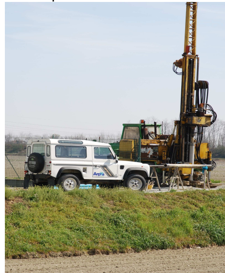
Perforazione di un pozzo della Regione Piemonte
