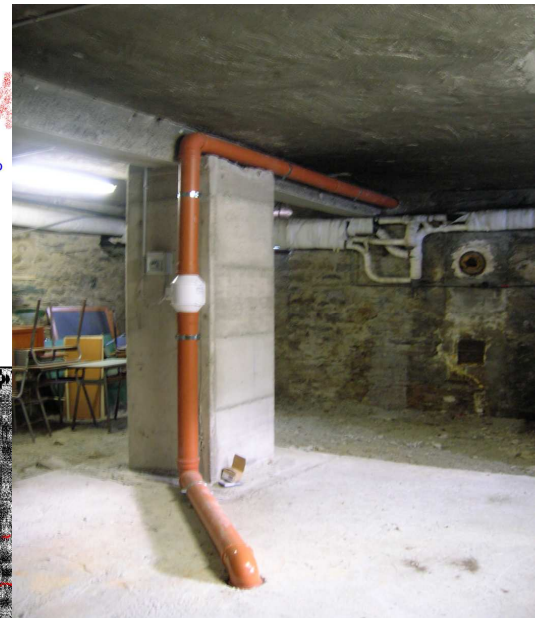
Implementazione di un impianto di estrazione del radon in un edificio scolastico.
