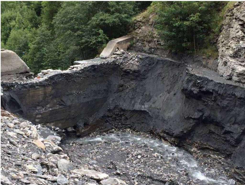
Figura 71 - Briglia in apice del conoide, a quota m 1371 ripresa nell'anno 2015. La spiaggia di deposito si è svuotata, la contro briglia è scalzata e sifonata.
