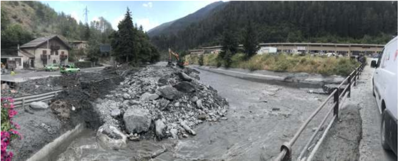
Figura 42 – Panoramica verso valle dall'attraversamento della caserma dei VVF.
