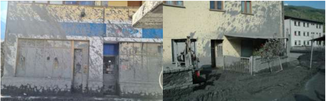
Figura 37 – In sponda sinistra, gli spruzzi di fango hanno raggiunto il secondo piano fuori terra: distributore di carburante, Piazza Europa 11 (a sinistra) e lo stesso edificio lato Via Papa Giovanni XXIII (a destra).
