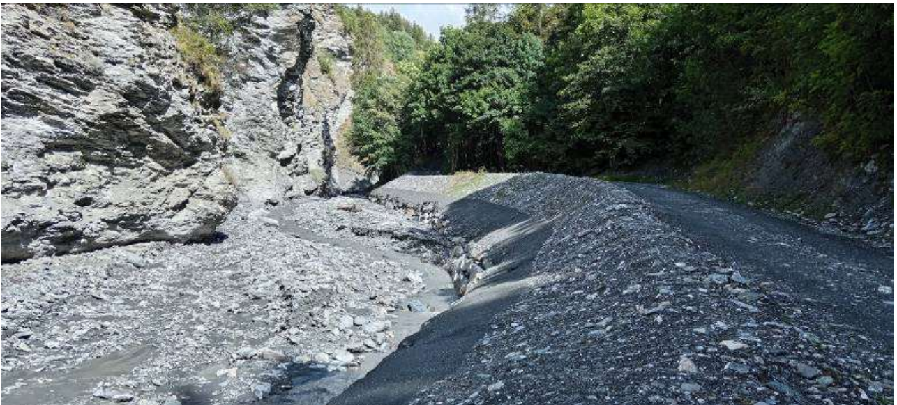
Figura 73 - Briglia in apice del conoide, a quota m 1371 riprese nel post-evento del 13 agosto 2023. Il leggero deposito sabbioso sulla sponda sinistra idrografica indica la quota del colmo della colata.
