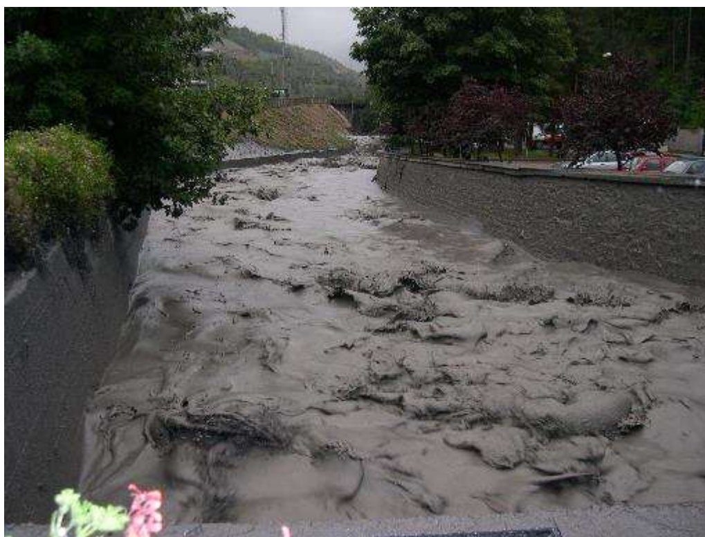
Figura 20 - Un esempio della principale tipologia di processo torrentizio che più frequentemente raggiunge l'area di conoide del Rio Frejus (6 agosto 2004).
