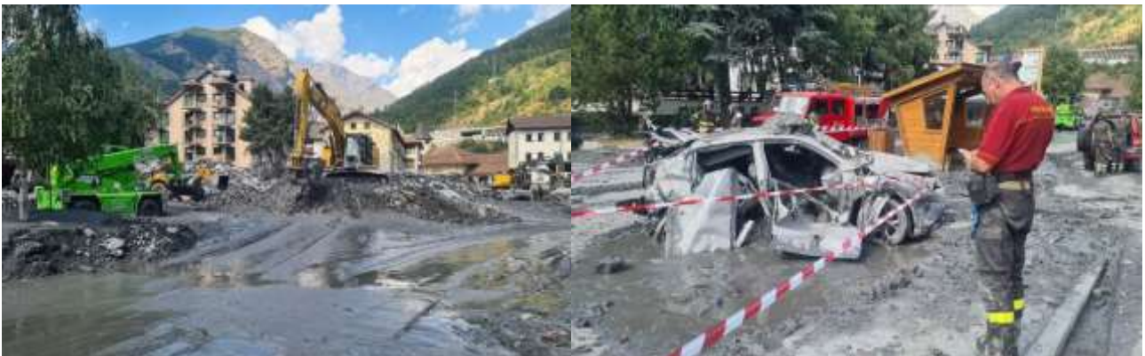
Figura 34 – Rotonda di via Torino, imponente accumulo di materiale grossolano e dettaglio di automezzi coinvolti.
