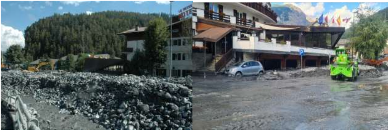
Figura 38 – A sinistra, accumulo di materiale grossolano a monte del ponte di via Stazione e coinvolgimento dell'Hotel la Betulla e, a destra, visto dal lato di Viale della Vittoria dove l'accumulo è stato prevalentemente di granulometria fine.
