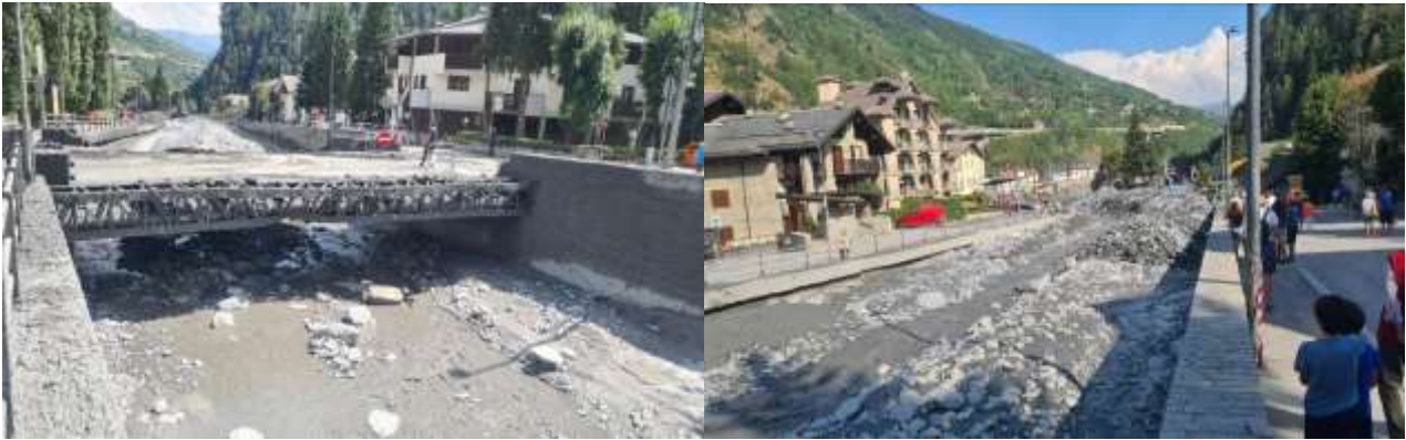
Figura 32 – A sinistra: il ponte di via Montenero, visto da monte, privato totalmente delle sponde. A destra: alveo intasato di materiale detritico a valle del ponte di via Montenero
