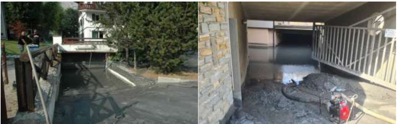
Figura 36 – A sinistra: garage allagati dell'albergo la Betulla (Viale della Vittoria, n 4) e, a destra, del condominio Merdovine 2 (Via Papa Giovanni XXIII, n 2B).
