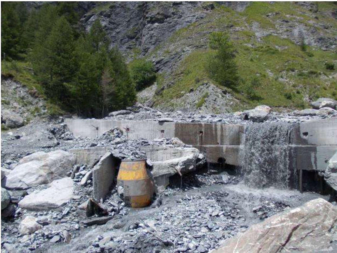
Figura 56 - Briglia a quota m 1732 ripresa nell'anno 2007. Visibili i danni alla platea di caduta ed alla ala destra della briglia.
