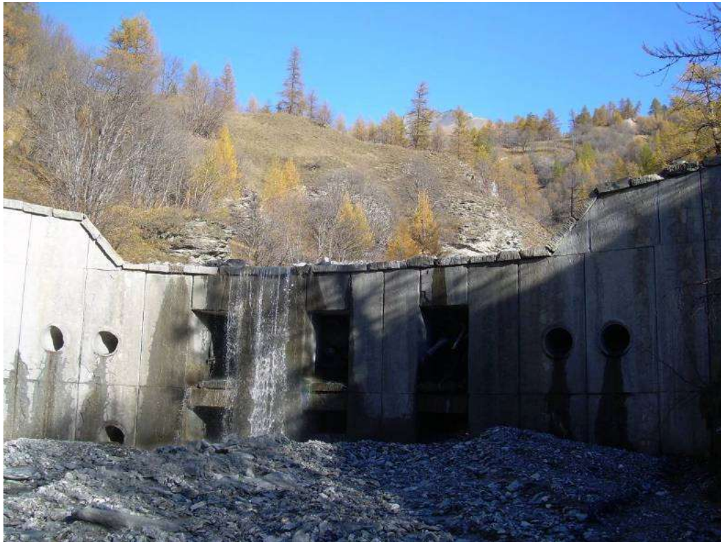
Figura 66 - Briglia fenestrata a quota m 1650 più a monte ripresa nell'anno 2006. Il lato maggiore delle finestre misura 3 metri.
