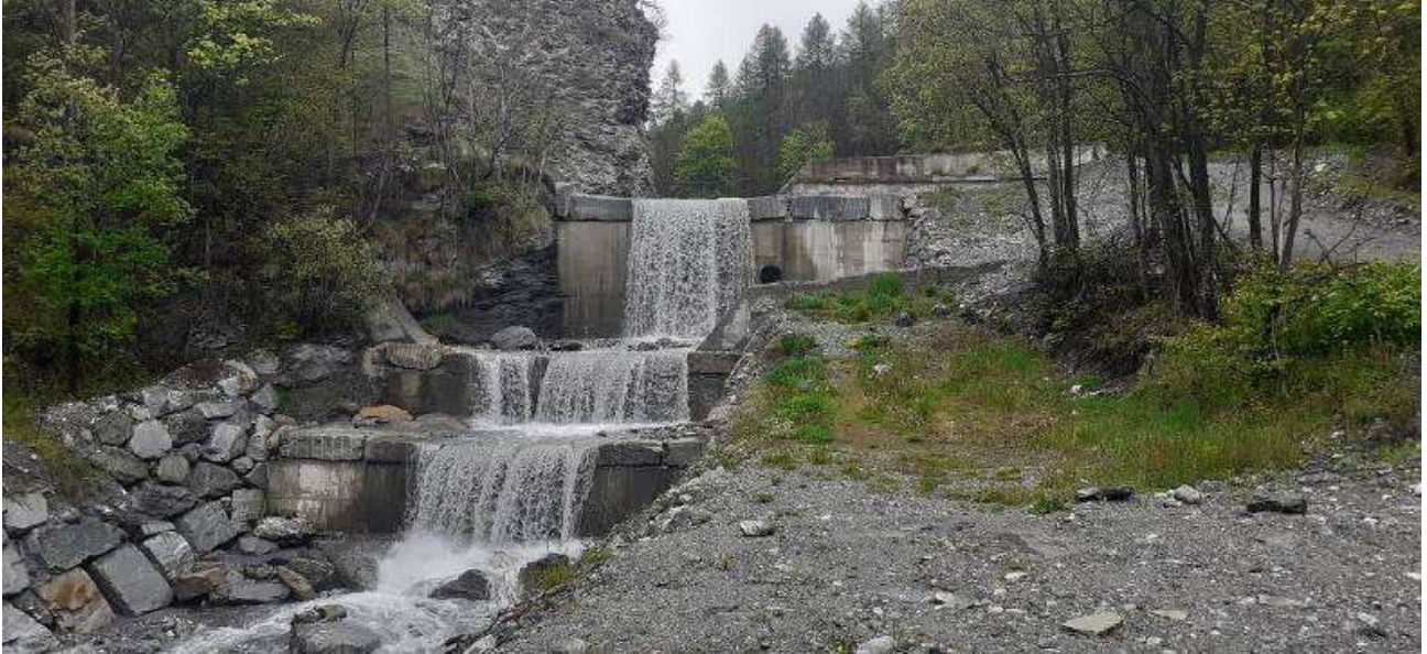
Figura 72 - Briglia e controbriglie in apice del conoide, a quota m 1371 riprese il 18 maggio 2023.
