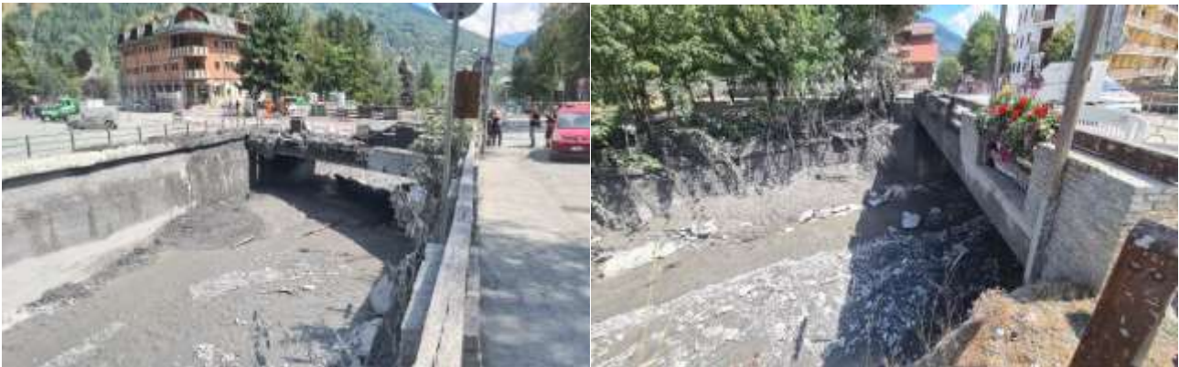
Figura 31 – Il ponte di via Medail (a sinistra) e quello di Piazza Alcide de Gasperi (a destra), parzialmente sormontati dalla parte liquida e più fine della colata.
