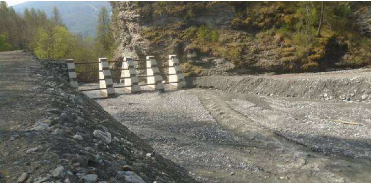
Figura 68 - Briglia selettiva a quota m 1390 alla fine lavori del giugno-luglio 2023.
