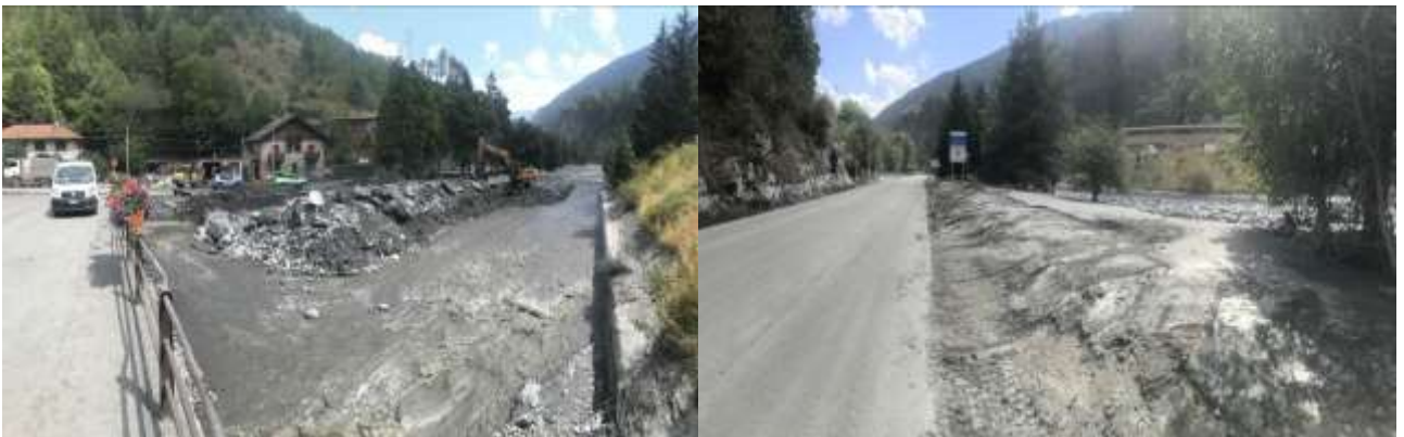
Figura 43 – Attraversamento della caserma dei VVF: vista verso gli edifici di Via Susa coinvolti (a sinistra). Vista verso valle della SS335, poco a monte del punto di biforcazione tra i due lobi (a destra).
