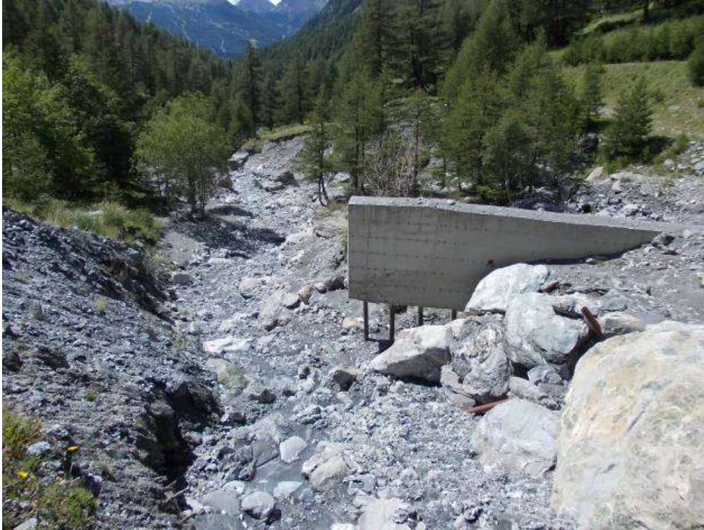
Figura 57 - Briglia a quota m 1732 ripresa nell'anno 2007 in cui si evidenzia l'aggiramento dell'ala sinistra della briglia, sospesa di m 3 sull'alveo.
