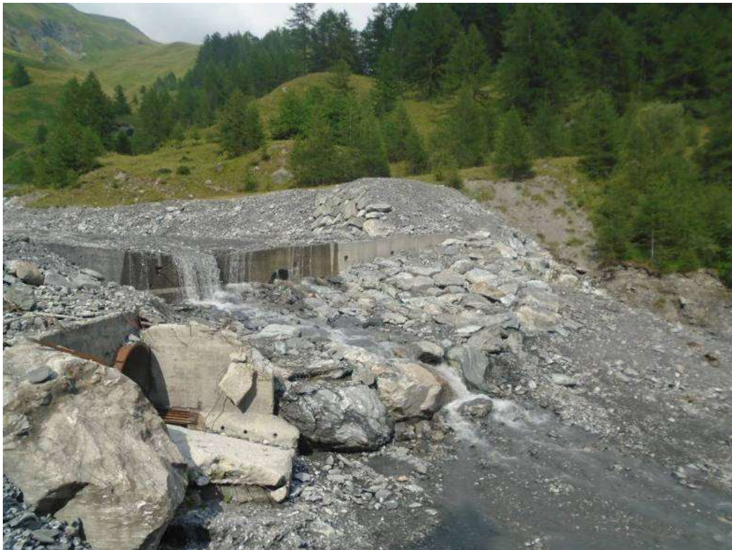
Figura 58 - Briglia a quota m 1732 dopo la manutenzione effettuata nell'anno 2020.
