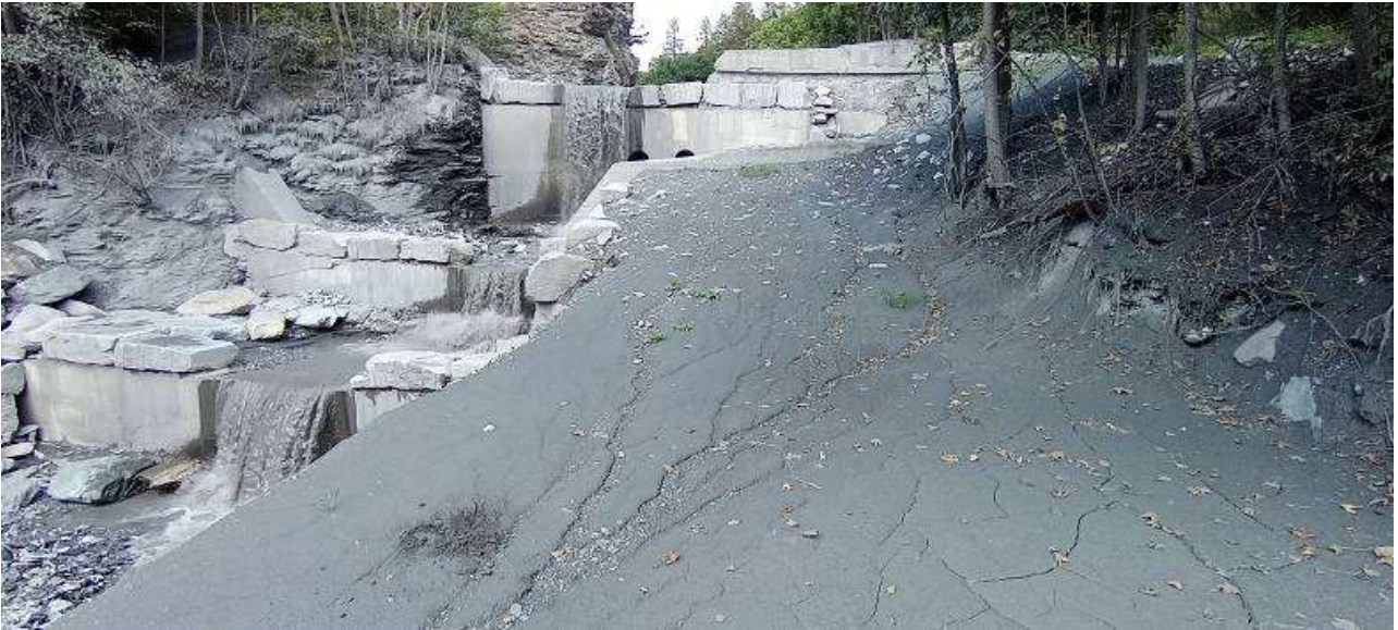
Figura 74 - Briglia in apice del conoide a quota m 1371 ripresa nel post-evento del 13 agosto 2023. La colata del 13 agosto ha sormontato l'ala sinistra ed è poi rientrata in alveo poche decine di metri più a valle.
