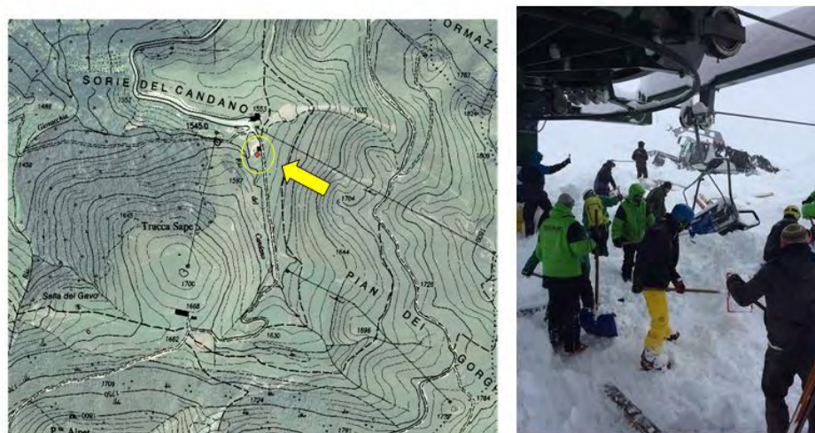
Figura 4.11: a sinistra localizzazione cartografica della valanga: la freccia indica la zona di distacco e il cerchio giallo identifica la cabina elettrica danneggiata. A destra operazioni di sgombero della neve per ripristinare l'impianto di Prato Nevoso.
