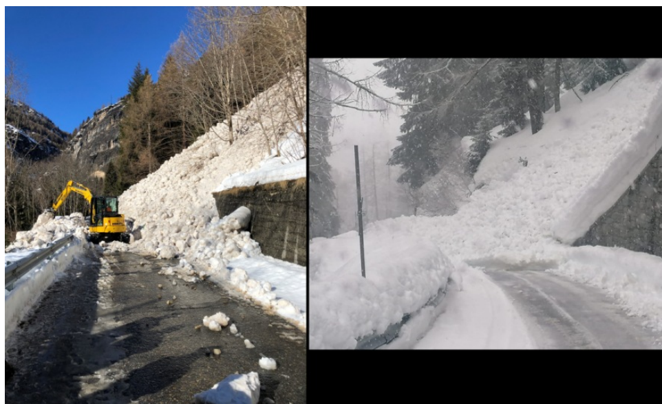
Figura 4.8: Valanghe che hanno interessato la strada del Devero tra il 29 e il 30 gennaio.
