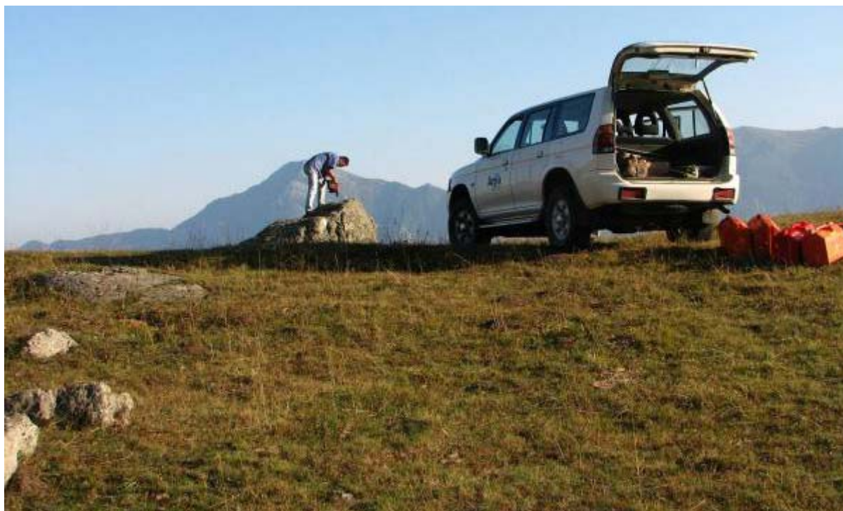
Figura 3.4 – Installazione del caposaldo G4SMPAC in località Pian Piè ad opera dei tecnici di Arpa Piemonte
