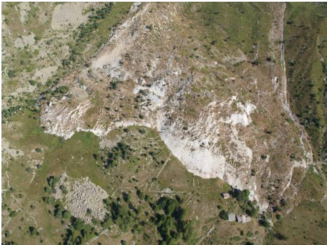
Accumulo di frana; in basso a destra Grange Orgiera
