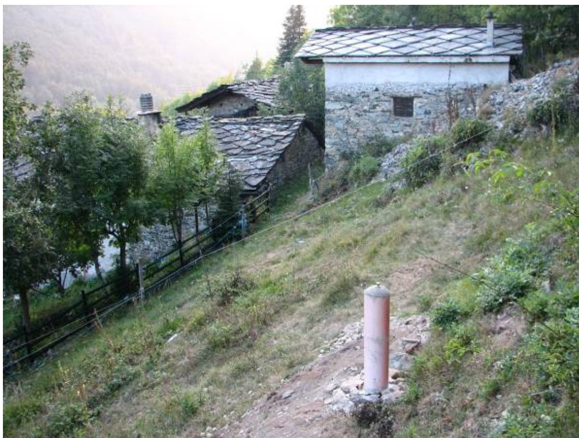
Figura 3.5 – Caposaldo G4SMPAB realizzato dall'Ufficio Tecnico Comunale in località Confine di Sopra
