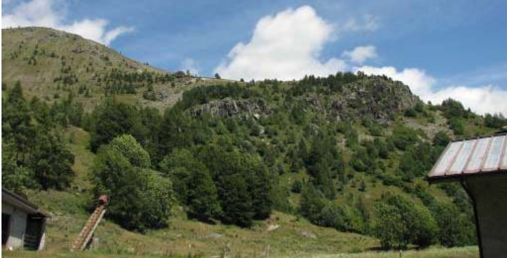
Figura 2.12 – Panoramica che rappresenta i bersagli della zona al di sotto dell'unghia del fenomeno. I bersagli sono rappresentati da porzioni lapidee in posto o campi di detrito poco coerente.
