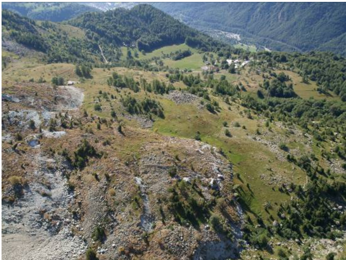
Accumulo di frana; in alto a sinistra Grange Orgiera, in alto a destra la borgata Pui
