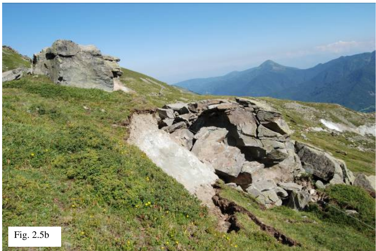
Figura 2.5 – Massi in corrispondenza del coronamento della frana che evidenziano la dislocazione avvenuta tra il 15/07/09 (fig. 2.5a) e il 25/07/09 (fig. 2.5b).
