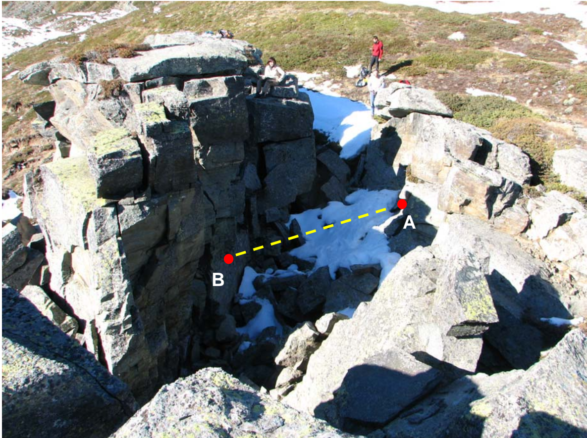
Figura 3.9 - Frattura presente alla quota di 2130 m circa, posta sotto controllo mediante l'installazione della base distanziometrica AB. Tra il 10 settembre e il 25 novembre 2009, la distanza (linea tratteggiata gialla) tra i punti A e B è aumentata di 4.2 cm.
