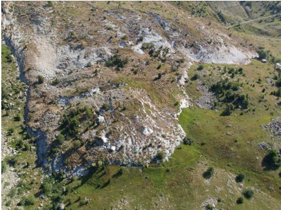
Accumulo di frana
