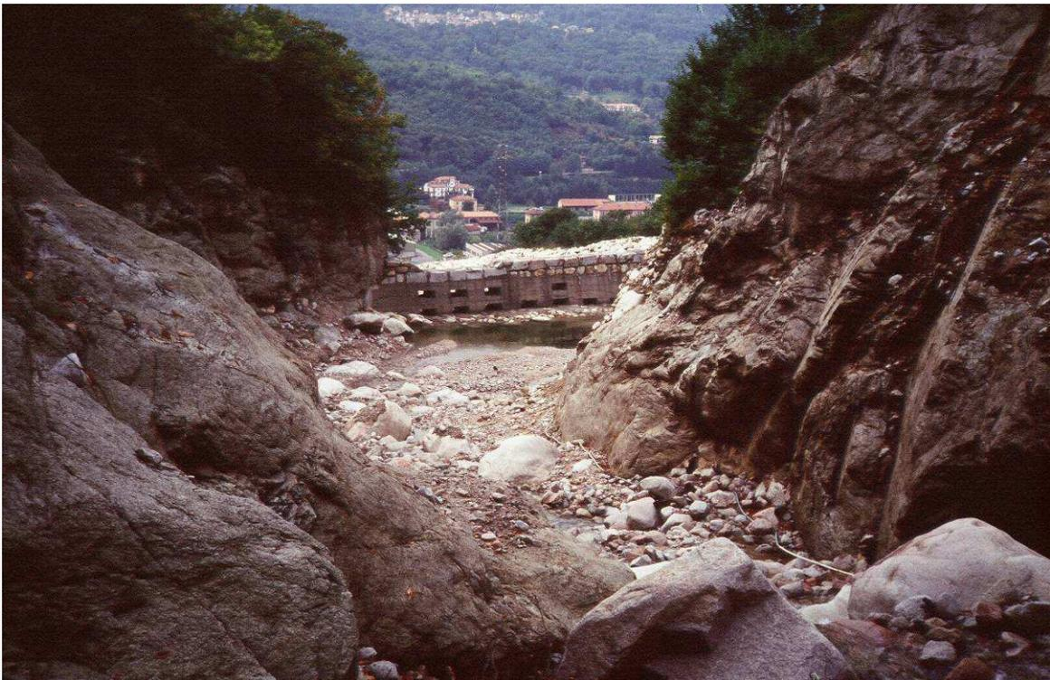
Fig. 33 *a* e *b*. Piazza di deposito a monte della prima briglia a finestre: foto *a* dopo l'evento del 2009, foto *b* dopo i lavori di costruzione (1998).
