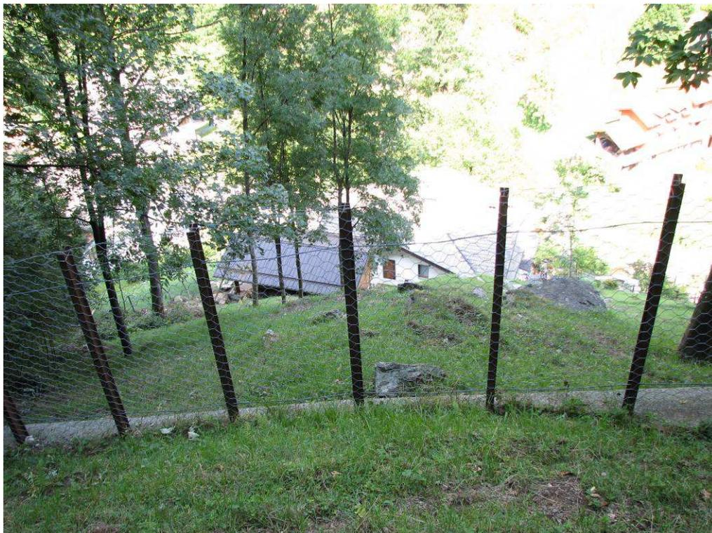
Fig. 24. Rete di protezione a ridosso del bosco a monte dell'abitazione
