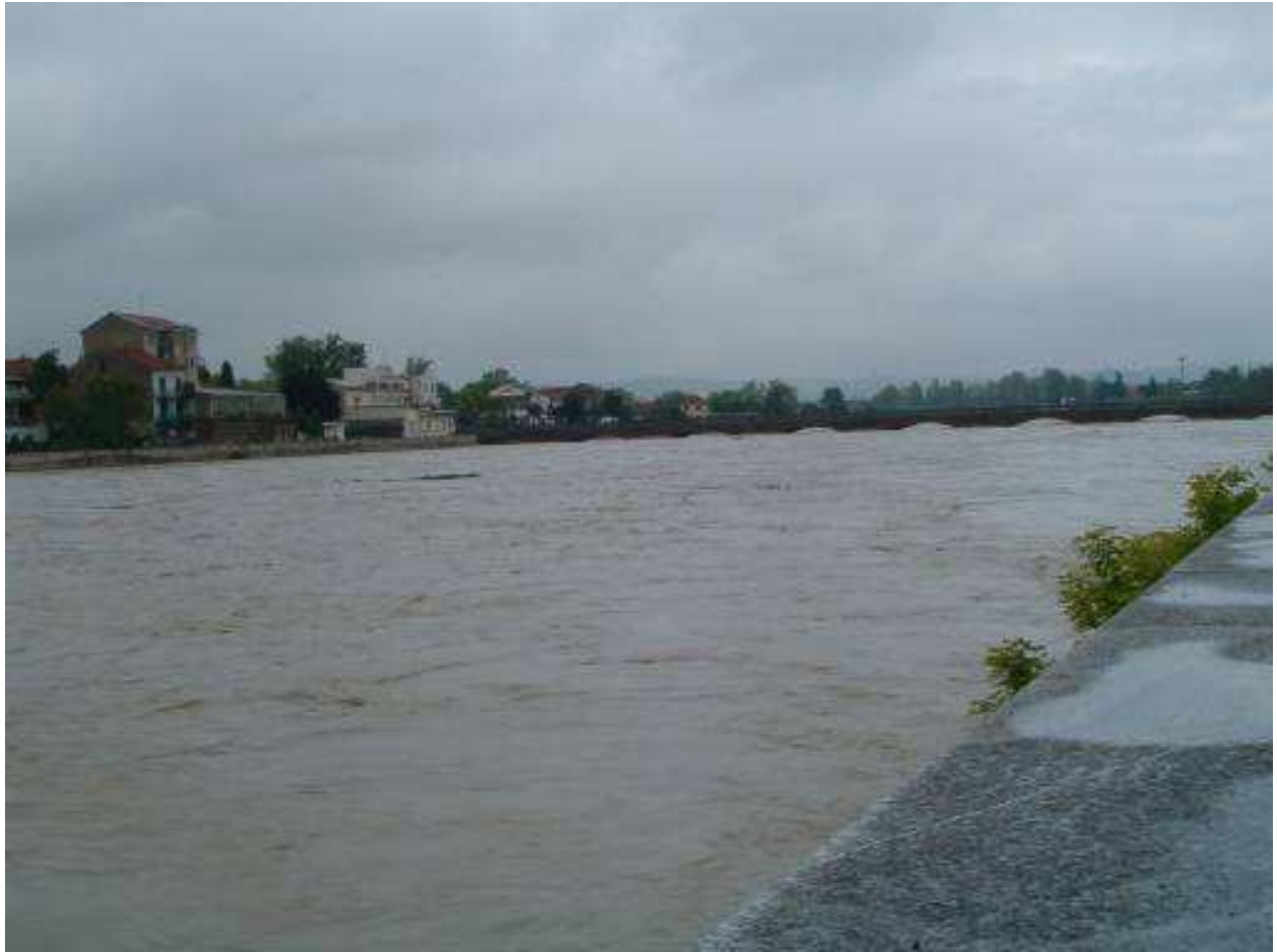
Figura 21. Alessandria: Ponte della Cittadella visto da monte alle ore 11:59 UTC del 28/04/2009
