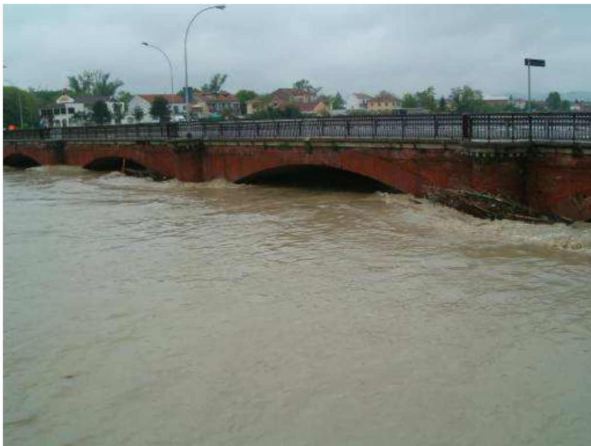
Figura 22. Alessandria: Ponte della Cittadella visto da monte alle ore 12:10 UTC del 28/04/2009
