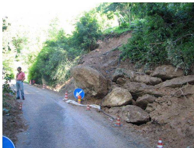
Figura 29. Comune di Pont Canavese, loc. Prua. A sinistra ubicazione della frana, a destra particolare del movimento gravitativo costituito da terra con grossi blocchi.
