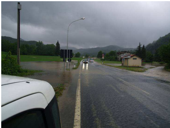
Figura 36. Comune di Roccaforte Mondovì. Allagamento della S.P. Chiusa Pesio-Villanova Mondovì in prossimità del settore occidentale dell'abitato di Roccaforte Mondovì
