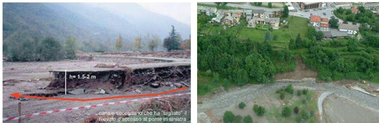
Figura 33. Comune di Villar Pellice, Ponte Albertenga. Rilevato stradale di accesso al ponte asportato nel corso dell'evento dell'ottobre 2000 (a sinistra); rilevato di accesso al ponte Albertenga in sinistra idrografica asportato in seguito all'evento alluvionale del maggio 2008 (a destra).
