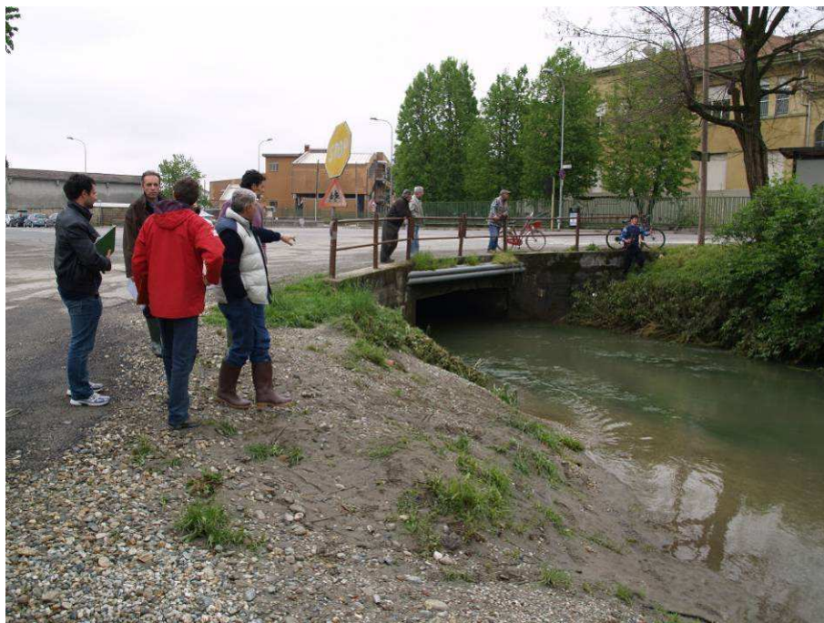
Punto 1 – Bealera Grossa del Molino nella zona in cui è esondata
