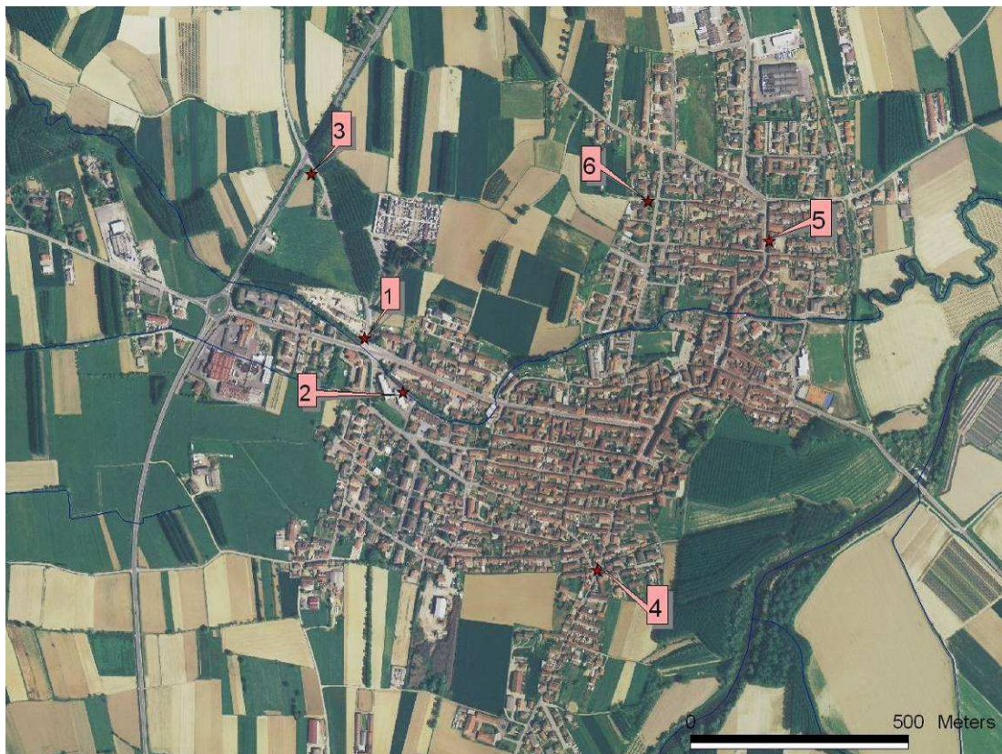
Villafranca Piemonte (TO) – Ubicazione delle principali situazioni di dissesto
