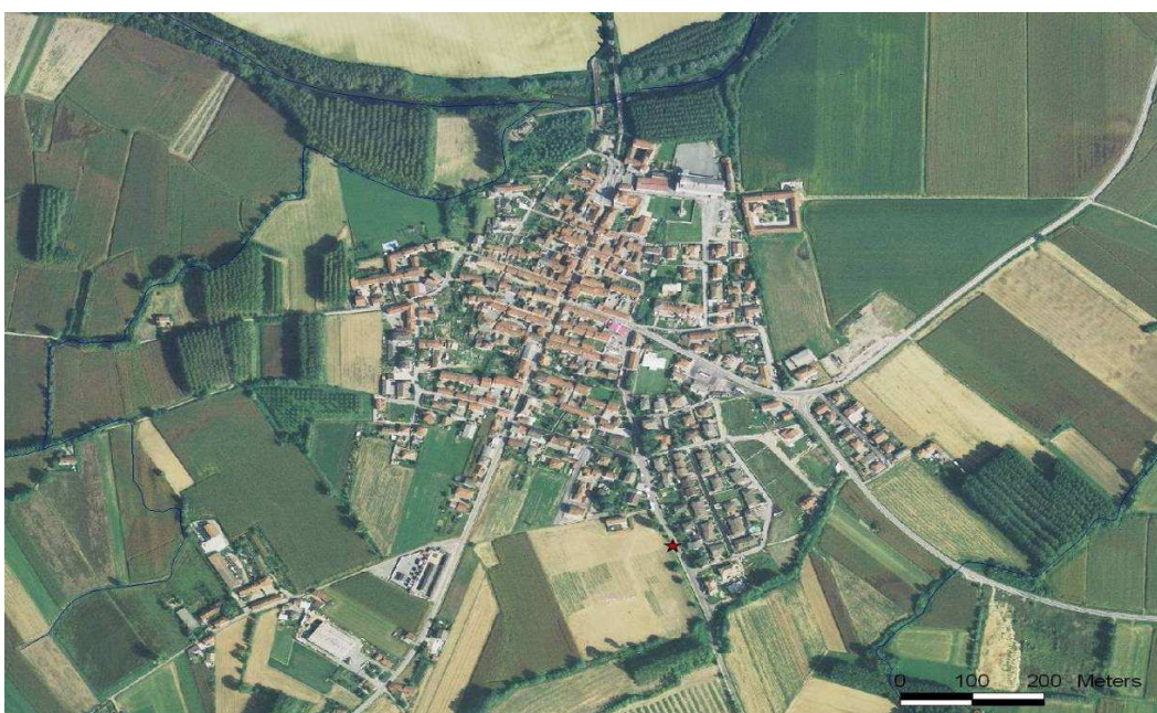
Cardè – Ubicazione delle principali situazioni di dissesto
