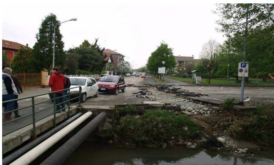
Punto 6 – Taglio del manto stradale in via Fratelli Carando
