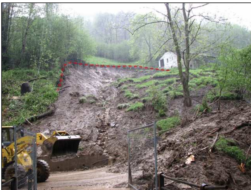
Veduta d'insieme del fenomeno franoso con evidenziata la nicchia di distacco
