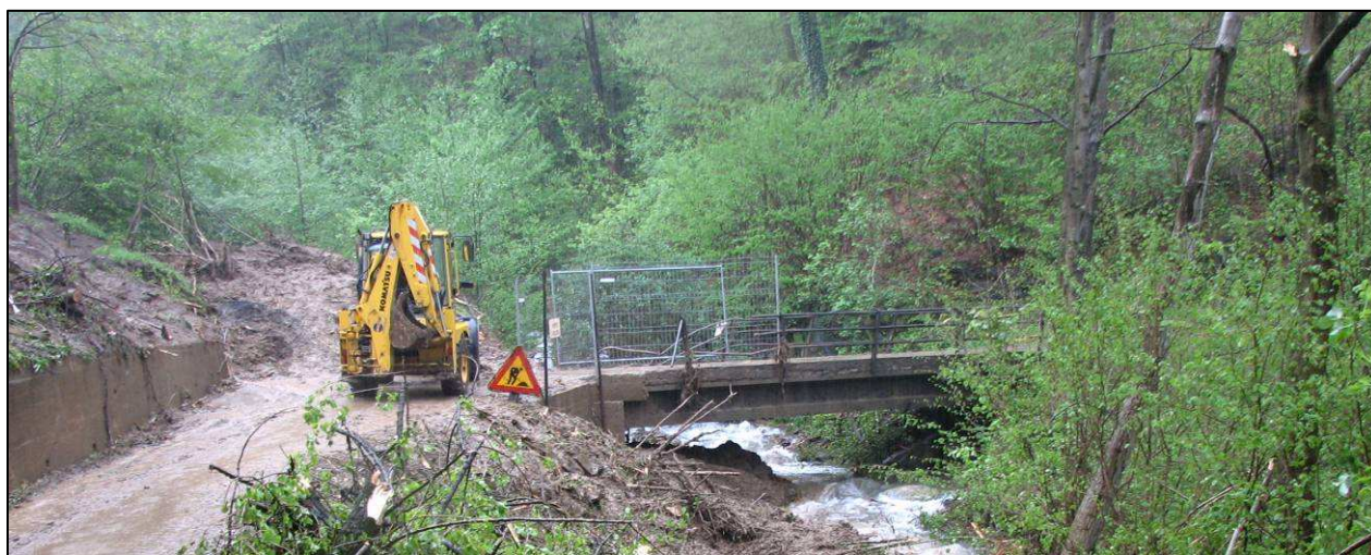
Attraversamento del rio Morezza per accedere alla frazione Usciso.
