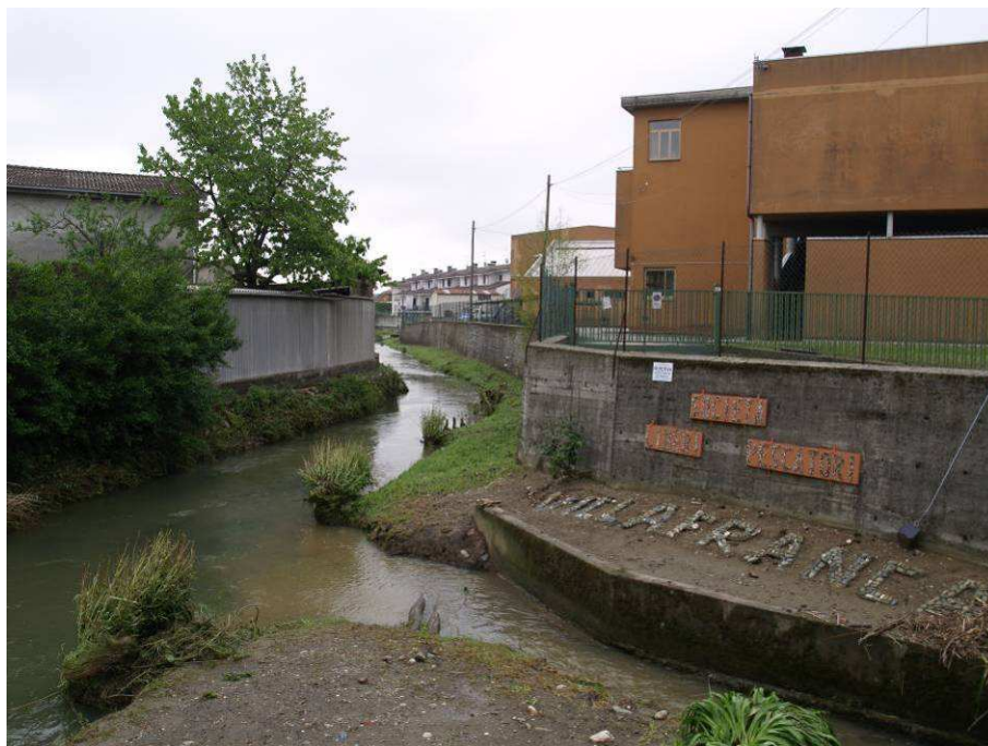
Punto 2 – Bealera Grossa del Molino in prossimità della Scuola Media
