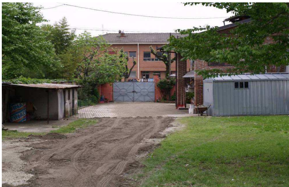
Punto 7 – Settore interessato dall'esondazione del canale Sambone; in secondo piano la Scuola Media
