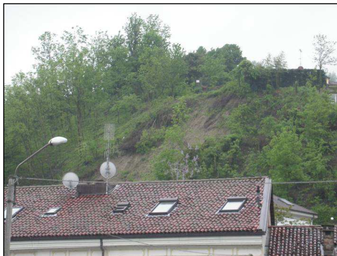
Fluidificazione coltri superficiali sul versante in sinistra idrografica del Rio Mongreno
