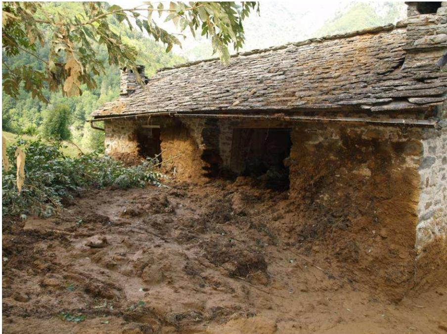
Fig. 32 Baita danneggiata, a valle del piccolo crinale da cui si è mobilitato il materiale
