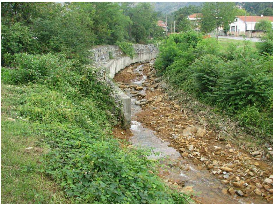
Figura 29 Scalzamento di difese spondali lungo il rio Vaccaro a Givoletto (TO)
