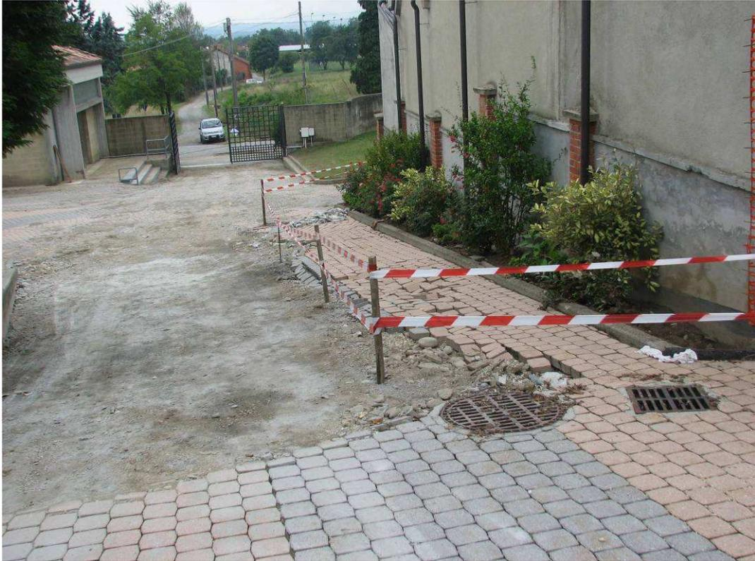
Figura 28 Cimitero di Givoletto (TO). Danni ad opera delle acque di ruscellamento.
