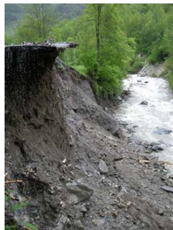
Scarpata di circa 20 m a spese del corpo stradale della S.P del bivio per Salza ad opera del Torrente Germanasca
