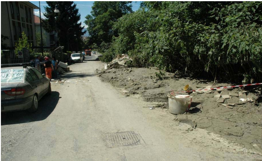
Figura 1. Materiale detritico lungo Via Tabacchi in corrispondenza dei civici 38/42.
