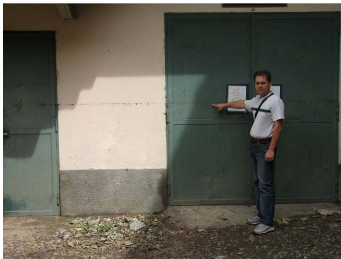
Figura 8. Traccia del livello d'acqua raggiunto in un cortile di P.zza Borromini, lato Po.
