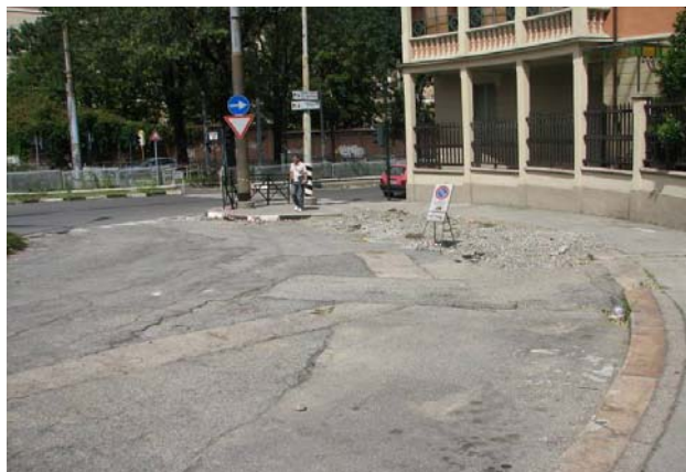
Figura 7. Accumulo di detriti, mattoni, asfalto trasportati in Piazza Hermada dal flusso d'acqua.
