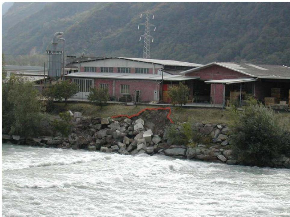
Figura 23. Tratto di scogliera erosa in sponda destra a valle del ponte in comune di Quassolo. La linea rossa evidenzia il limite superiore del cedimento della sponda.
