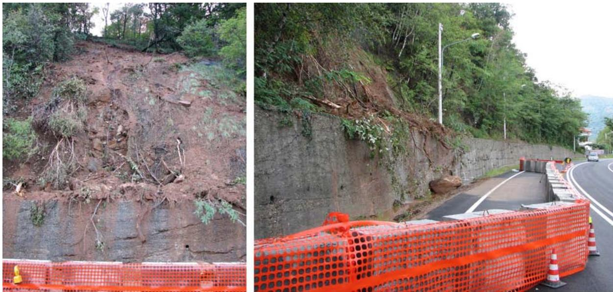
Figura 19. A sinistra vista frontale della frana superficiale e, a destra, parte inferiore della frana a ridosso della S.P. 1 Direttissima delle Valli di Lanzo (ripulita dopo l'invasione del materiale franato nella sede stradale).
