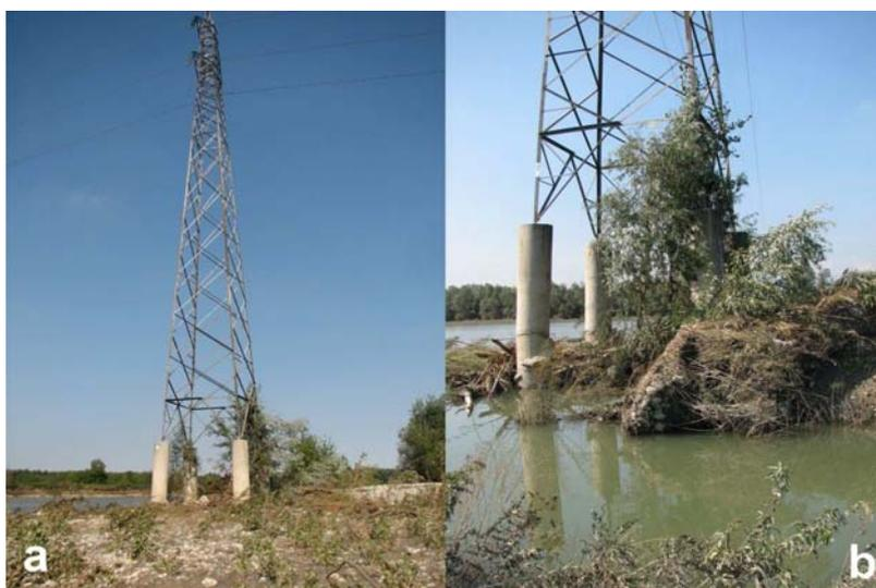
Figura 28. a) vista verso valle del traliccio posto in alveo del Po in cui si evidenzia la situazione di potenziale danno in occasione di piene; b) dettaglio dell'erosione a valle del basamento del traliccio.
