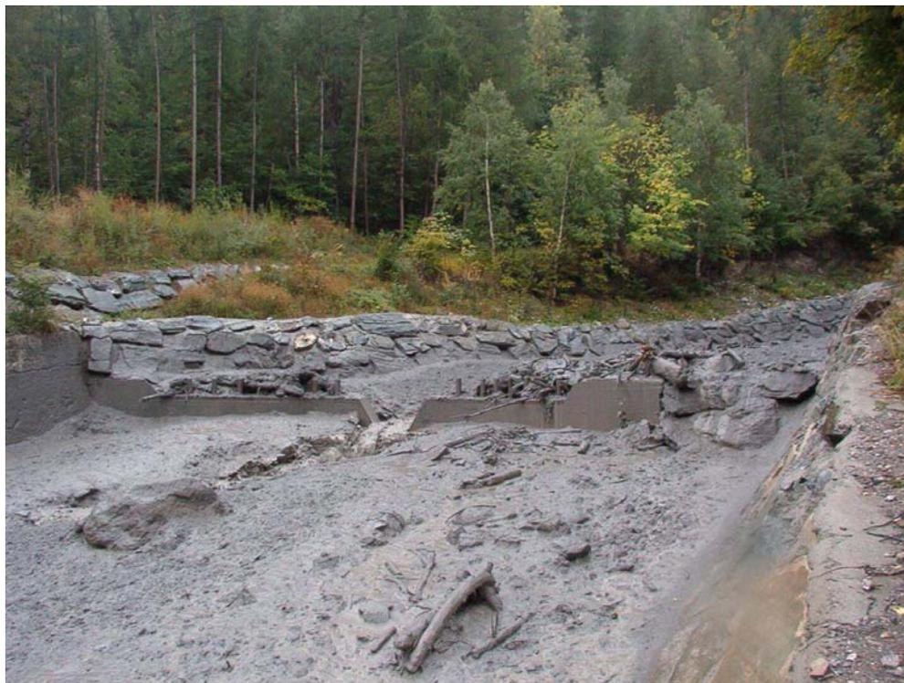
Figura 22. Rio San Giusto: tracce del passaggio della colata e opera idraulica colmata.
