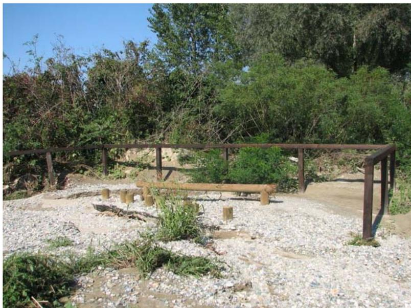
Figura 27. Danni causati dalla piena del 15 settembre alle strutture turistiche realizzate lungo la strada interpodereale nell'area del Parco Fluviale del Po. La strada risulta distrutta per un tratto esteso alcune centinaia di metri ed alcune stazioni ginniche (come quella nell'immagine) sono state in parte o del tutto asportate.
