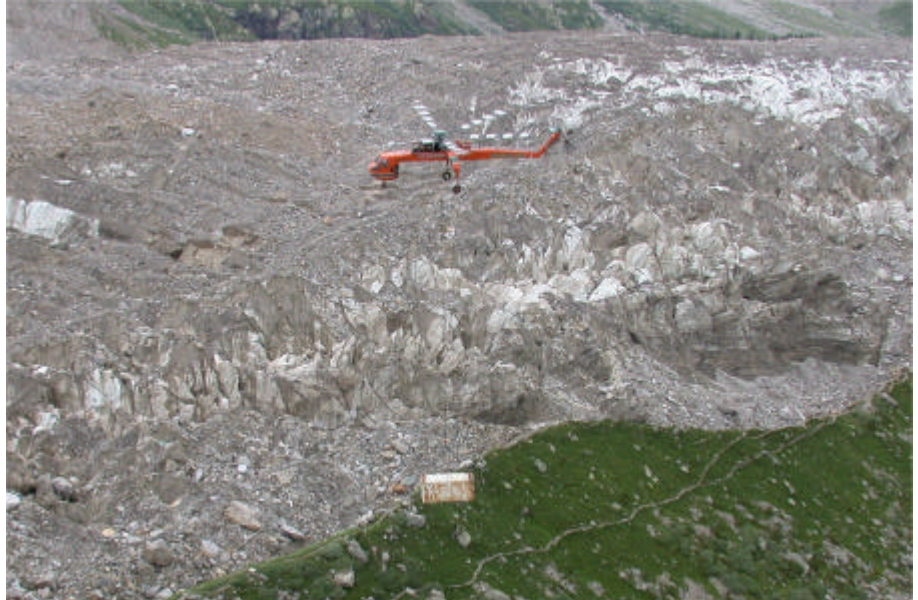
Figura 17: Impiego degli elicotteri per l'approntamento del cantiere.
