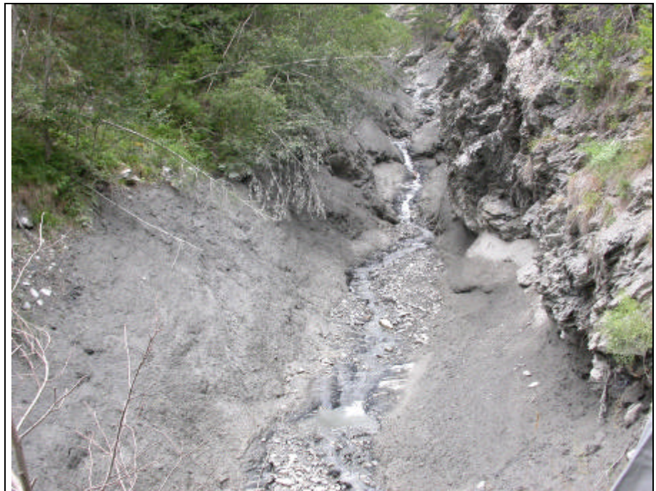
Fig. 11 - FigPunto G: Evidenze del passaggio della colata in un tratto d'alveo inciso in roccia. In questo punto la colata ha raggiunto 7-8 m dall'attuale fondo alveo.
