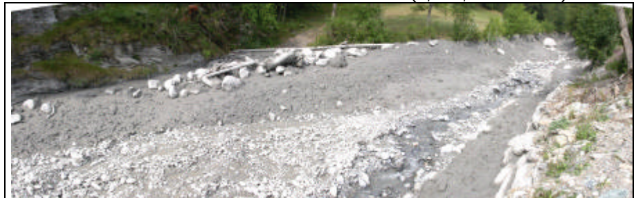
Fig. 7 - Punto D: Tratto del canale a debole pendenza con deposito di detriti e blocchi di dimensioni variabili (0,2÷0,8 m 3 circa).
