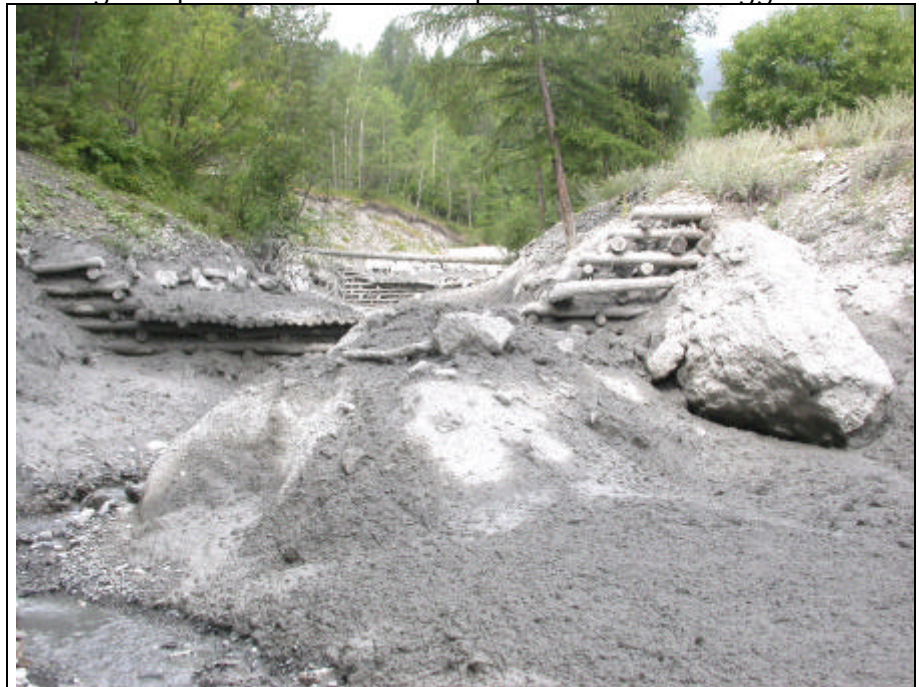
Fig. 9 - Punto E: Deposito in alveo in prossimità di alcune briglie in legno e pietra che risultano parzialmente danneggiate.
