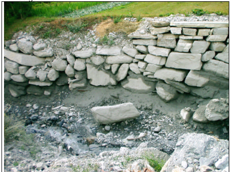
Fig. 5 - Punto B: Scogliera parzialmente danneggiata con asportazioni di alcuni massi in prossimità del ponte per la borgata Vernin.
