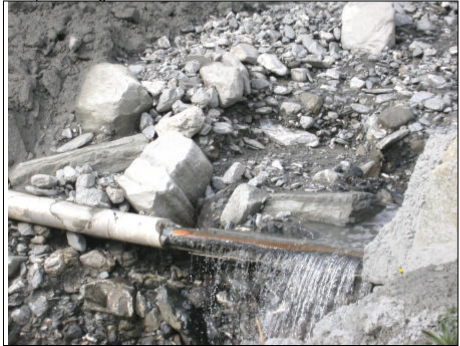
Fig. 5 - Punto B: Scogliera parzialmente danneggiata con asportazioni di alcuni massi in prossimità del ponte per la borgata Vernin.
