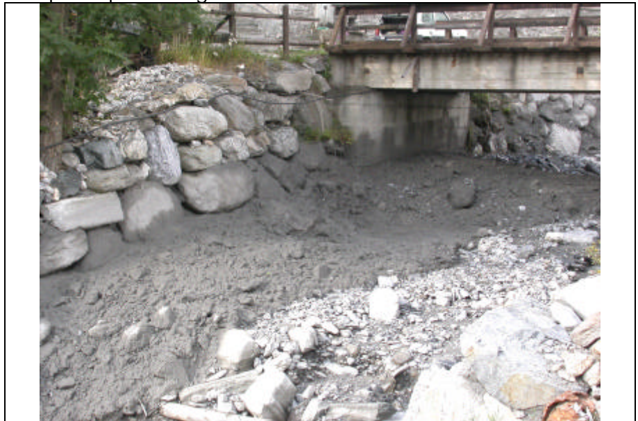
Fig. 3 - Punto B: Evidenze del passaggio della colata in prossimità del ponte per la borgata Vernin.
