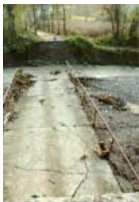
*Comune di Dernice - Divagazione d'alveo ed asportazione della spalla del ponte sul torrente Arzola, in località Ca' Bella*
