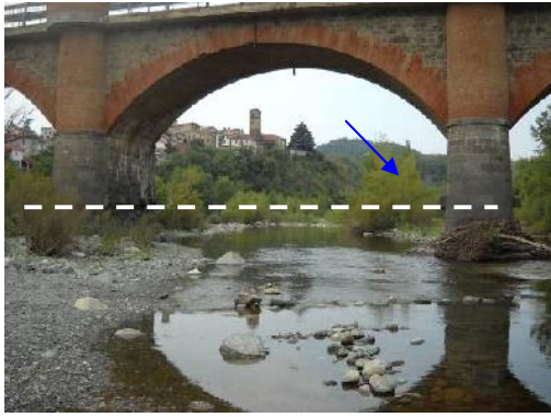
Molare e il ponte SS456, dal confronto delle due fotografie del ponte, utilizzando come riferimento i blocchi in roccia sporgenti dalle pile, si rileva l'entità dell'abbassamento del fondo (settembre 2012 - anni '40, fonte P. Albertelli).
