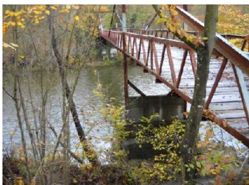
Ponte a monte della confluenza del T. Orbicella (novembre 2012).
