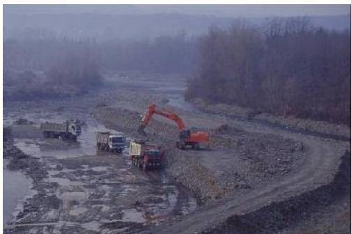
Intervento di rimozione di sedimenti, loc. Cascinotto (2000, foto A. e M. Vignolo).
