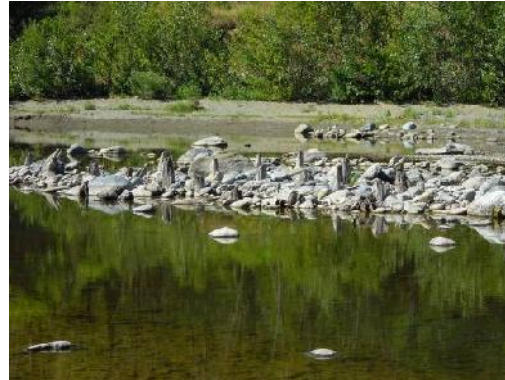
Emersione pali a valle della soglia posta in corrispondenza della confluenza del T. Amione (luglio 2012).
