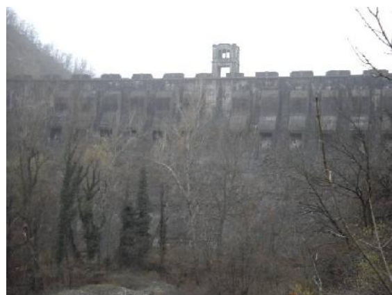
Diga Zerbino vista da valle (novembre 2009).
