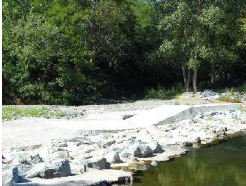
Soglia a valle della confluenza del T. Amione (luglio 2012).
