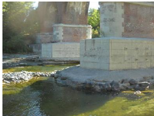
Ovada, ponte ferroviario (luglio 2012).
