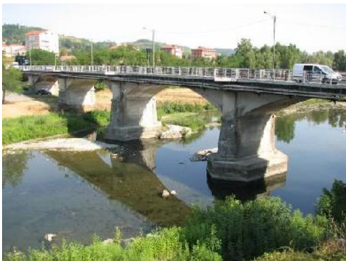
Ponte SP185 (luglio 2012).
