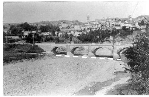
Molare e il ponte SS456, dal confronto delle due fotografie del ponte, utilizzando come riferimento i blocchi in roccia sporgenti dalle pile, si rileva l'entità dell'abbassamento del fondo (settembre 2012 - anni '40, fonte P. Albertelli).
