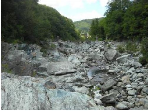
Alveo a valle della Diga di Ortiglieto (luglio 2012).
