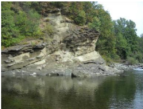
Sponda dx, a monte del ponte SS456 (settembre 2012).
