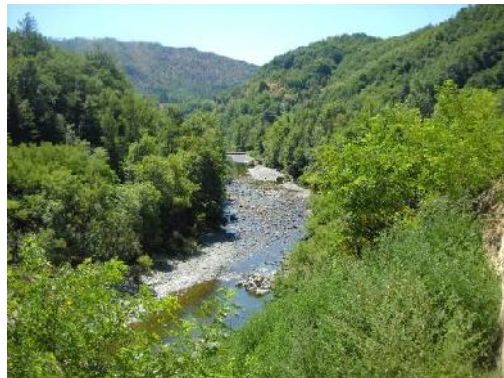
Vista a valle del guado in Loc. Vernini (luglio 2012).
