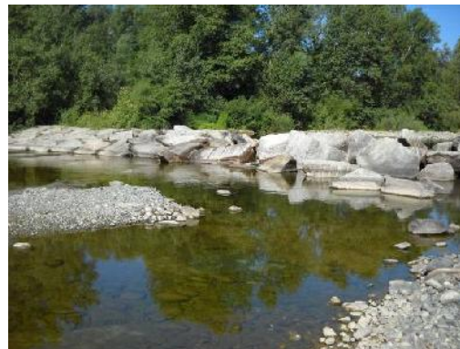
Traversa in massi in loc. Monteggio, limite di valle del tratto (luglio 2012).
