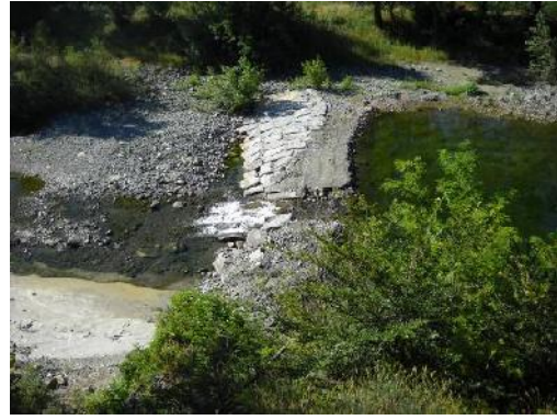
Attraversamento acquedotto, nei pressi di C.na Rossa (luglio 2012).
