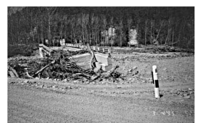
fig.8 Ponte sulla strada Arguello - Cravanzana pag.13
