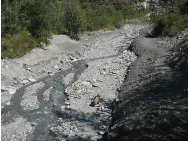
Fig. 19 Vista verso monte dell'alveo in conoide, nel settore mediano. Si notino i blocchi residuali (scheletro) dopo il passaggio della coda liquida del mud-debris flood del 3 settembre e delle portate liquide successive all'evento.
