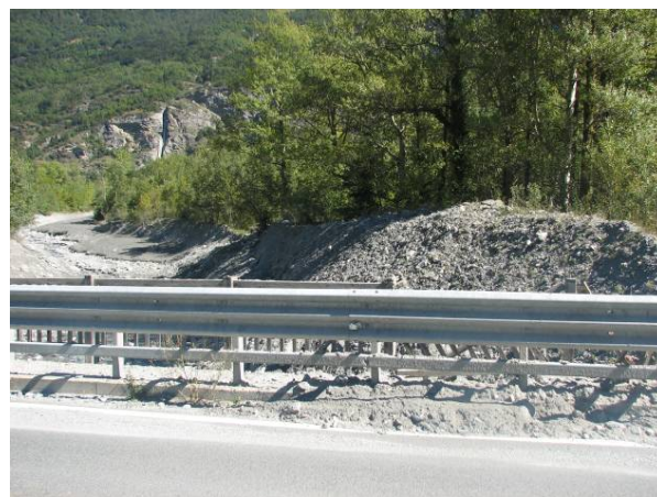
Fig. 23 Vista verso monte del ponte sulla Strada Provinciale per Susa-Novalesa.
