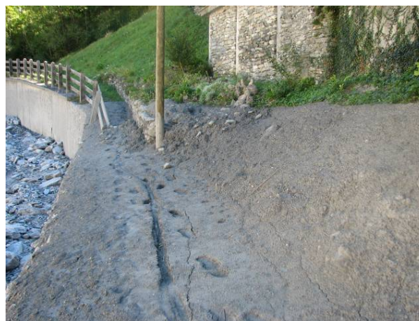
Fig. 18 - Particolare dei depositi abbandonati dal mud-debris flood in sinistra a monte del ponte di Novalesa (cerchio rosso in Fig. 16).
