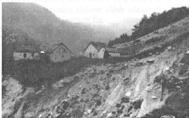
Figura 3 – Edifici a rischio a causa dell'arretramento della scarpata: sulla sinistra si osservano i resti di un edificio distrutto ed al centro uno gravemente danneggiato.
