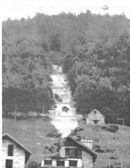
Figura 2 – Edificio in località Arvoglio investito da una colata rapida della coltre superficiale. Il processo ha causato una vittima e ha gravemente danneggiato l'edificio (attualmente smantellato). Sullo sfondo sono visibili gli interventi di sistemazione del versante.
