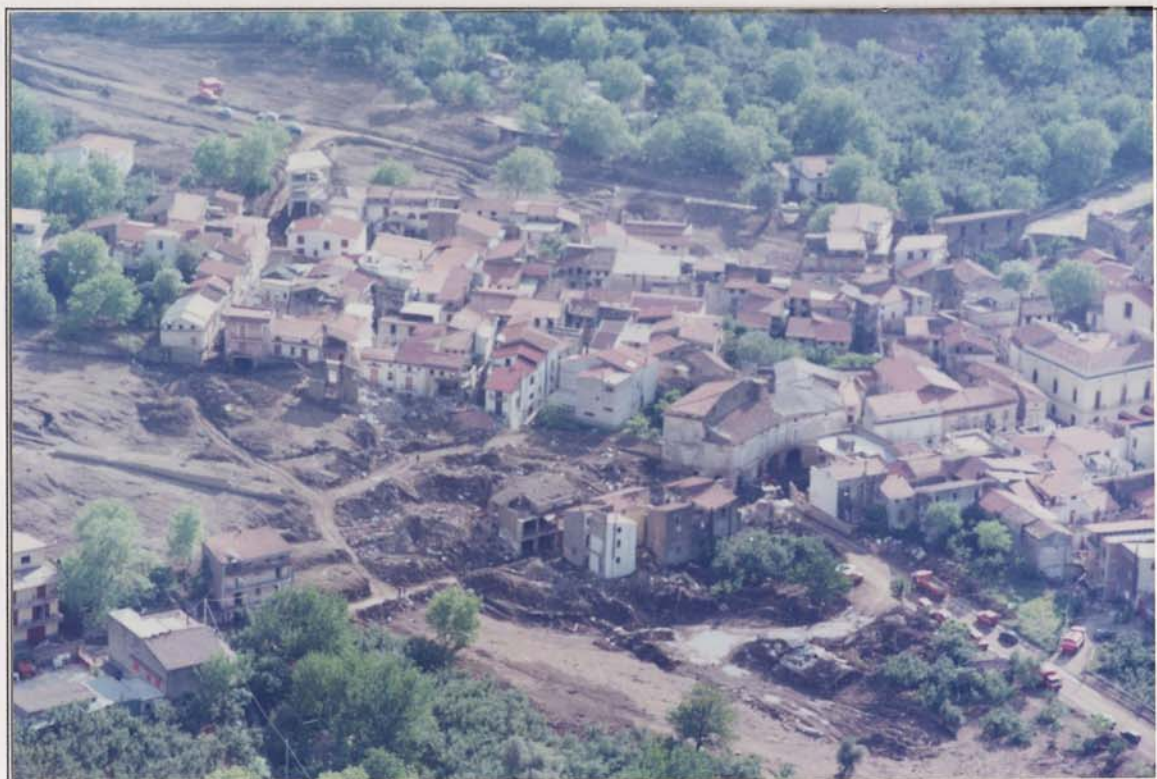
FOTO 10: Comune di Quindici. Danni agli edifici ed alle infrastrutture nei settori maggiormente colpiti nella parte alta del paese.
