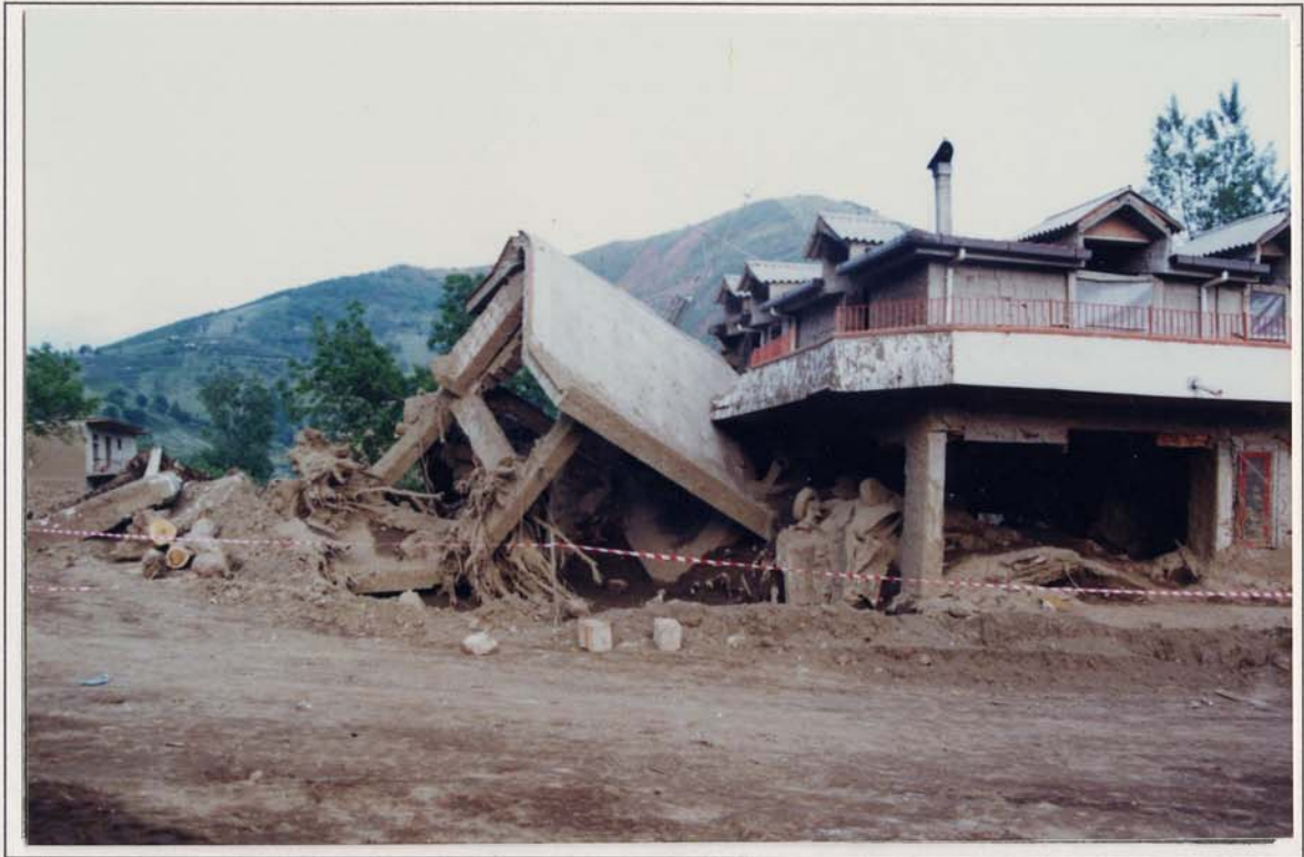
FOTO 7: Comune di Siano. Edificio traslato e distrutto nella parte alta del paese.
