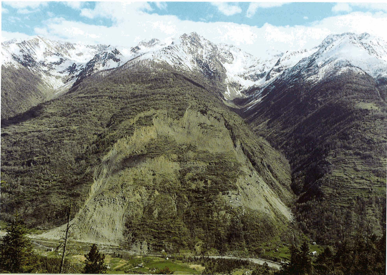
Vue générale du glissement de la Clapière (1995).
