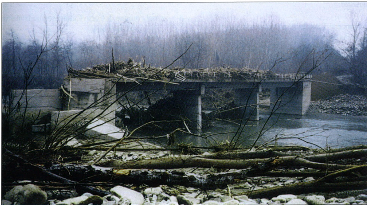
Fig. 20.5 Immagine del ponte posto a valle di Niella Tanaro
