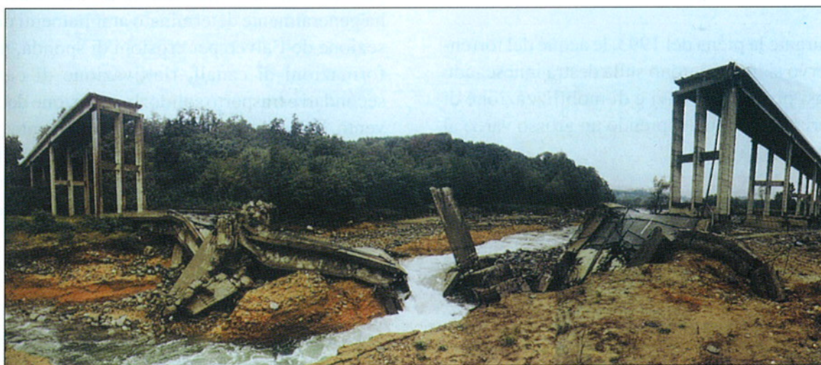
Fig. 19.4 Torrente Cervo. Vista da valle del ponte-viadotto della S.S.142
