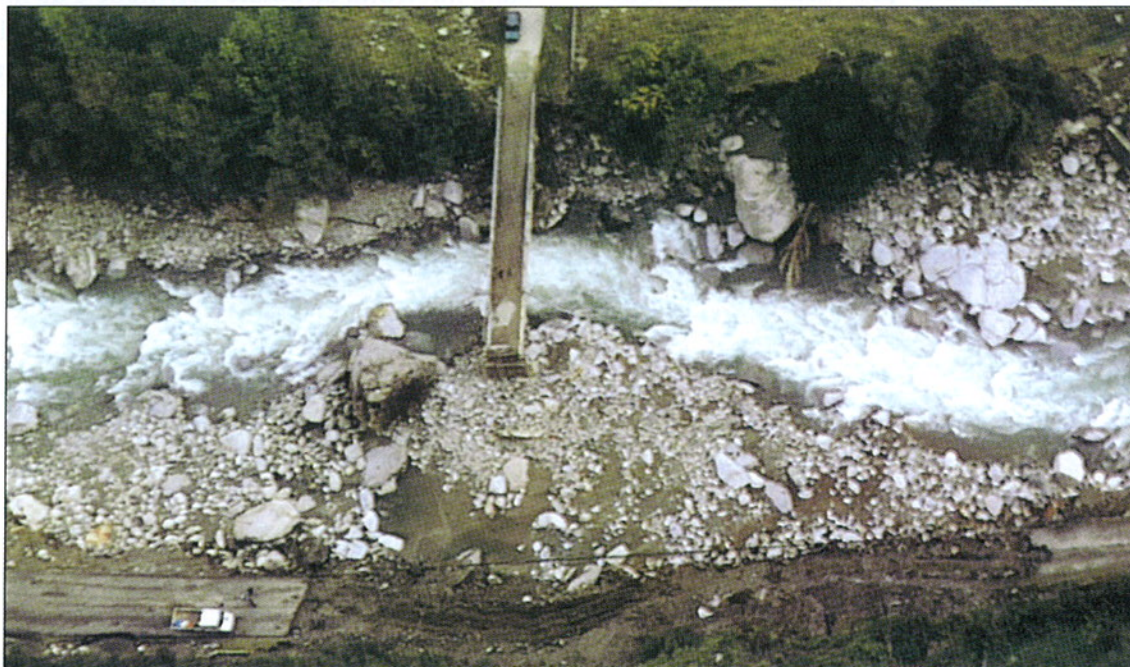
Fig. 19.5 Ronco, ponte per la frazione Montelavecchia.
