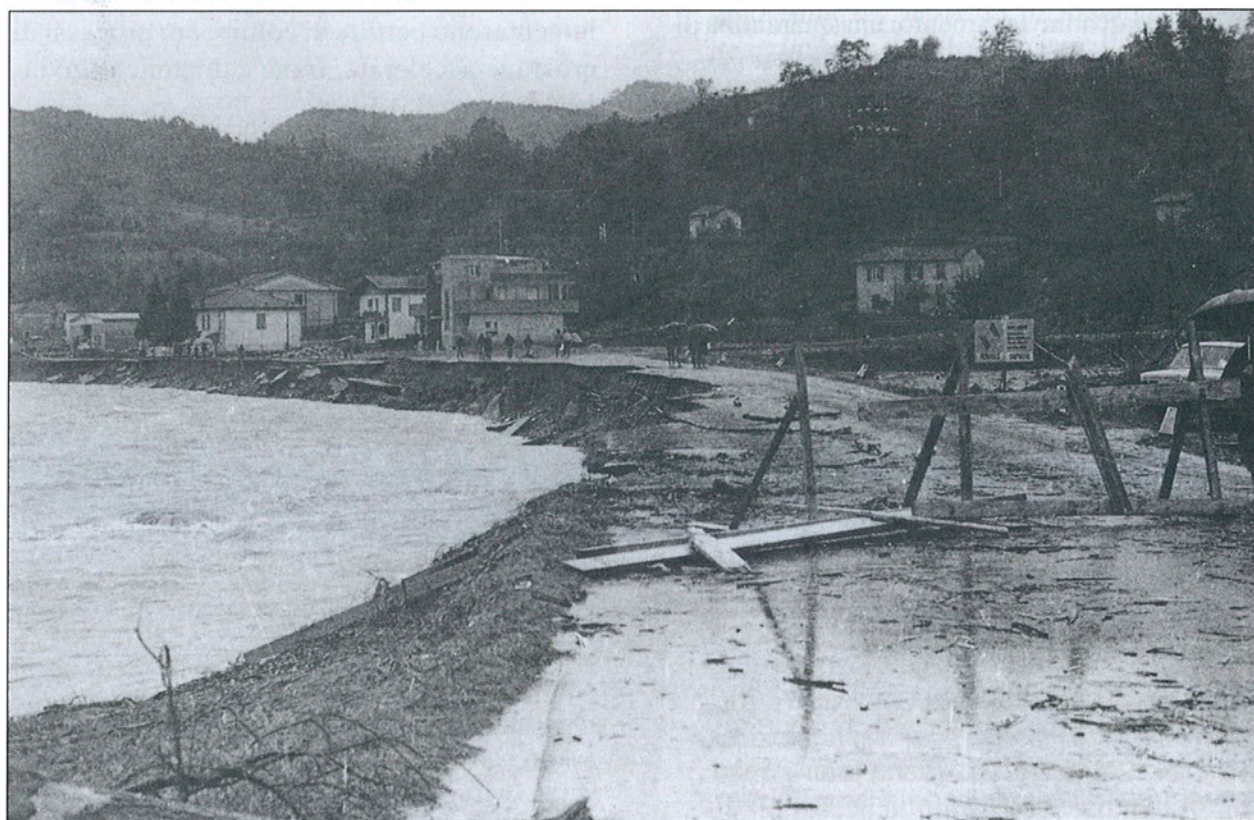
Fig. 17.4 Appena a monte dell'abitato di Ovada, l'intensa erosione esercitata in sponda sinistra dal T.Stura
