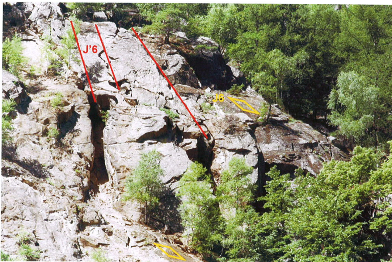
Fig. III.8 : Photo d'une instabilité de glissement superficiel sur une discontinuité J6.
