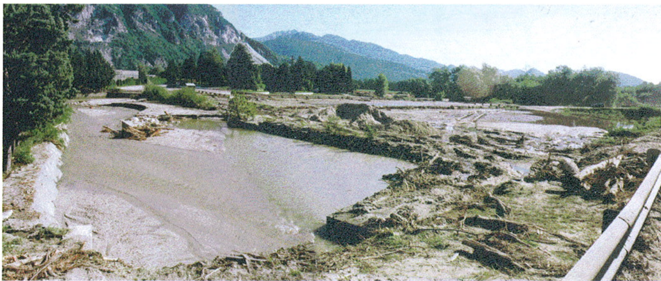
Fig. 4. Gravellona Toce. Ripresa dalla SS n. 33 del Sempione verso la sponda destra del t. Stronetta. In quest'area si sono depositi i materiali fini in sospensione e parte dell'ingente carico vegetale trasportato dal rio Frassino, causando l'interruzione della viabilità e il colmamento della vasca di sedimentazione.
