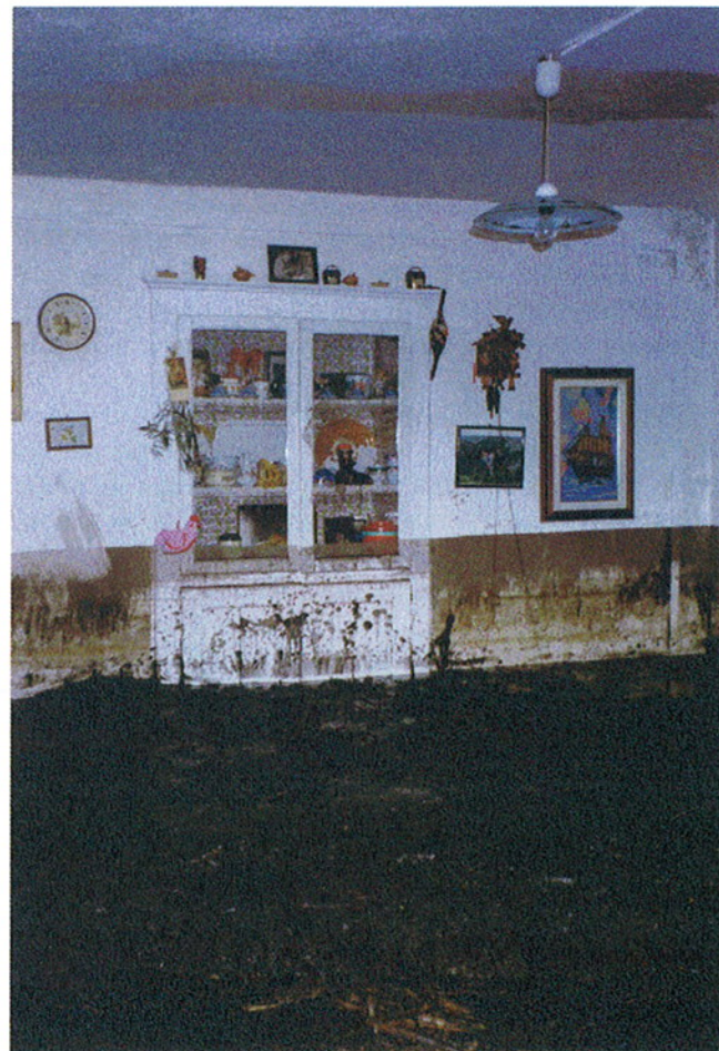
Fig. 7. Omegna, Rio S. Rocco. Interno di uno degli edifici posti in apice di conoide. Visibile sul muro il livello raggiunto dall'acqua.
