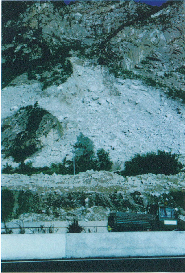
Fig. 3. Baveno, località Cava "Locatelli". Il macereto di blocchi residuo delle attività di coltivazione del secolo scorso è franato parzialmente lasciando un'ampia corona instabile. Il materiale, unitamente ad altri apporti, ha invaso la corsia sud dell'autostrada A26 Voltri-Sempione, causandone l'interruzione temporanea.
