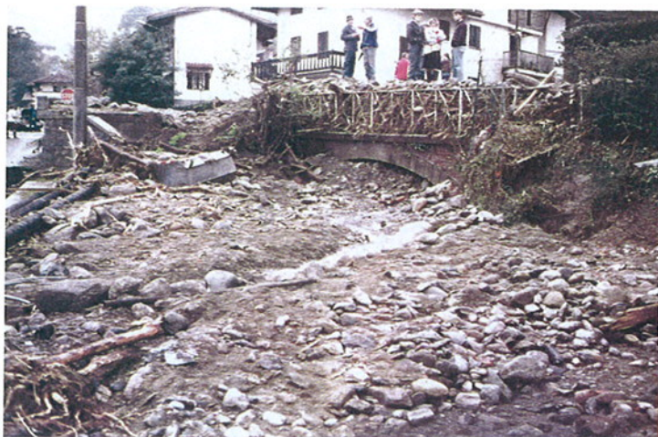
Fig. 104. Comune di Colletterto Giacosa. Particolare del ponte lungo la strada provinciale di collegamento Ivrea-Castellamonte ostruito e sormontato dai materiali mobilitati.
