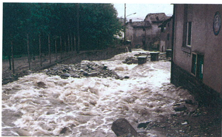
Fig. 106. Comune di Colletterto Giacosa, località Capoluogo. Ripresa delle acque di piena che hanno invaso e gravemente danneggiato la viabilità principale ed alcune abitazioni (poco a valle di fig. 98).
