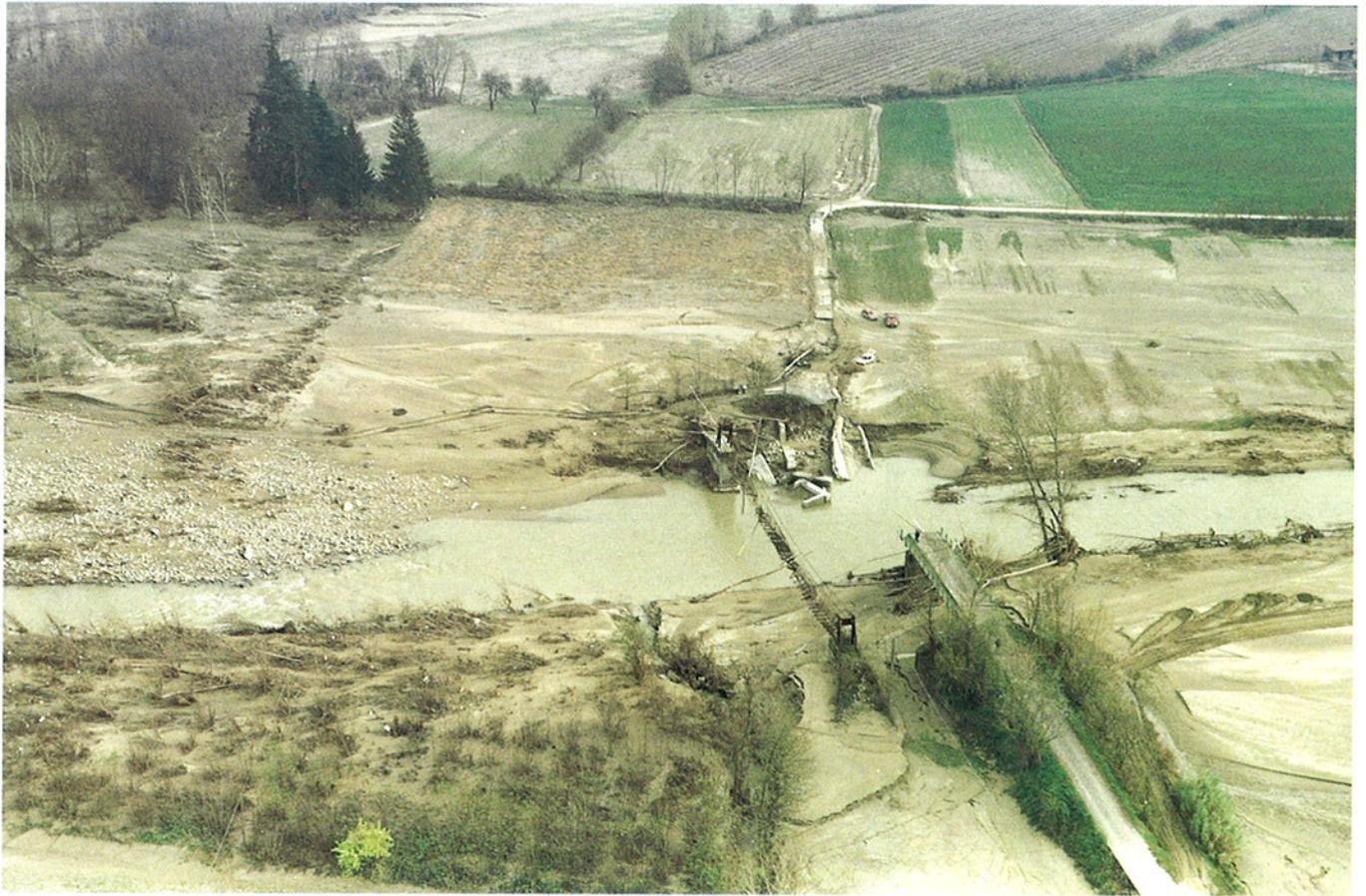
Fig. 70. Fiume Bormida di Millesimo. La distruzione della spalla destra ha provocato, a Quartino, la caduta dell'impalcato del ponte; il manufatto è stato sospinto a valle per 3 km.
