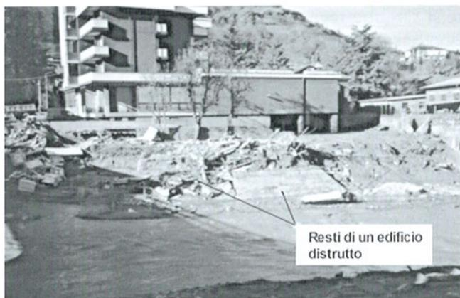
**Fig. 84.** Santo Stefano Belbo. Così si presentava il tratto del T. Belbo, immediatamente a valle del ponte cittadino, nei giorni successivi il 6 novembre 1994. Si osservano i ruderi di un edificio posto in prossimità del ponte, completamente asportato dalla piena (foto Imprudente).
