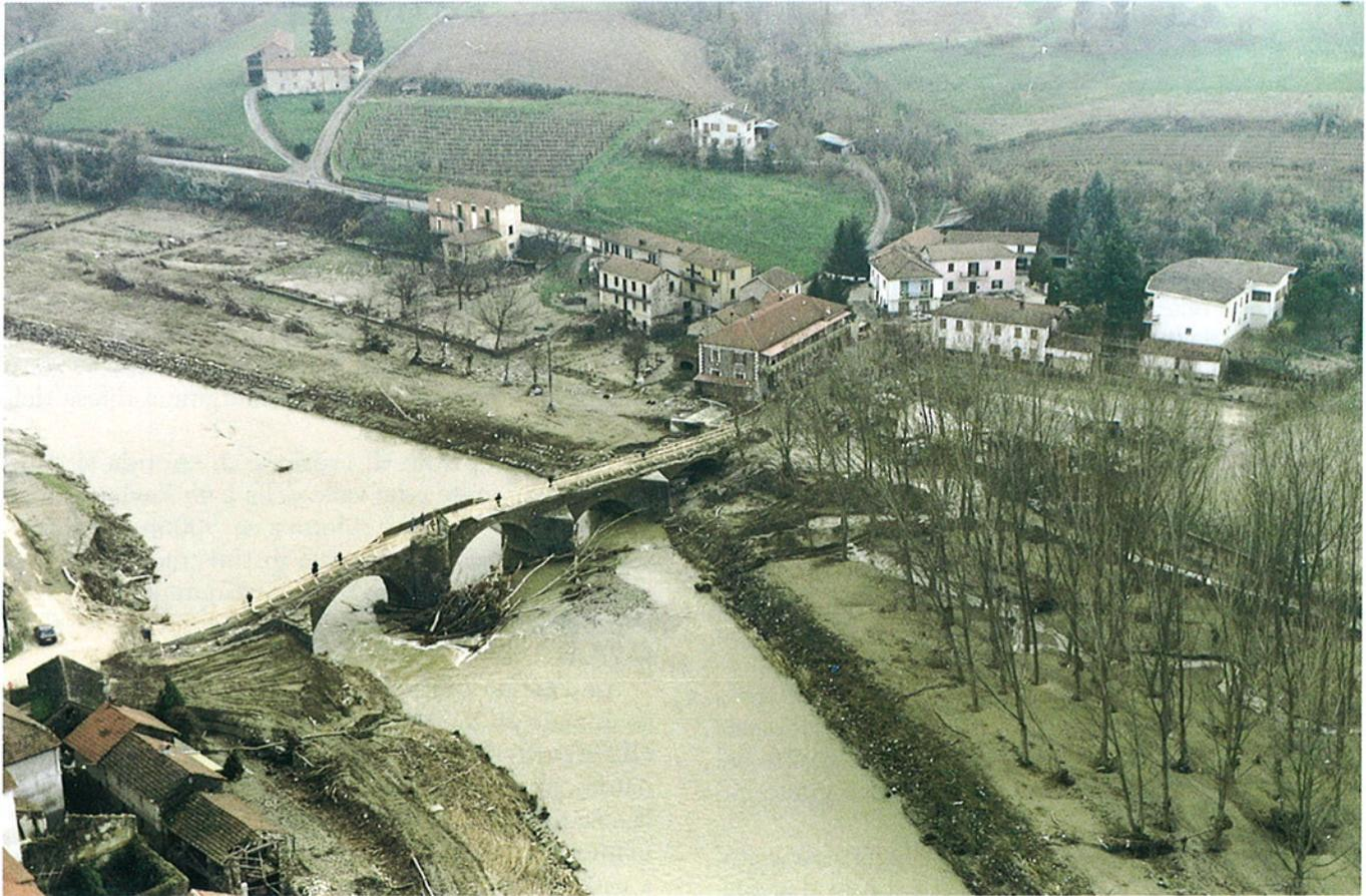
Fig. 72. Fiume Bormida di Millesimo. Lo storico ponte "Romano" di Monastero Bormida è stato completamente sormontato, a causa della presumibile ostruzione da parte di vegetazione arborea come quella visibile poco a monte sulla destra dell'attraversamento.
