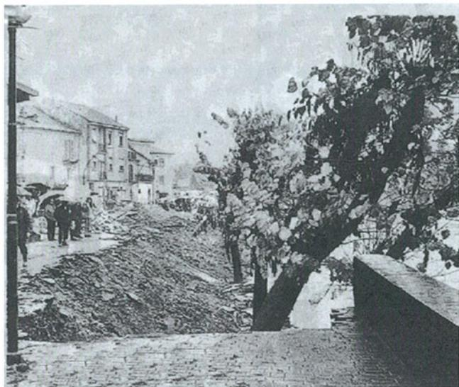
**Fig. 88.** Nizza Monferrato. Parte del muro arginale lungo Via F. Cirio asportato dal T. Belbo (foto da "La Nuova Provincia", 11-11-1994).
