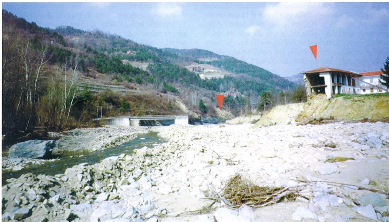
**Fig. 81.** Località Pedanca del Bulla (Bosia). La foto, scattata da monte, testimonia l'intensa attività erosiva del T. Belbo, operata soprattutto a scapito della sponda destra. Sullo sfondo è visibile un ponte di cui è stato completamente asportato il rilevato d'accesso.
