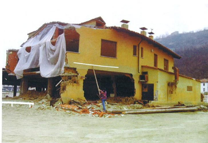
Fig. 83. Zona industriale, discoteca. Altezza delle tracce lasciate dalla piena del T. Belbo, indicata dalle frecce (superiore ai tre metri). I simboli sul piano campagna prossimo alla discoteca indicano la posizione della sponda modellata per erosione laterale durante il passaggio della piena.
