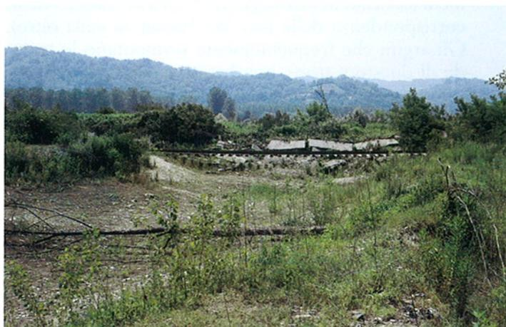
Fig. 56. Rilevato ferroviario della linea Chivasso-Asti asportato per un tratto di circa 300 metri in prossimità di San Sebastiano da Po.
