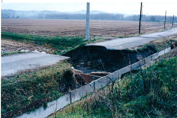
Fig. 59. Balzola. Novembre 1994: rilevato stradale asportato.
