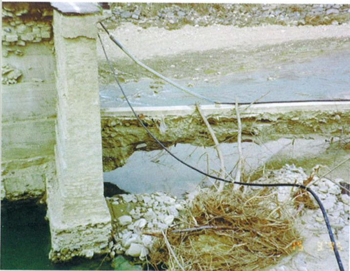
Fig. 82. Cossano Belbo. Ponte sul torrente Belbo: particolare del rilevato d'accesso asportato e della difesa spondale sottoscalzata.
