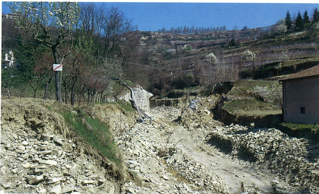
Fig. 64. Fiume Bormida di Millesimo. La violenta attività torrentizia di un tributario di sinistra, in prossimità di Gorzegno, ha provocato sul conoide la distruzione di un ponte della strada statale n. 339.
