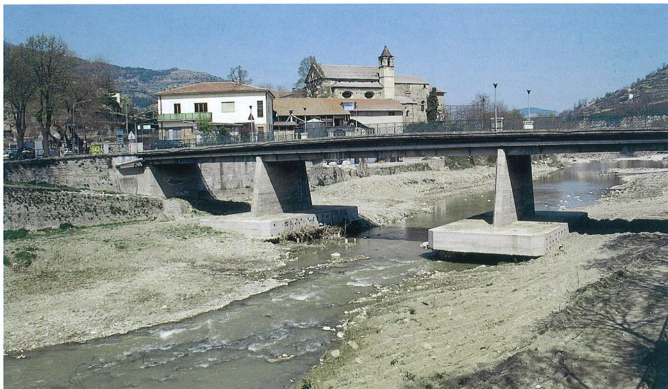
**Fig. 67.** Comune di Cortemilia, fiume Bormida di Millesimo. L'attività erosiva connessa con la piena fluviale del novembre 1994 ha reso evidente le modificazioni del letto del canale in corrispondenza del ponte centrale dell'abitato.
