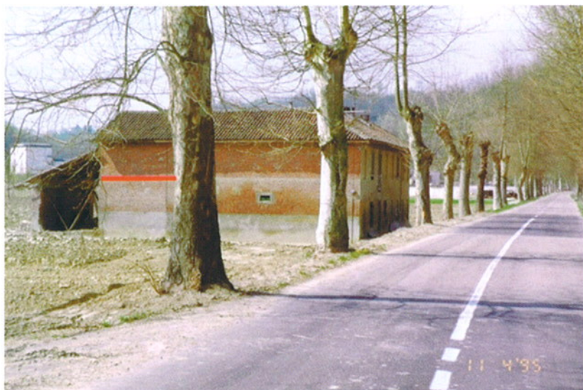
Fig. 40. Comune di Castello d'Annone. Provinciale per Rocca d'Arazzo, in prossimità del ponte (sponda destra). Sul muro dell'edificio in secondo piano viene indicata (linea rossa) l'altezza delle acque di inondazione; a sinistra si osserva un basso caseggiato distrutto dalle acque (direzione di deflusso verso l'osservatore).
