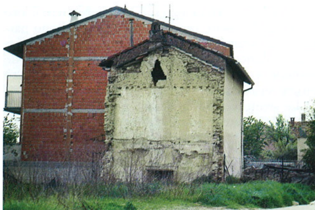
Fig. 51. Alessandria, Rione Orti, novembre 1994. Edificio in mattoni crudi crollato in parte dopo la piena.
