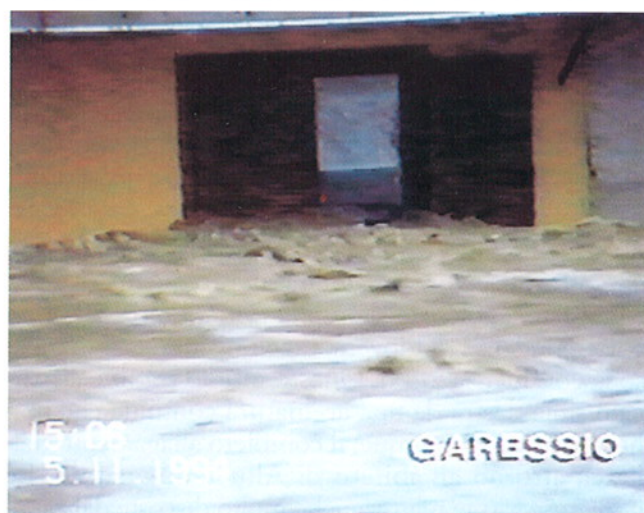
Fig. 7. Comune di Garessio, concentrico. Alle ore 15 del 5 novembre i locali del centro storico contigui al fiume sono allagati da oltre 1,5 m d'acqua (C.R.I. - Studio Levi).
