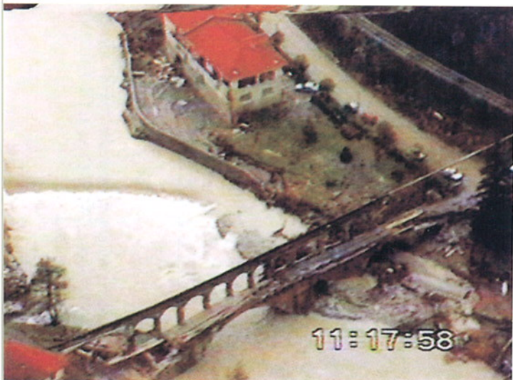
Fig. 8. Comune di Bagnasco, località Ponte Romano. Nella immagine ripresa da elicottero, nei giorni seguenti la piena, è visibile il vecchio attraversamento, le arcate inutilizzabili da interrimento antropico, i danni al manufatto e alla sponda sinistra e, infine, la restrizione dell'alveo a monte indotta da interventi antropici.
