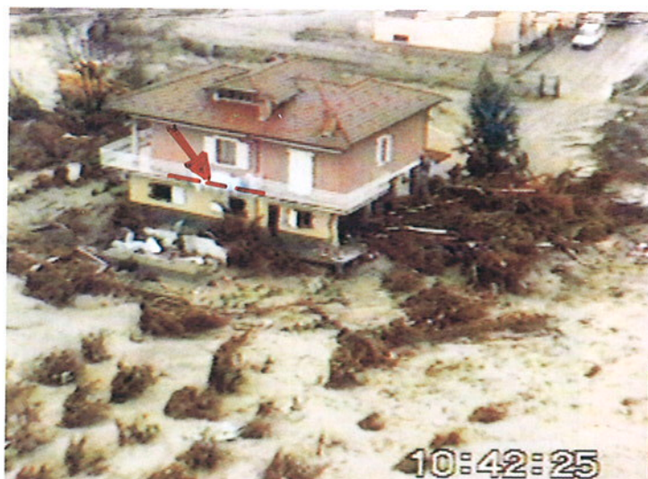
Fig. 9. Comune di Ceva, località Nosalini. L'immagine mostra i gravi danni subiti da uno degli edifici posti in questo luogo: la violenza dell'urto del materiale arboreo fluitato ha provocato la distruzione delle pareti laterali della casa. È evidenziato il livello raggiunto dall'acqua, pari a 3.5 m ca.
