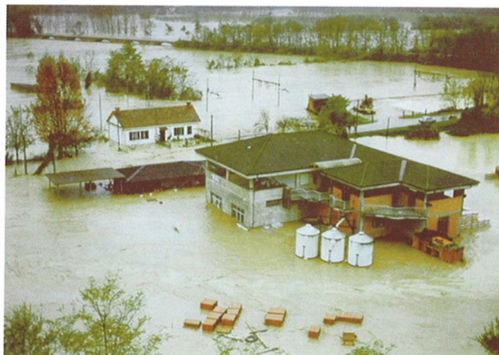
Fig. 43. Comune di Castello d'Annone. Fiume Tanaro. Veduta in direzione del ponte della S.P. Castello d'Annone-Rocca d'Arazzo la mattina del 6-11-1994.
