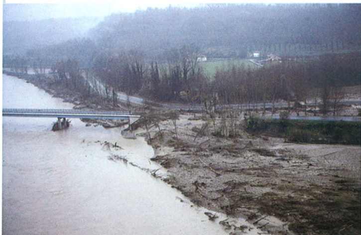
Fig. 52. Fiume Tanaro: strada provinciale n. 12 "Fondovalle", tratto Farigliano-Cherasco. Esempio di asportazione completa, per erosione fluviale, di due tratti di rilevato contigui a ponti.
