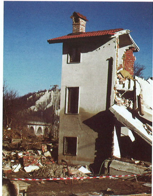
Fig. 23. Comune di Clavesana, località La Generala: sugli edifici del nucleo abitato, in parte distrutti dalla violenza della piena, è visibile il livello raggiunto dal pelo libero dell'acqua.
