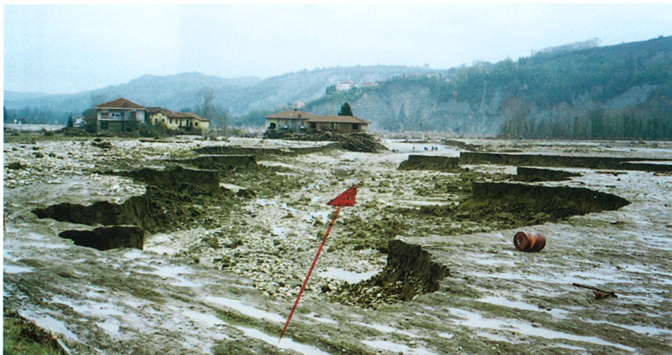
Fig. 21. Comune di Clavesana, località Gerino. Il canale di neoformazione che ha tagliato l'ansa di meandro alle spalle del nucleo abitato in una ripresa dalla traversa di derivazione.
