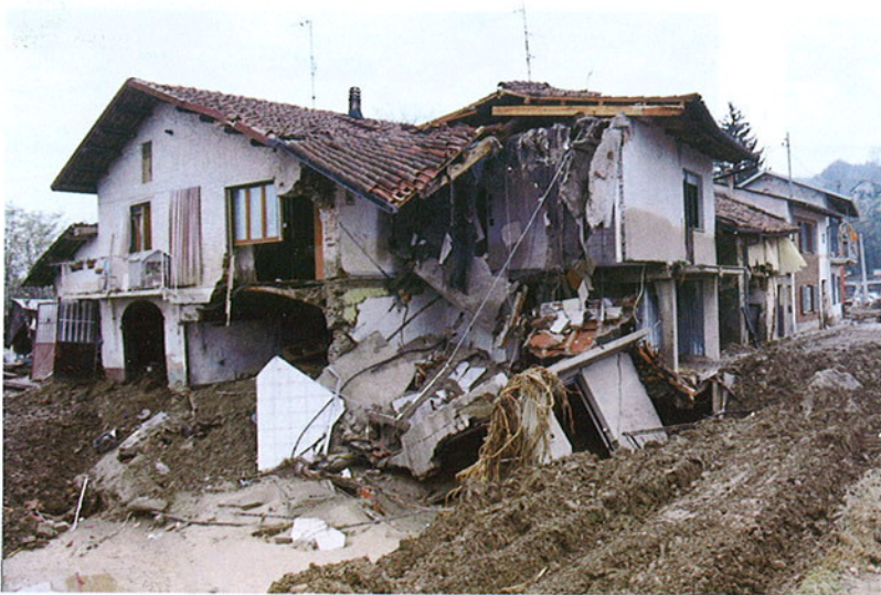
Fig. 23. Comune di Clavesana, località La Generala: sugli edifici del nucleo abitato, in parte distrutti dalla violenza della piena, è visibile il livello raggiunto dal pelo libero dell'acqua.
