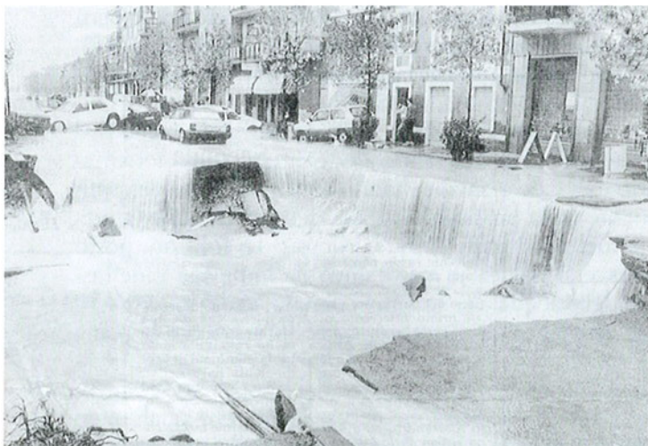
Fig. 36. Città di Asti. Corso Savona durante la fase di riflusso della piena. Si osservi l'ampio tratto di strada asportato e le automobili trascinate e accatastate dalle acque (foto La Nuova Provincia, 9-11-1994).
