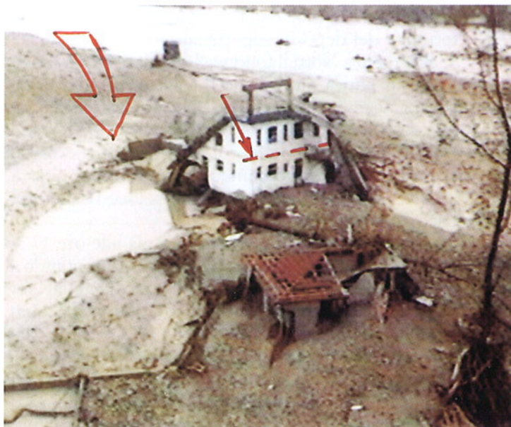
Fig. 27. Comune di Farigliano Località Molino. Immagine aerea dell'area sportiva comunale: del campo da calcio non rimane traccia, gli edifici di servizio sono quasi interamente distrutti. Sulle pareti chiare delle gradinate è visibile il livello raggiunto dal pelo libero dell'acqua prossimo ad un'altezza di circa 5 m.
