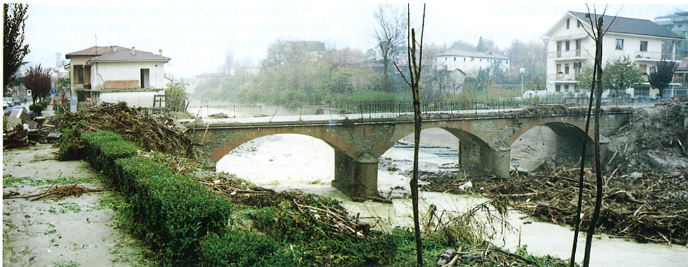
Fig. 2. Comune di Dogliani. Ponte sul torrente Rea poco a monte del concentrico. Sono evidenti i segni del sormonto per occlusione dell'attraversamento.
