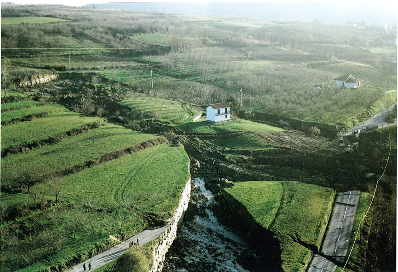
Fig. 5. Comune di Feisoglio. La strada di accesso all'abitato e l'edificio al centro della foto hanno subito traslazione a causa di una frana per scivolamento planare.
