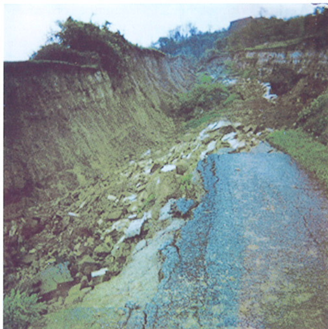
Fig. 7. Comune di Roccaverano, reg. Giorgino. Nicchia di distacco dello scivolamento planare e danni arrecati alla viabilità.
