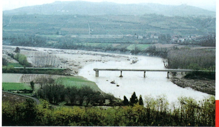
Fig. 4. Comune di Piozzo. La completa erosione del rilevato di sinistra del ponte Macagno, sul fiume Tanaro, ha provocato, la sera del 5 novembre 1994, la morte di 7 automobilisti.
