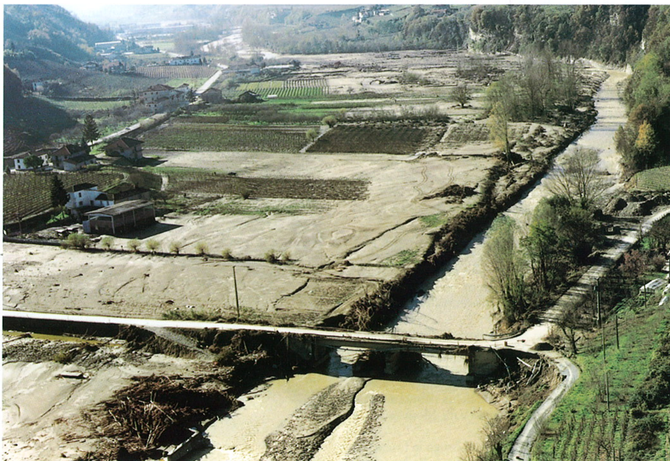
Fig. 3. Torrente Belbo. Dalla immagine si desume con chiarezza l'ampiezza del campo di inondazione della piena torrentizia del 1994.
