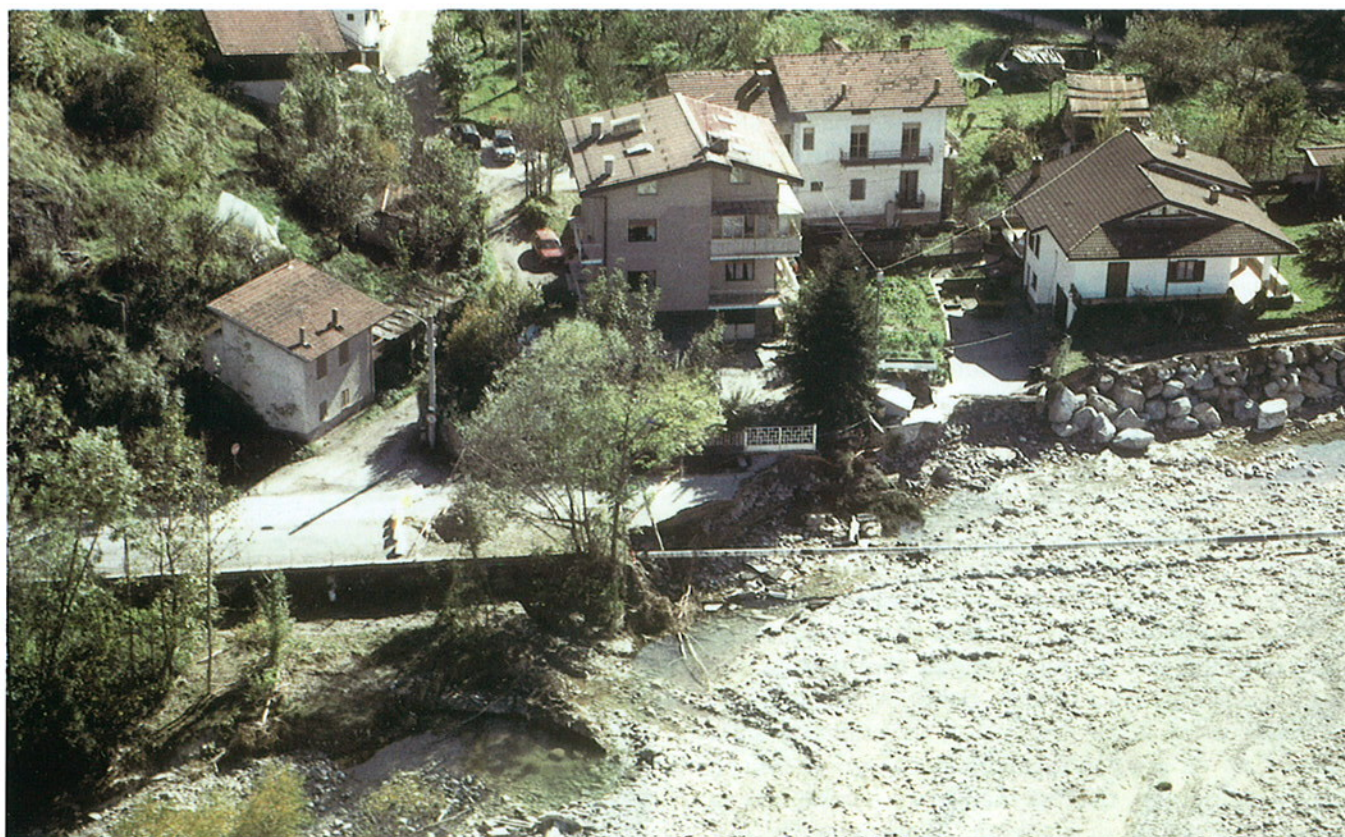
Fig. 10. Comune di Roccavione, Frazione T. Polonghera. Accentuata erosione in sponda destra del T. Vermenagna, con asportazione della sede stradale (S.P. n. 21) e dei terreni antistanti un'abitazione (prontamente difesa da scogliera in blocchi). Il tracciato della preesistente strada è riconoscibile dall'adiacente tubazione dell'acquedotto rimasta in loco.
