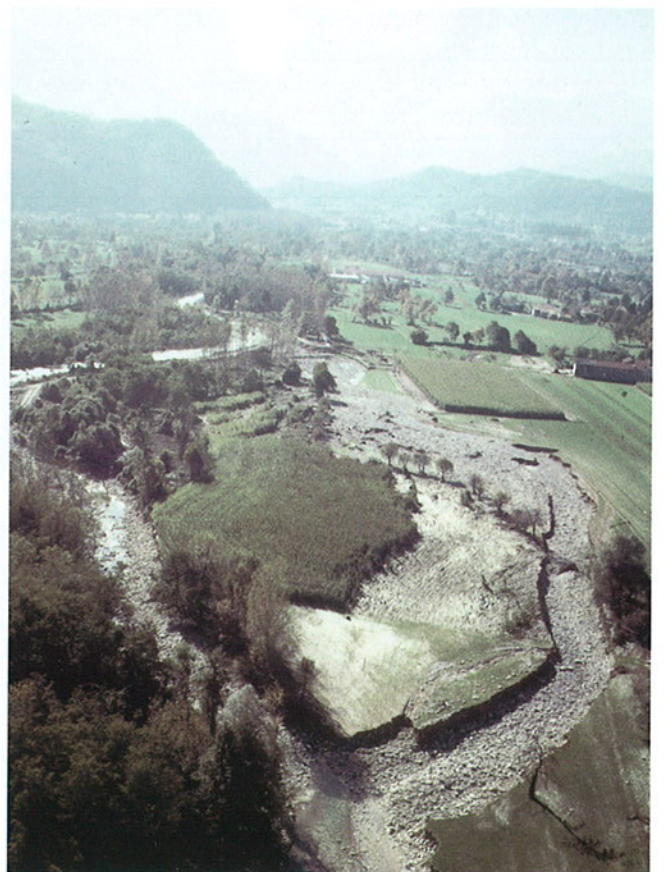
Fig. 12. Torrente Pesio. Ripresa aerea degli effetti erosivi provocati dalle acque di esondazione.
