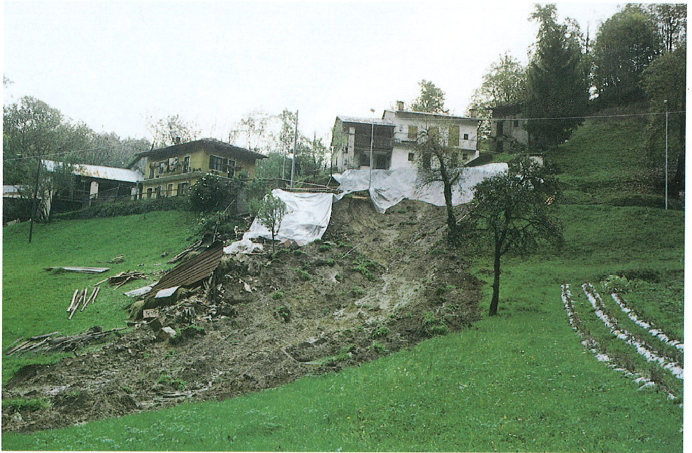
Fig. 15. Comune di Chiusa di Pesio, località Tetti Fiolera. Frana rotazionale evoluta in colata in terreni di riporto e di copertura. Il dissesto ha determinato l'asportazione di una strada privata e il crollo di un fabbricato non abitativo.
