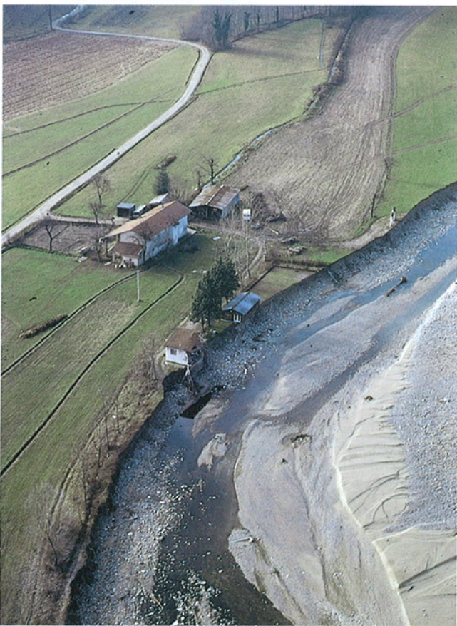
Fig. 3. Comune di Cuneo, loc. Pecollo. L'ampia erosione laterale operata dal t. Stura di Demonte ha provocato la distruzione di un edificio.
