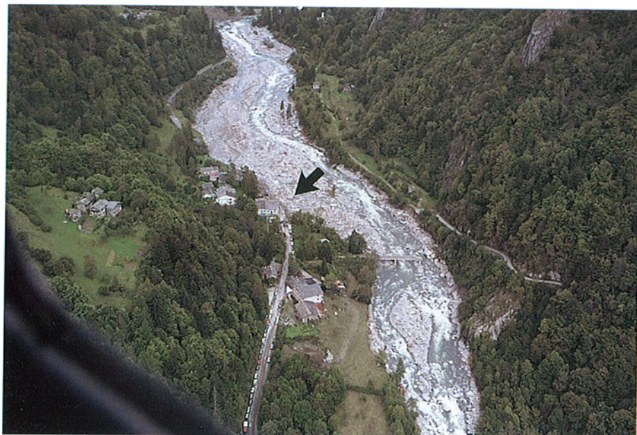
FOTO 27 - Frazione Villanova nel Comune di Ronco (TO); in primo piano il ponte per la frazione Crotto, parzialmente asportato insieme ad un tratto della strada di collegamento. La freccia indica la localizzazione approssimativa degli edifici asportati dall'erosione spondale in destra idrografica.
