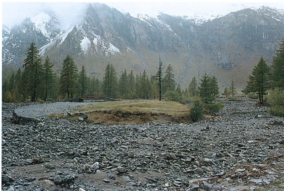
FOTO 66 - Comune di Balme (TO): località Pian della Mussa. Riattivazione dei locali conoidi che hanno provocato un generale sovralluvionamento del fondovalle, divagazioni dei corsi d'acqua ed interruzioni in più punti della S.P. 1.
