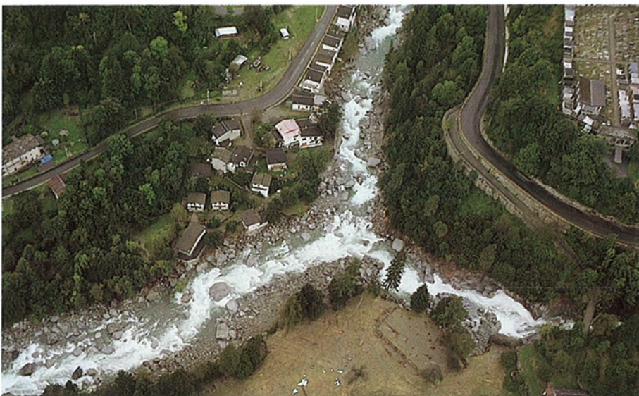
FOTO 30 - Ronco, zona Bettassa. Il T. Forzo è in alto, il T. Soana scorre da destra verso sinistra. La posizione critica di alcune delle abitazioni è evidente.
