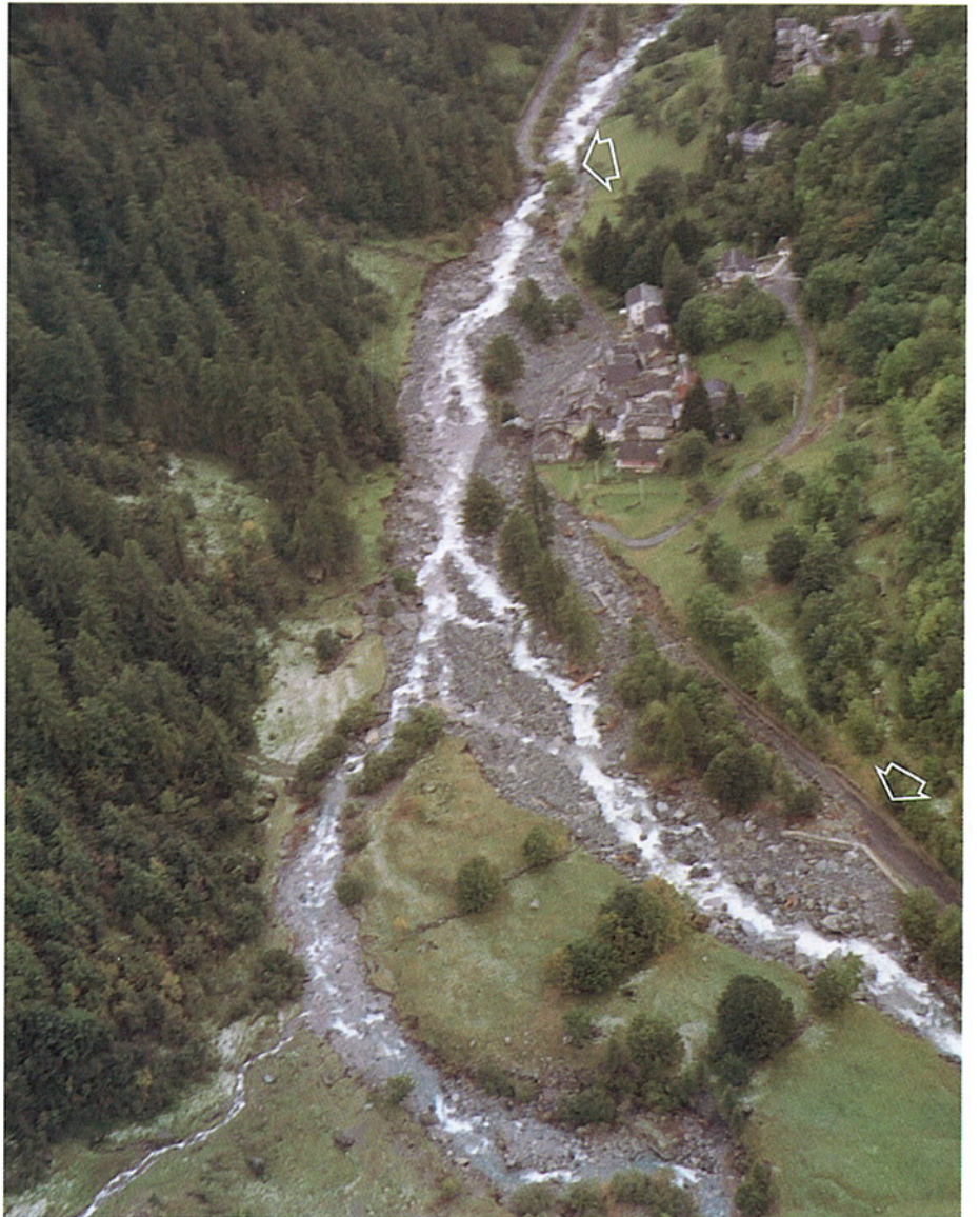
FOTO 37 - Valprato, frazione Ronchietto. Nel tratto compreso tra le due frecce la Strada Provinciale è stata sovrascorsa ed asportata quasi totalmente. Senso corrente dal basso verso l'alto.
