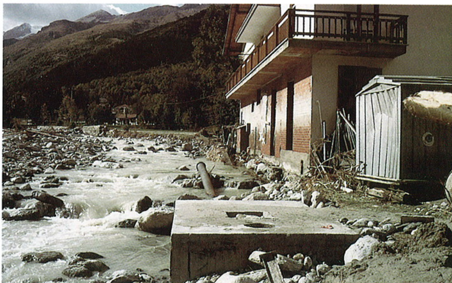
FOTO 58 - Comune di Chialamberto (TO): località Bussoni. Edificio di civile abitazione, ubicato lungo l'alveo di piena ordinaria del T. Stura. L'edificio è stato circondato dalle acque nel corso dell'evento alluvionale del settembre 1993.
