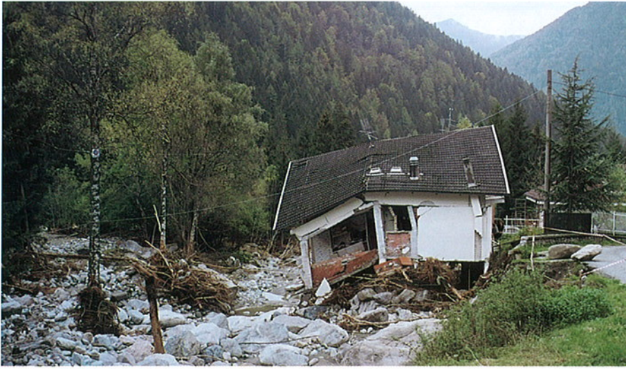
Foto 33 - Abitazione distrutta di cui alla foto precedente.
