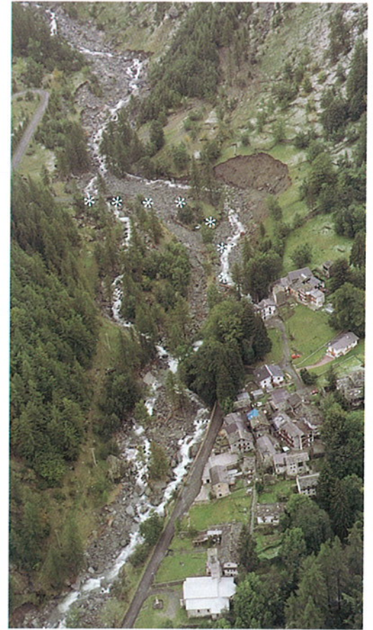
FOTO 39 (a destra) - Valprato, frazione Pianetto. Gli asterischi indicano il tracciato approssimativo della Strada Provinciale, totalmente ricoperta di detriti insieme a due ponti. In alto a destra si nota un'ampia frana di sponda.
