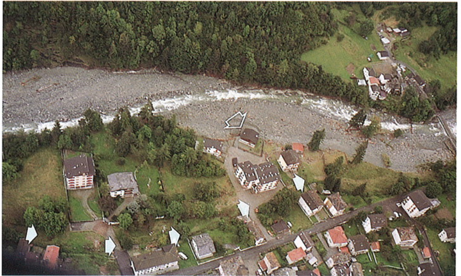
FOTO 36 - Valprato; a destra il ponte danneggiato per Zurlera. La freccia bianca in alto indica un'abitazione danneggiata, ubicata in alveo. Le frecce in basso indicano un ramo d'alveo riattivato senza trasporto solido.
