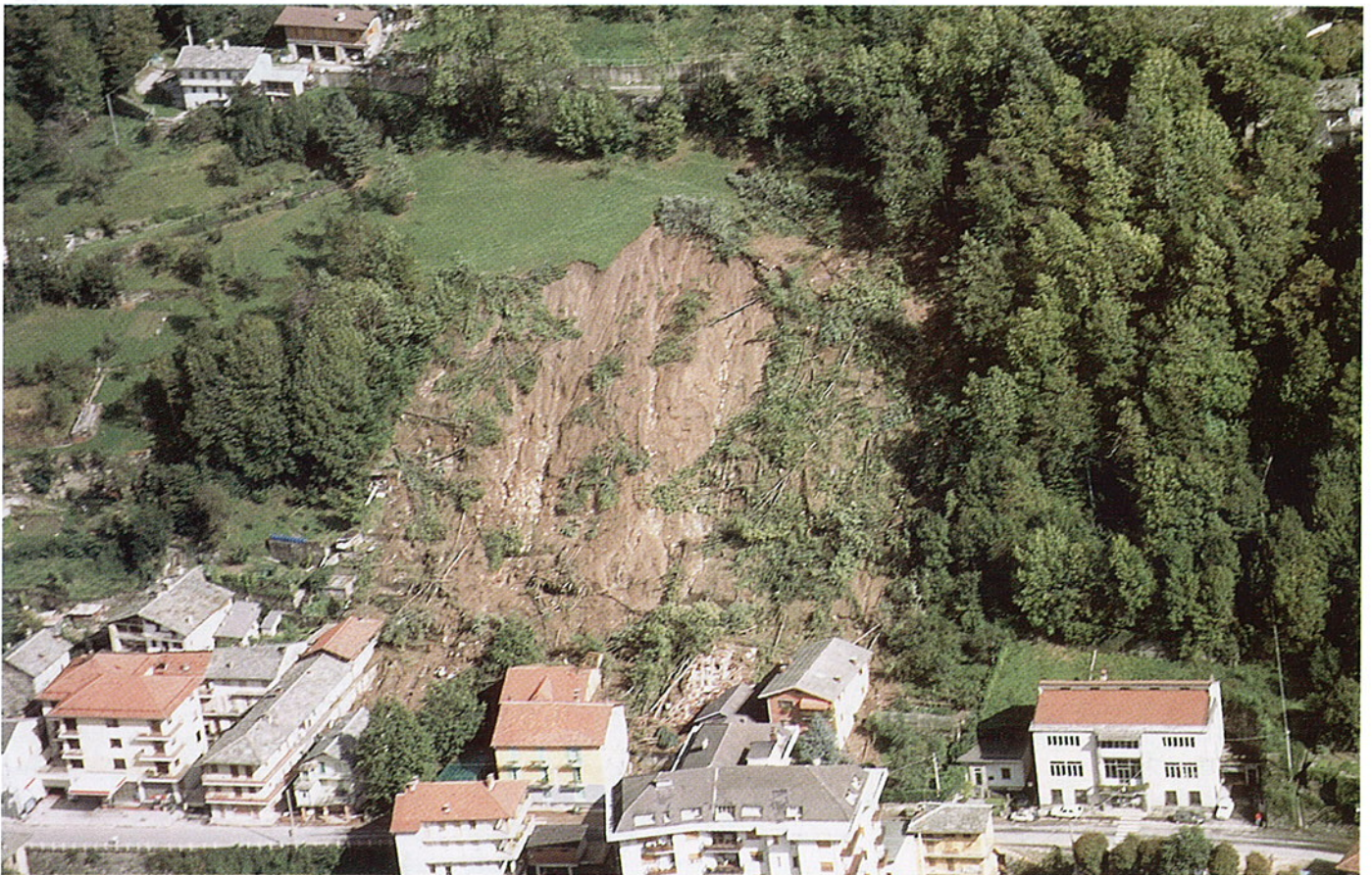
FOTO 64 - Comune di Pessinetto (TO): frana in località Municipio. Il dissesto ha pesantemente coinvolto alcuni edifici di civile abitazione. Due di essi sono stati completamente distrutti.
