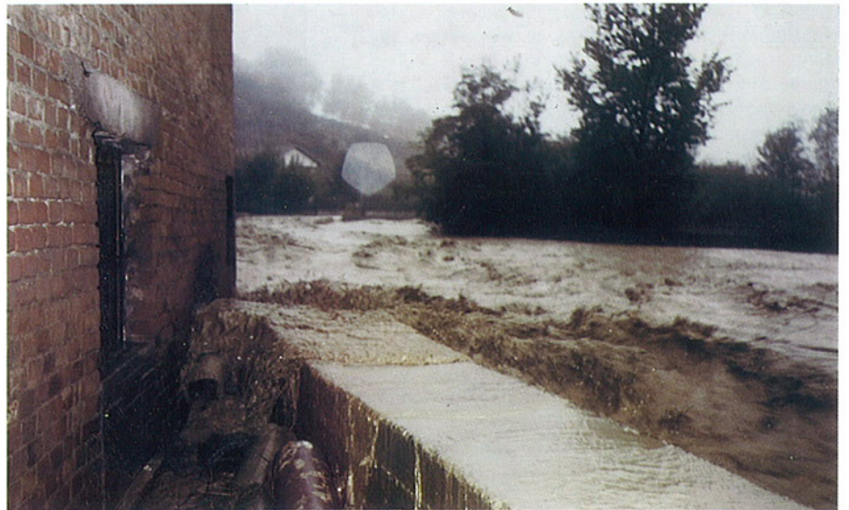
Foto 90 - Villalvernia (AL). Tracimazione dell'opera di difesa del concentrico durante la piena.
