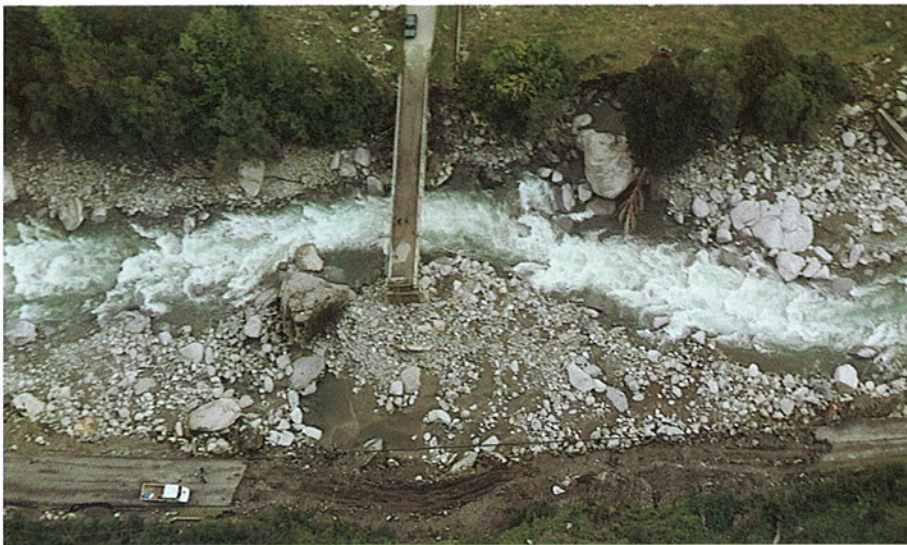
FOTO 29 - Ronco, ponte per la frazione Montelavecchia; il rilevato di accesso alla spalla destra del ponte è stato aggirato ed asportato delle acque di piena, unitamente ad un tratto di Strada Provinciale.
