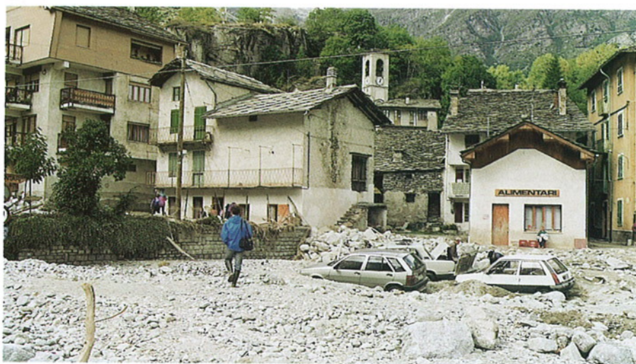
Foto 71 - Comune di Groscavallo (TO). Frazione Forno Alpi Graie: la piazza centrale del paese invasa dai depositi detritici grossolani lasciati dalle acque del T. Stura nel corso della piena.
