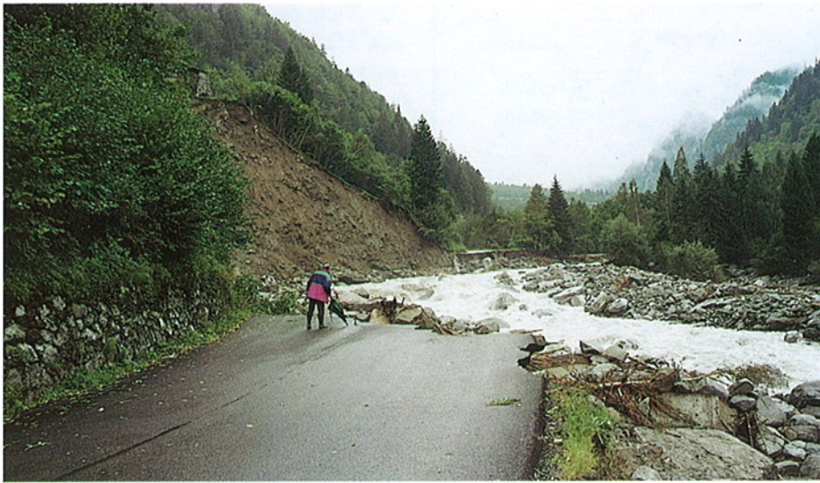
FOTO 28 - Frazione Villanova nel Comune di Ronco, tratto asportato della Strada Provinciale. A sinistra l'ampia frana di sponda per erosione al piede.
