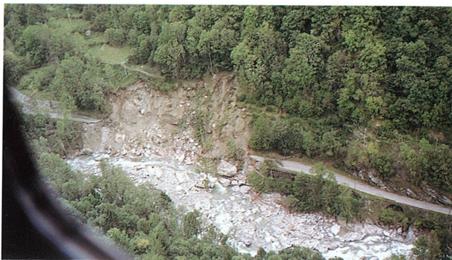
Foto 43 - Strada Provinciale Sparone-Ribordone, interrotta da una frana per scalzamento al piede.
