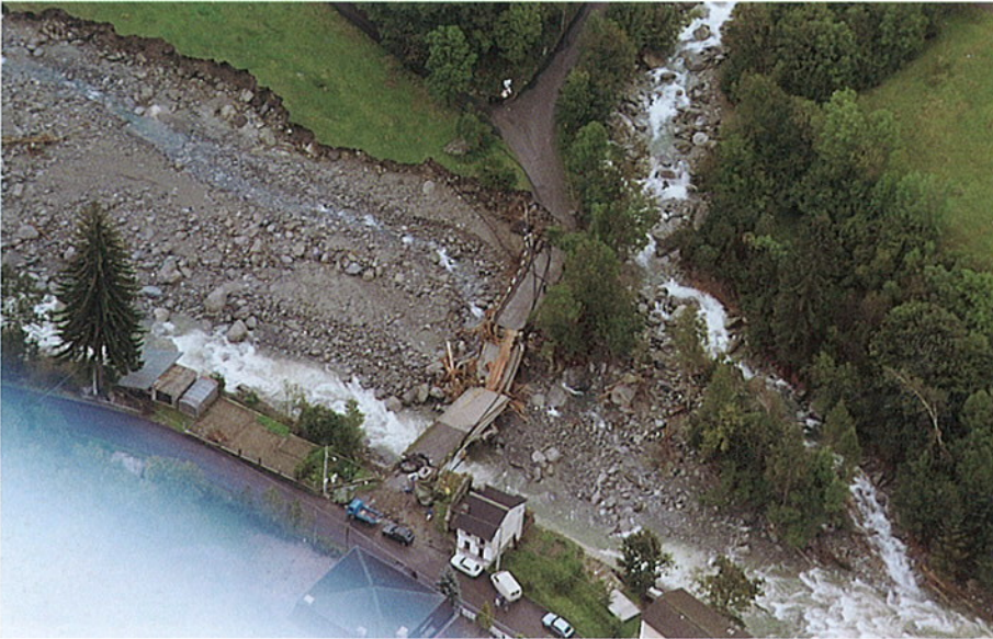
Foto 34 - Ronco, ponte di collegamento per la borgata Cernisio, distrutto.
