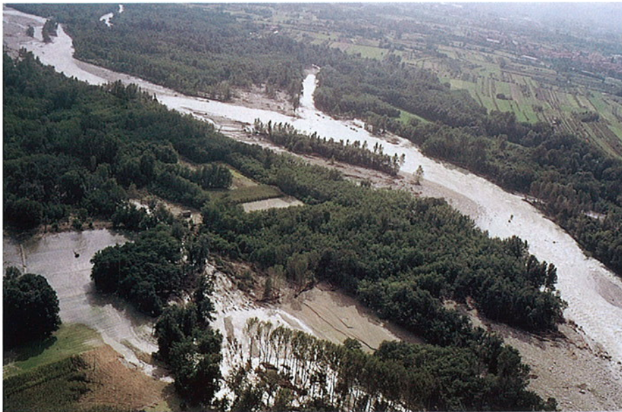
Foto 46 - T. Orco nel tratto a modellamento pluricursale (deflusso da destra verso sinistra), in corrispondenza della confluenza con il Gallenga (sponda destra). In sponda destra sono visibili alcuni canali riattivati durante la piena del 23-24 settembre, mentre in sinistra si osservano incisioni in corrispondenza di forme fluviali rimaneggiate da pratiche agricole, ma ancora individuabili da aerofotografie.
