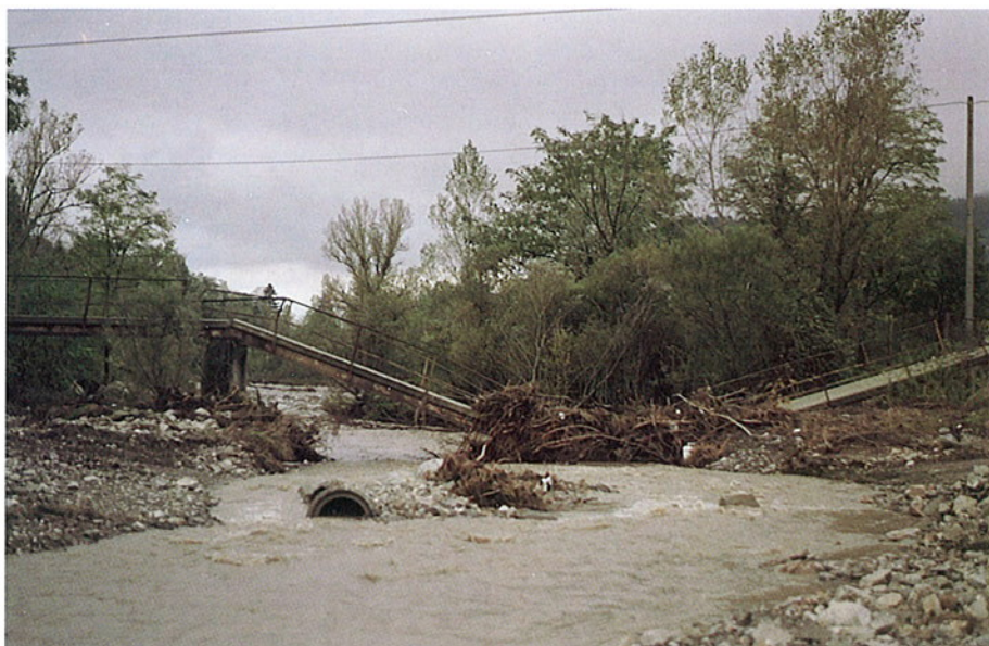
FOTO 89 - Dernice (AL). Ponte di accesso alla Frazione Cà di Marco.
