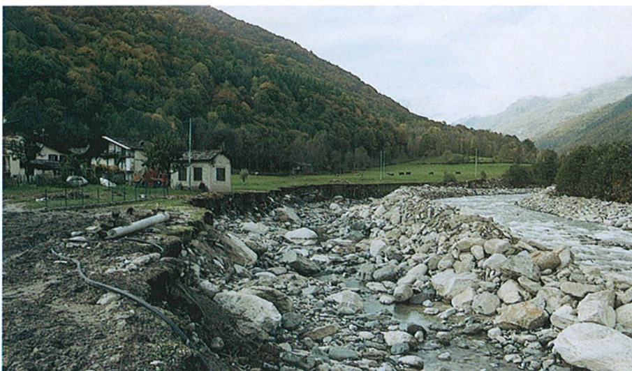
Foto 61 - Comune di Chialamberto: località Inverso. Fenomeno di intensa erosione in sponda destra che ha asportato alcune decine di metri di campi coltivati a prato minacciando gli edifici della frazione Inverso.
