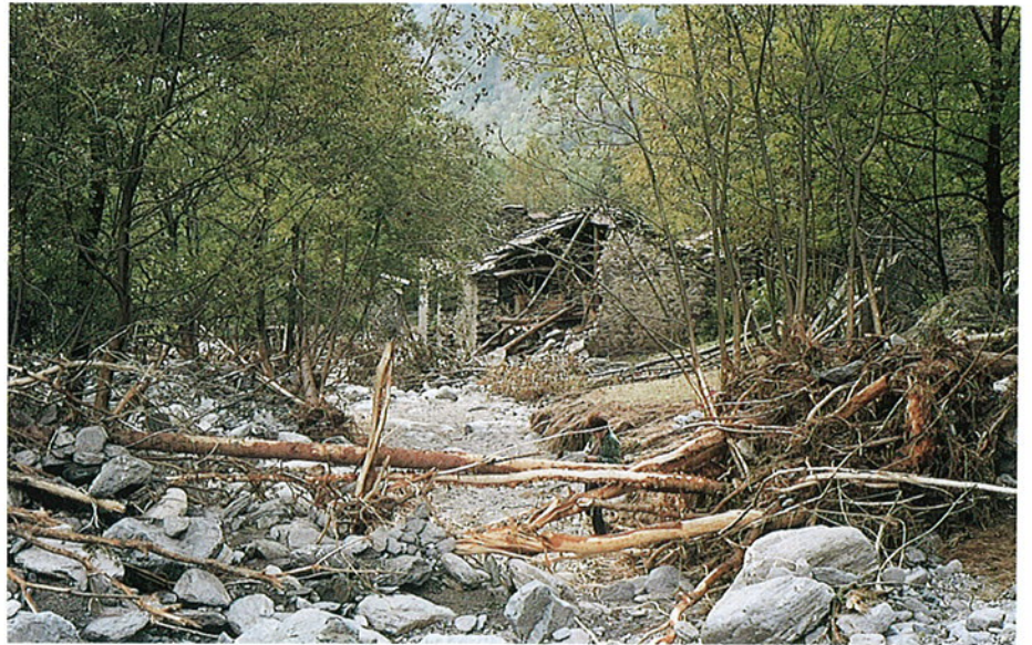
Foto 76 - Incisione del nuovo alveo ed alluvionamenti grossolani, visti da monte di Case Buttiglieria (direzione del deflusso verso l'edificio in secondo piano).
