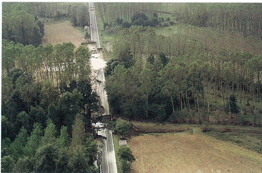
FOTO 55 - Strada Provinciale San Benigno-Fogizzo: parte prossima al ponte, in sponda destra. Si osservino lunghi tratti asportati del rilevato.
