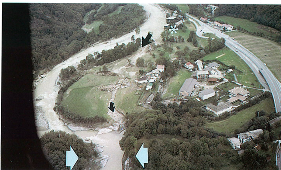
Foto 42 - Pont Canavese (TO), località Pratidonio. Fenomeno di taglio del meandro, indicato dalle frecce nere. Al centro del meandro si notano i resti di un capannone distrutto. L'asterisco indica un gruppo di edifici messo a rischio dall'erosione spondale. Le frecce bianche in primo piano indicano una strettoia in roccia, che favorisce l'innalzamento idrometrico a monte.
