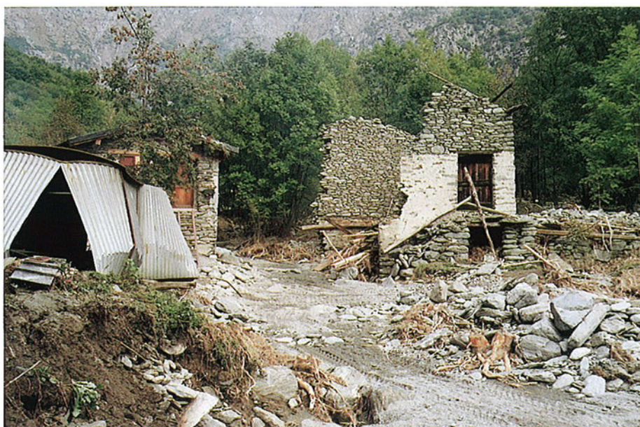
FOTO 75 - Edifici distrutti in località Case Buttigliera (direzione di deflusso verso l'osservatore).
