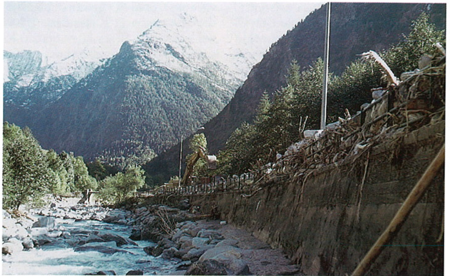
FOTO 11 - Particolare della fotografia 9, che mostra la ristretta e non adeguata sezione dell'alveo. Sulla destra il muro-argine della Strada Statale di circonvallazione invasa dai detriti.
