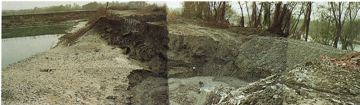
Foto 21 - Particolare del punto B della Foto 20.
