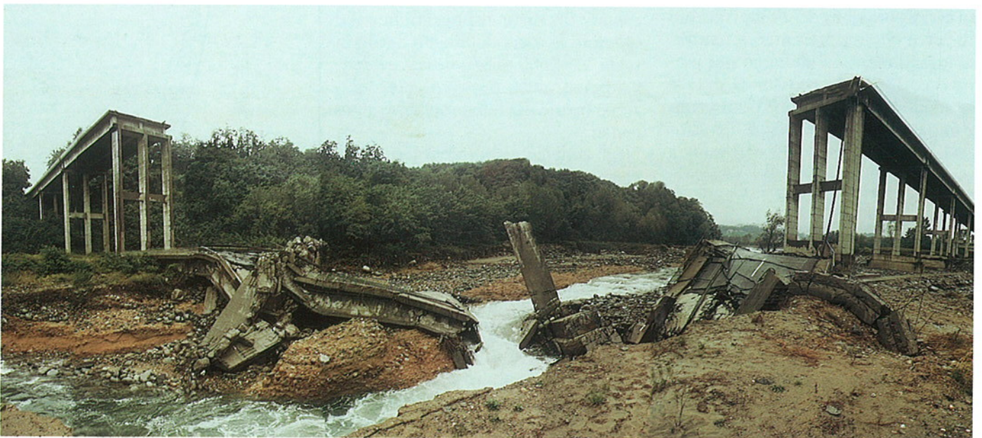
FOTO 16 - Vista da valle del ponte-viadotto sulla S.S. 142. in primo piano il canale, inciso fino al substrato Villafranchiano dalla piena, che ha determinato il convogliamento di gran parte dei deflussi in questo settore causando, per erosione delle fondazioni, il crollo dei due piloni. Tale canale si è inciso in pochi minuti, nel corso della piena, riprendendo il canale visibile sulla foto precedente. Sulla destra dell'immagine la soglia di stabilizzazione non più sede di deflussi.
