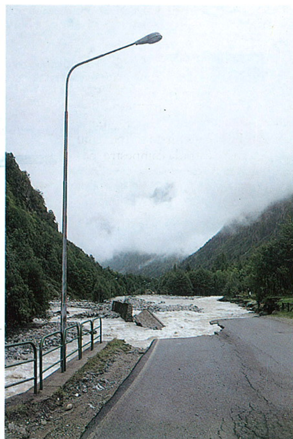
FOTO 10 - Vista da monte del tratto di circonvallazione asportato.
