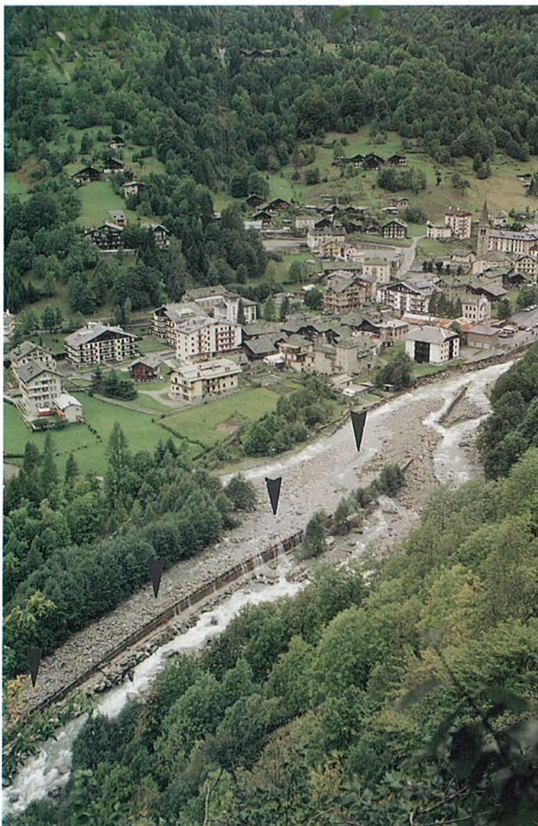
FOTO 9 - Vista dall'alto dell'alveo del Sesia poco dopo la piena, in corrispondenza di Alagna. Si noti il forte restringimento causato dalla costruzione della Strada Statale di circonvallazione dell'abitato (indicata dalle frecce). Per confronto con la fotografia precedente si evidenzia come l'attuale alveo si sia configurato, nonostante il condizionamento, in modo del tutto simile a quello di cinquanta anni prima.
