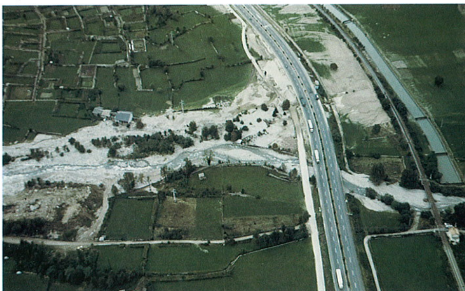
FOTO 26 - Conoide del Torrente Renanchio, settore di raccordo con fondovalle. Sono visibili in sponda sinistra le due abitazioni lesionate, la strada comunale alluvionata e l'espansione della colata nel tratto compreso tra l'autostrada ed il canale artificiale.
