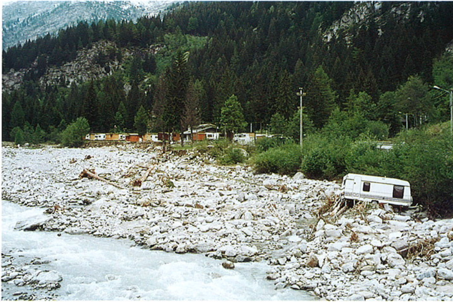
FOTO 5 - Macugnaga, località Isella; campeggio danneggiato e parzialmente asportato dalle acque di piena.
