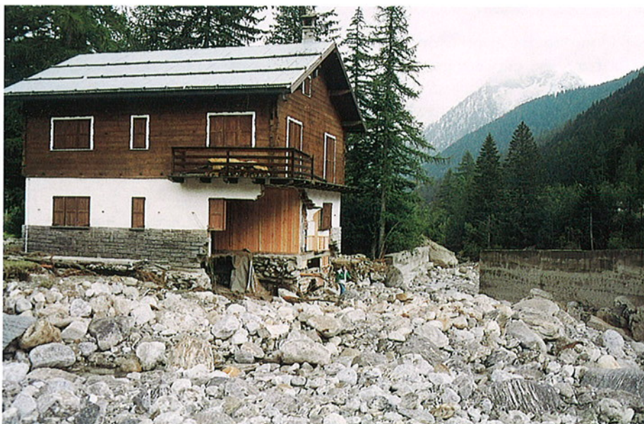
Foto 4 - Macugnaga (VB), località Pecetto; abitazione danneggiata dalle acque di piena che hanno aggirato un'argine in muratura (a destra nella foto).
