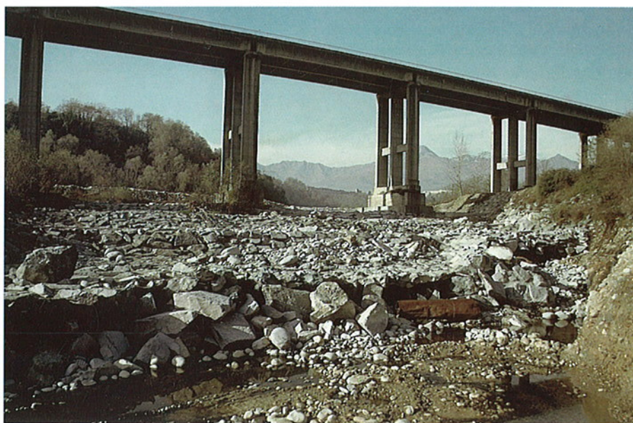
FOTO 14 - Vista da valle della soglia di stabilizzazione costruita a difesa del ponte-viadotto della S.S. 142 e delle varie fasi di consolidamento con controbriglie in conseguenza degli intensi processi erosivi attestati ai suoi piedi.
