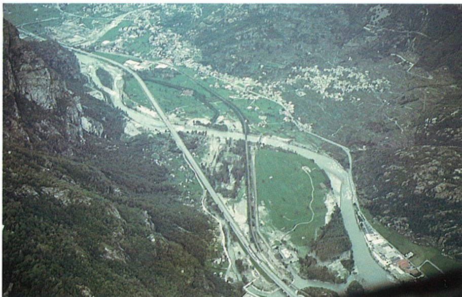
Foto 19 - Fiume Dora Baltea a nord di Quincinetto: canale laterale attualmente regimato attraversato dal rilevato autostradale. In primo piano si osserva il tratto di rilevato ferroviario asportato.
