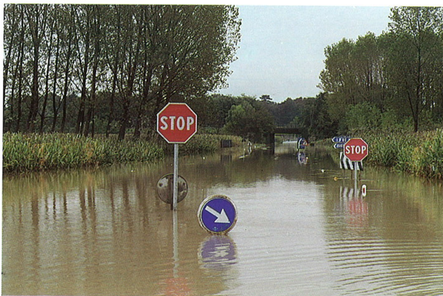
Foto 23 - Strada Provinciale Banchette-Lessolo: foto scattata il 26/9/1993 in fase di ritiro delle acque di inondazione. Sullo sfondo si osserva il sottopasso dove si sono registrate due vittime (foto Tinetti).
