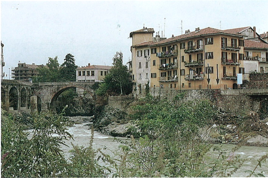
FOTO 24 - Ivrea (TO): le frecce indicano il livello raggiunto delle acque in corrispondenza degli edifici a monte del ponte Vecchio.
