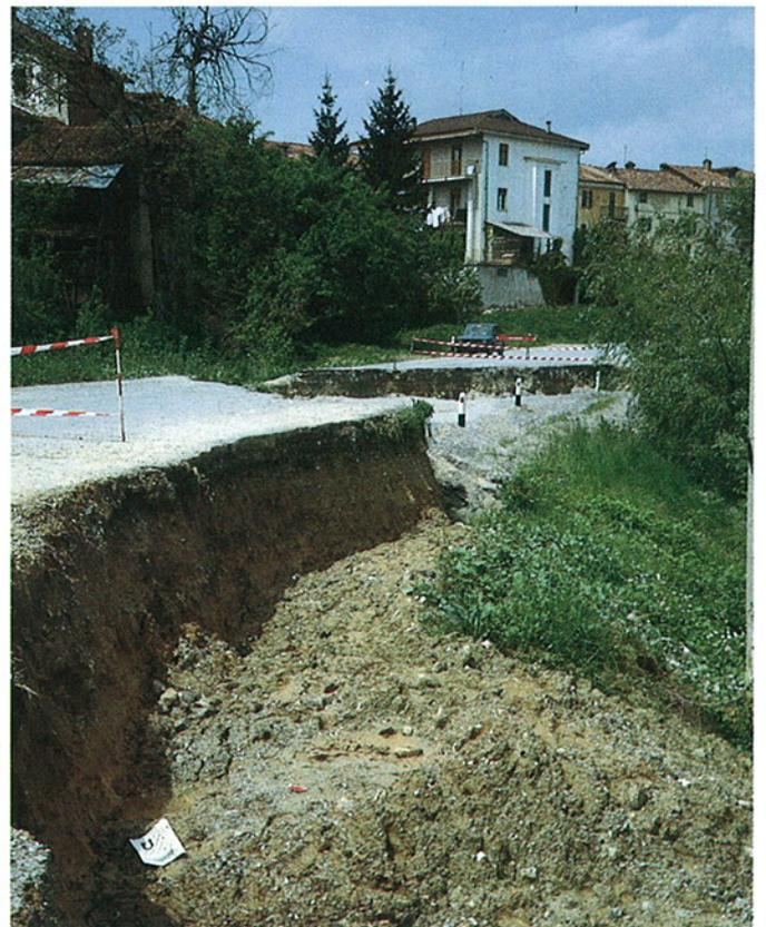
Fig. 36, 36 bis. *Parte sommitale del corpo di frana: configurazione caratteristica determinata da sollecitazioni che inducono un movimento di tipo rotazionale lungo superfici di scivolamento concave.*
