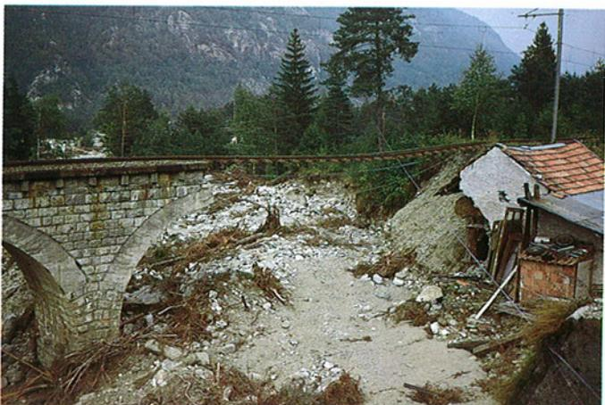
Fig. 50. Ponte ferroviario distrutto in seguito ad una piena straordinaria provocata da un evento alluvionale di particolare intensità.
