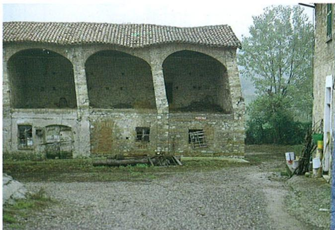
Fig. 52. Danni ai centri abitati: evidenti lesioni ad un fienile provocate da un fenomeno franoso.
