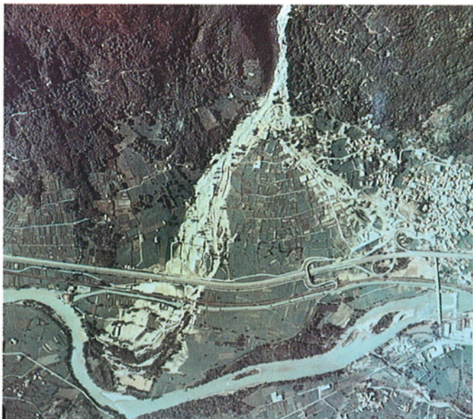
Fig. 4. La conoide del Torrente Renanchio, presso Quincinetto, nella bassa Valle d'Aosta; si nota l'alluvionamento prodotto dal violento fenomeno di trasporto in massa verificatosi il 22 settembre 1981. (Fot. Alifoto).
