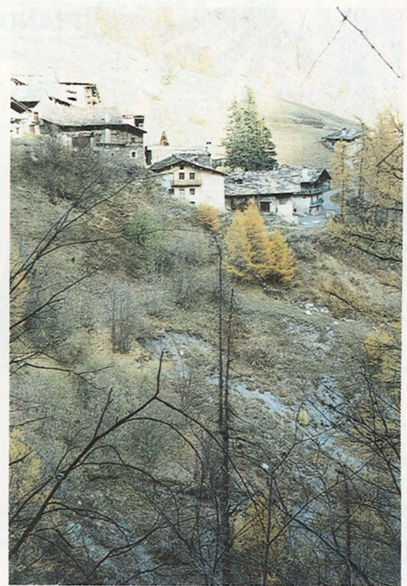
Fig. 1 - Particolare del versante a livello dell'abitato. Al centro della fotografia è l'ex Municipio, in alto a destra una casa isolata seriamente lesionata da movimenti locali della parte di accumulo più prossima all'alveo torrentizio. Tra la fitta vegetazione in primo piano, si distinguono le lacerazioni della coltre erbosa che evidenziano la fine pezzatura del materiale costituente l'accumulo della frana.
