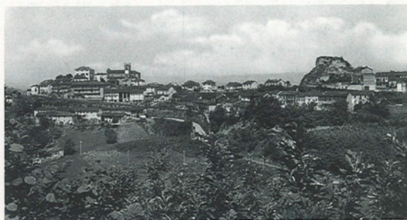
Fig. 2 - Il paese, come appariva prima degli anni 1972-74, quando si decise di sbancare la rocca sulla quale nel secolo scorso sorgeva il castello. La rocca in passato fu coinvolta da numerosi movimenti gravitativi a causa delle erosioni spondali del F. Tanaro (fotografia F.lli Marchia, Asti).
