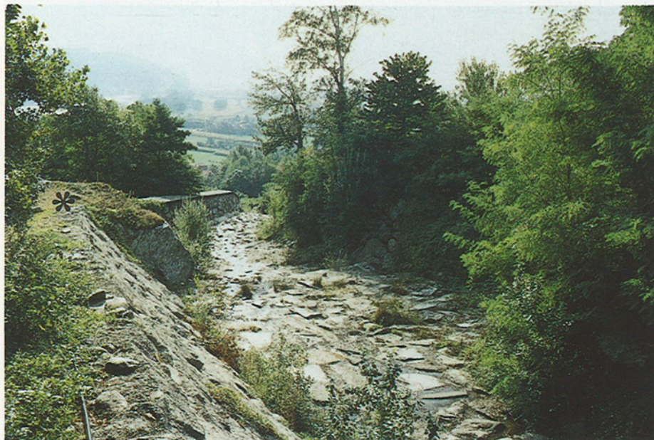
Fig. 4 - Apice del conoide: la fotografia (vista da monte) mostra l'intervento di difesa eseguito in corrispondenza alla zona in cui il Rio Pisone uscì dai suoi argini naturali nell'evento del giugno 1942 (*). La diminuzione della sezione di deflusso causata dal masso sporgente e dalla improvvisa curva a destra dell'alveo, proprio in corrispondenza della sua massima rottura di pendio, giocano un ruolo negativo nel ridurre sensibilmente le possibilità di smaltimento dei materiali trasportabili da una piena.
