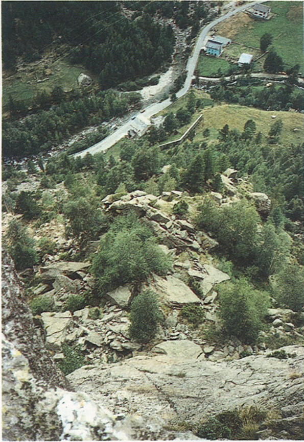
Fig. 2 - La fotografia, scattata dalla sommità della parete rocciosa sovrastante l'abitato di Piandellera, mostra le condizioni di fratturazione e disarticolazione dell'ammasso roccioso nella parte centrale della parete e mette in evidenza il sottodimensionamento dell'opera di difesa in caso di collasso totale o parziale dello stesso.
