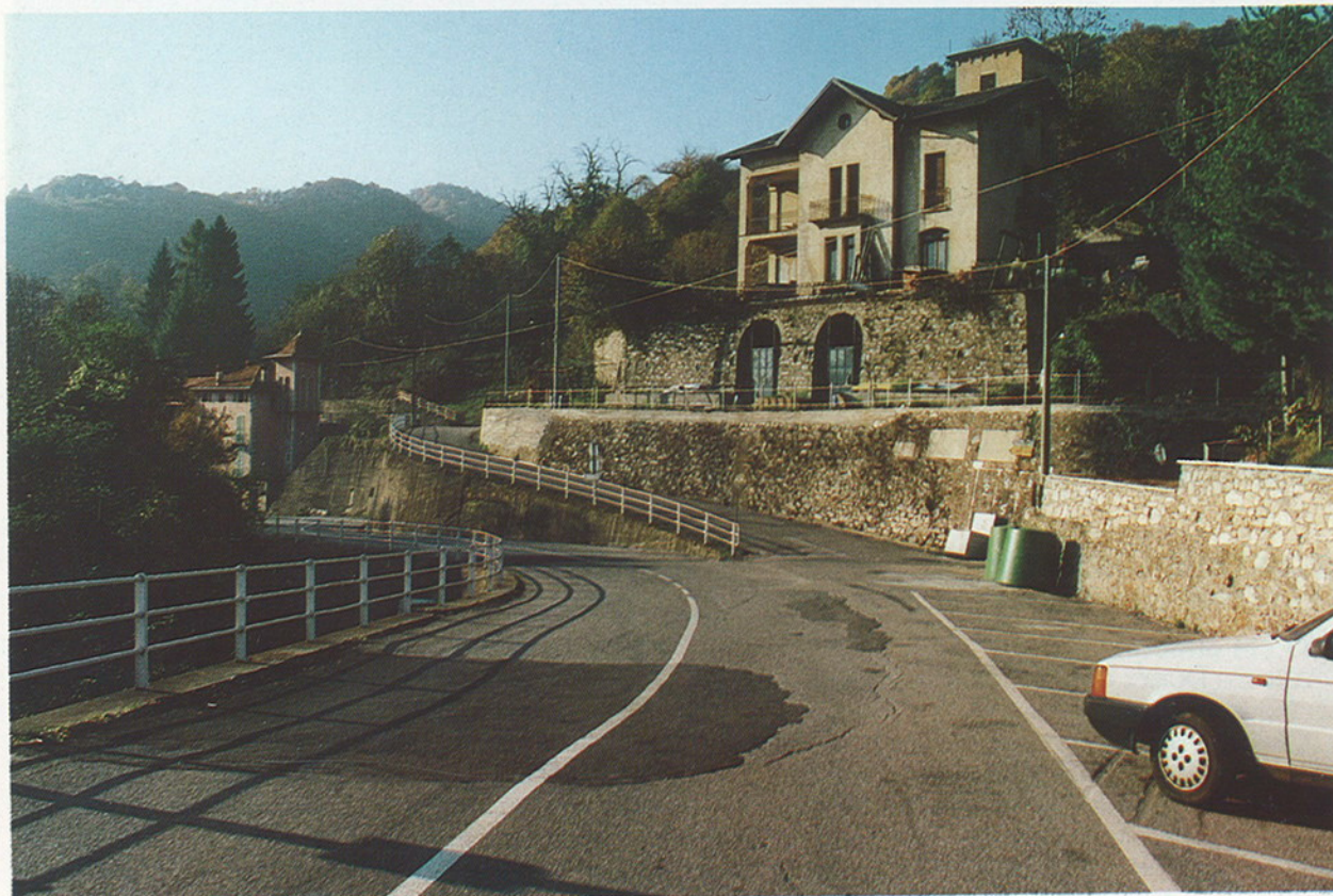
Fig. 2 - La fotografia mostra i rifacimenti parziali dei muri in pietra e le opere di sostegno in calcestruzzo costruite per ripristinare la viabilità delle due strade a tratti franate durante l'evento del novembre 1951. La casa al centro della foto venne gravemente lesionata dai movimenti del terreno in quegli anni. Attualmente sono visibili lesioni diffuse ai manufatti e, in primo piano, lesioni al manto stradale, che sono il sintomo di un continuo molto lento movimento in atto.
