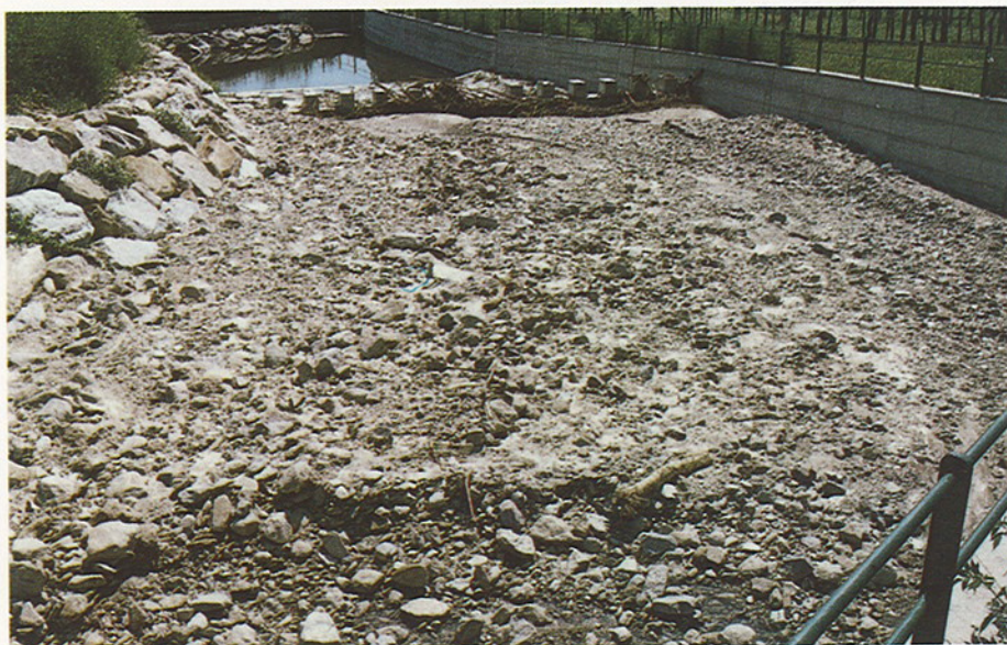
Fig. 5 - Vista da monte della cassa di sedimentazione costruita nel 1986 al piede del conoide dei rii Pisone e Sneira, suddivisa in due comparti da un briglia selettiva capace di trattenere complessivamente un migliaio di m 3 di materiale. Il 18 agosto 1987 l'opera entrò in funzione in seguito ad una piena ordinaria causata da un temporale estivo. La cassa, come mostra la fotografia, trattenne la modesta quantità di materiale trasportato, ma le acque non riuscirono a defluire dal troppo stretto canale scolmatore ed allagarono le case circostanti.
