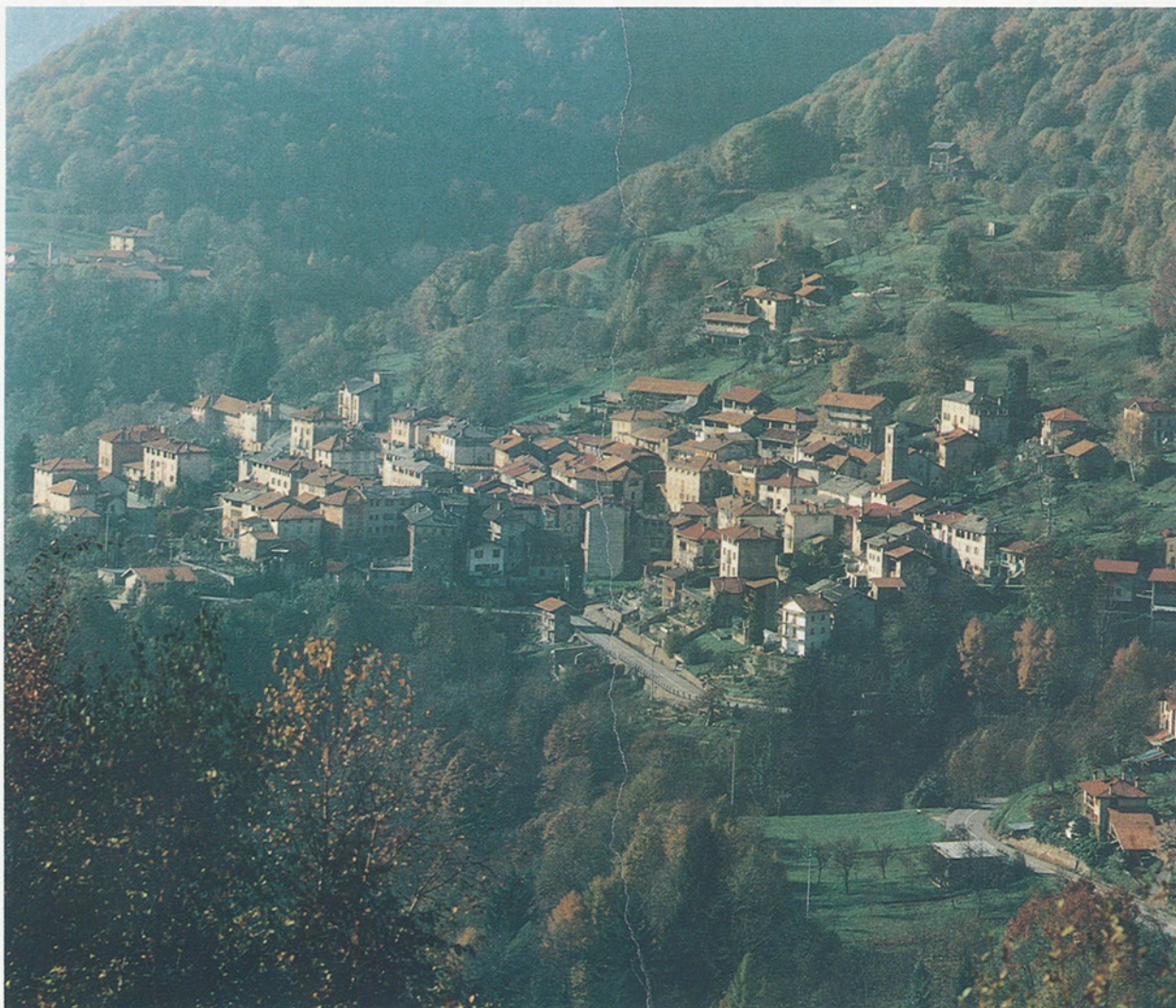
Fig. 1 - La fotografia mostra, in una visione d'insieme, il versante su cui è costruito l'abitato di Civiasco. Il movimento franoso interessa praticamente tutta l'area prativa sovrastante il centro abitato principale, coinvolgendo in modo grave il gruppo di case isolate visibili in alto (Fraz. Peracino), ed alcune case alla periferia del paese.
