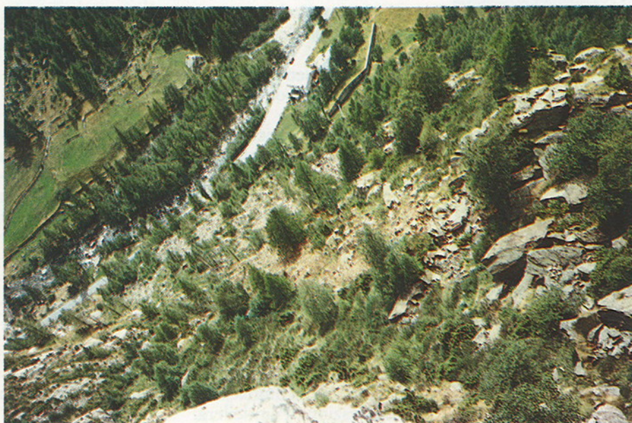
Fig. 4 - Visione dall'alto del canale roccioso lungo il quale, in seguito alla frana verificatasi il 23 maggio 1984, sono scesi, con meccanismi di rotolamento, salti e rimbalzi, numerosi massi alcuni dei quali, deviando leggermente sulla destra, hanno danneggiato gli edifici e la strada sottostante.
