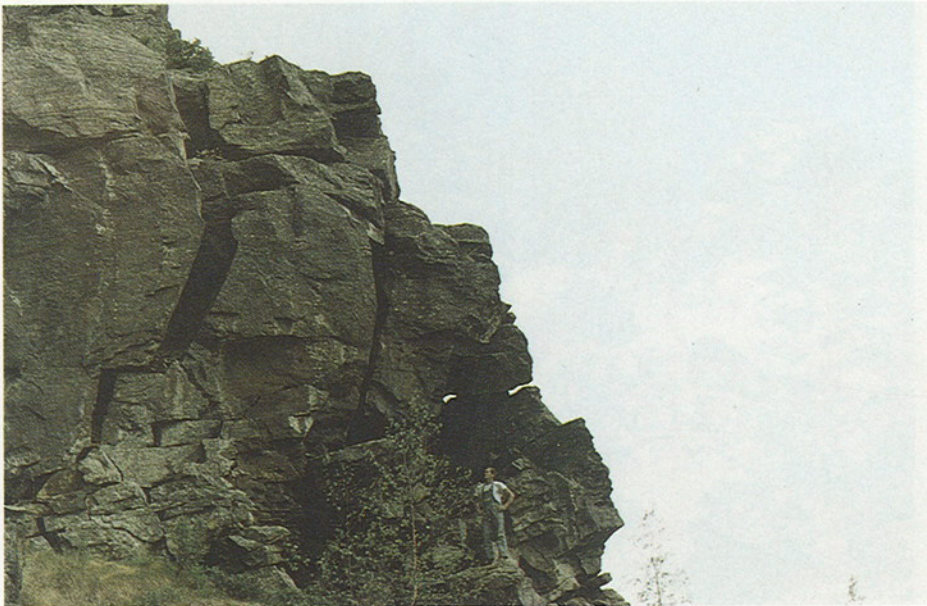
Fig. 3 - Lo stesso ammasso roccioso, visto nel settore occidentale, pur lasciando intravedere le originarie condizioni giaciture, presenta vistosi fenomeni di disgiunzione lungo i principali e ben sviluppati sistemi di frattura, con aperture che raggiungono 50-60 cm di larghezza.
