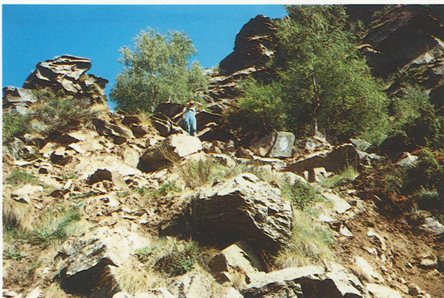
Fig. 5 - Particolare della zona di distacco della frana verificatasi il 23 maggio 1984 che ha provocato il rotolamento a valle di massi di grosse dimensioni. Si possono osservare le condizioni di disarticolazione dell'ammasso roccioso nel settore orientale.
