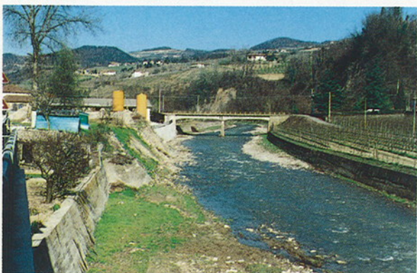
Fig. 1 e 2 - Confronto dello stesso tratto d'alveo del T. Belbo. In alto (estate 1926) è in fase di ricostruzione parte del ponte in pietra e della strada d'accesso al cimitero, asportati dalle acque in piena il 16 maggio del medesimo anno. In basso la situazione attuale: la sezione di deflusso del ponte è stata notevolmente ampliata, ma si notano purtroppo un restringimento dell'alveo, causa la presenza di riporti e manufatti in area allagabile.
