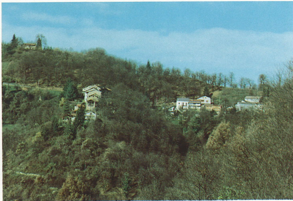
Fig. 1 - Veduta della borgata Piano e del tratto di versante contiguo a Roà Marenca (a destra della foto). In tale zona si sono riscontrate modeste lesioni ad alcuni edifici e deboli segni di movimento franoso.
