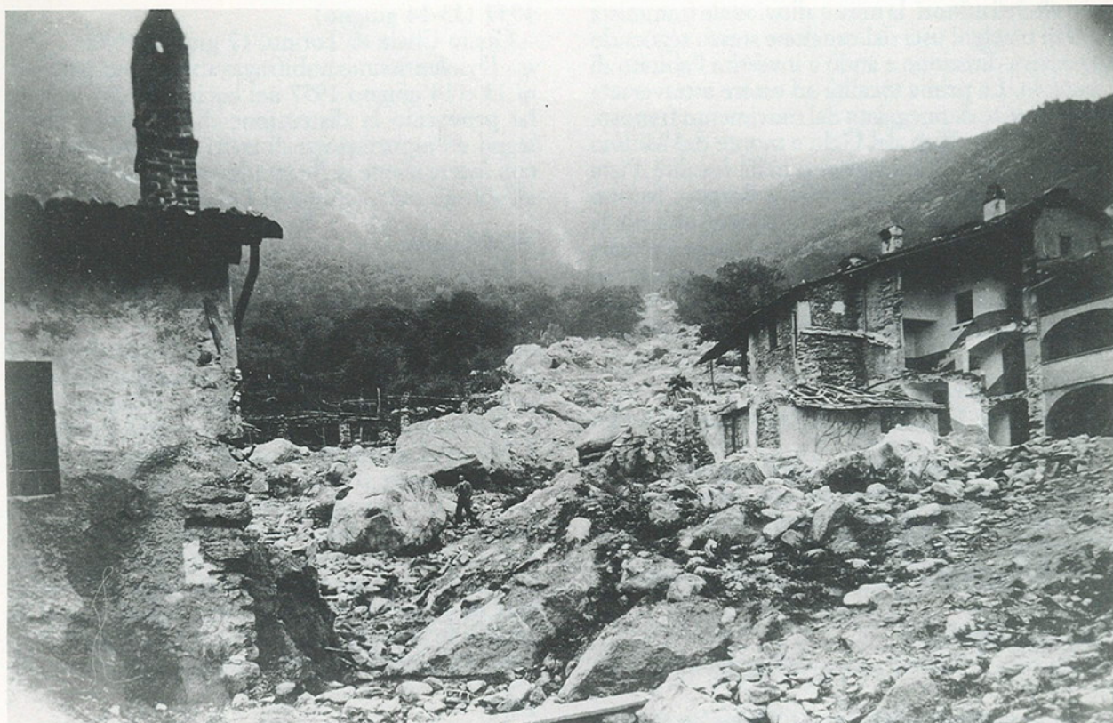
Figg. 2 e 3 - Settore apicale del conoide del Rio Pisone. La fotografia in alto, scattata poco dopo l'evento del giugno 1942, evidenzia le capacità di trasporto solido di questo piccolo rio e la gravità con cui fu colpito il centro abitato costruito sul conoide e sventrato dalla piena. La fotografia in basso, scattata quasi 50 anni dopo pressapoco dallo stesso punto, mette in risalto come la ricostruzione delle opere e il ripristino delle attività cancellino, con l'aiuto del tempo, i segni della tragedia e, di conseguenza, velocemente la memoria del pericolo esistente.
