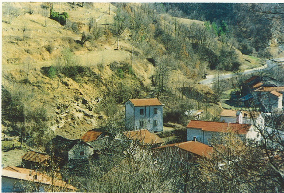
Fig. 2 - Particolare dell'abitato nel quale è visibile il rapporto esistente tra zone di distacco dei due processi di fluidificazione dei terreni superficiali (le due zone scure che interrompono l'orlo del terrazzo) e gli edifici sottostanti. La ex scuola (al centro della fotografia) fu colpita dal materiale altamente mobile franato a seguito dell'evento idrometeorologico del novembre 1951.
