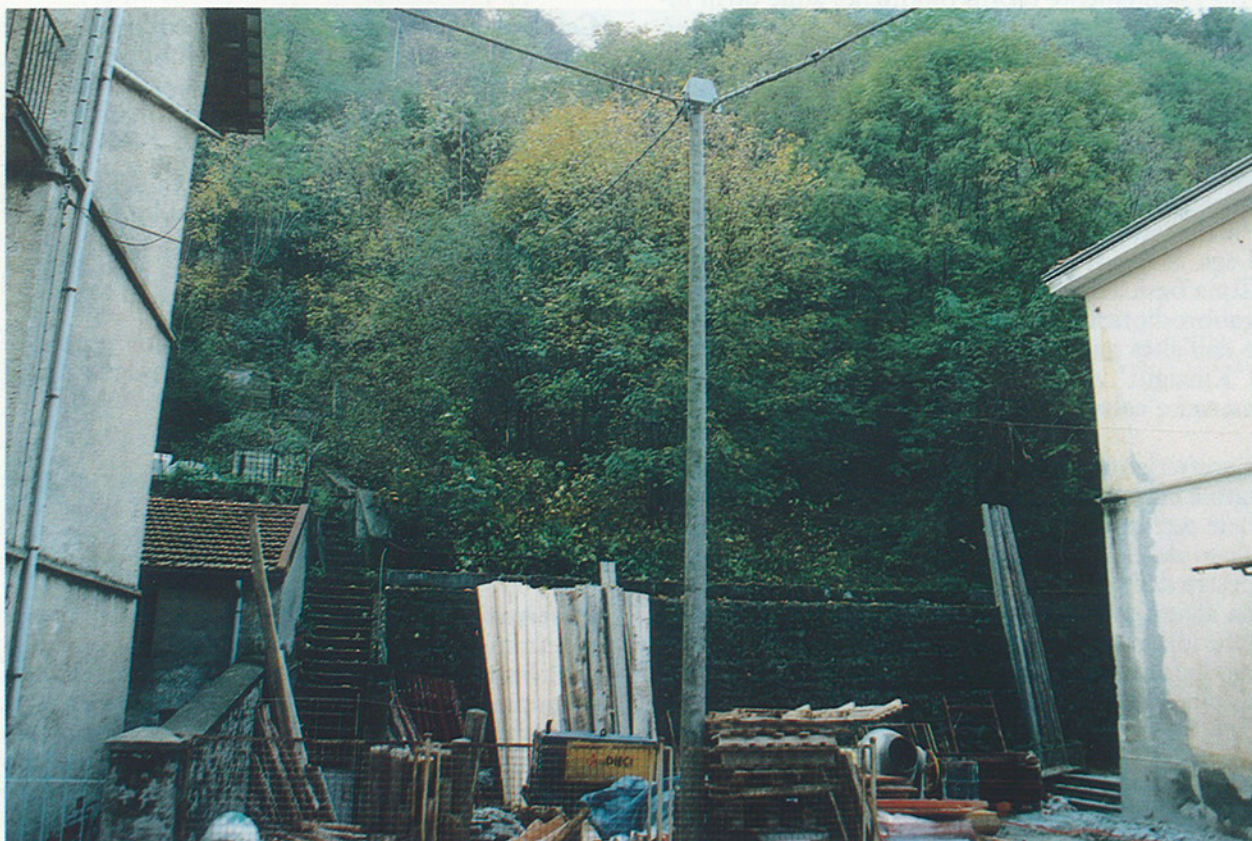
Fig. 1 - La fotografia mostra il piccolo bacino da cui è scesa la massa fangosa che, dopo aver investito i locali della scuola (sulla destra) è proseguita verso valle invadendo la strada e fermandosi a ridosso di un edificio (punto d'osservazione). Fra gli alberi si intravedono gli interventi di consolidamento eseguiti.
