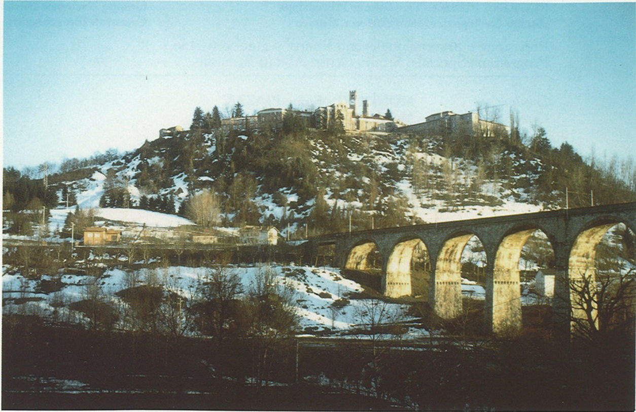
Fig. 1 - Veduta generale del versante nord-occidentale della collina sulla quale sorge il Rione Piazza, dotato di Decreto di consolidamento. I fenomeni di dissesto, riferibili al Decreto, si sono verificati nella porzione sinistra sottostante l'edificio ospedaliero. È ben visibile la variazione di pendenza corrispondente al cambio di litologia tra marne (inferiormente) e sabbie poco coerenti (superiormente). Tale superficie potrebbe corrispondere ad una vecchia corona di frana che in un episodio unico o in più episodi avrebbe dato origine ad accumuli rintracciabili a valle fino a contatto con la piana alluvionale. In basso a sinistra, in ombra, la scarpata di erosione fluviale del T. Ellero.
