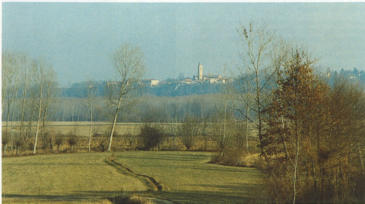
Fig. 1 - Vista d'insieme del centro abitato posto in sponda destra del T. Stura di Demonte a bordo di alto terrazzo fluviale. L'alveo ordinario del fiume è attualmente lontano dalla scarpata d'erosione per la quale, tuttavia, permangono seri problemi di stabilità legati alla scarsa competenza dei depositi alluvionali costituenti il substrato.
