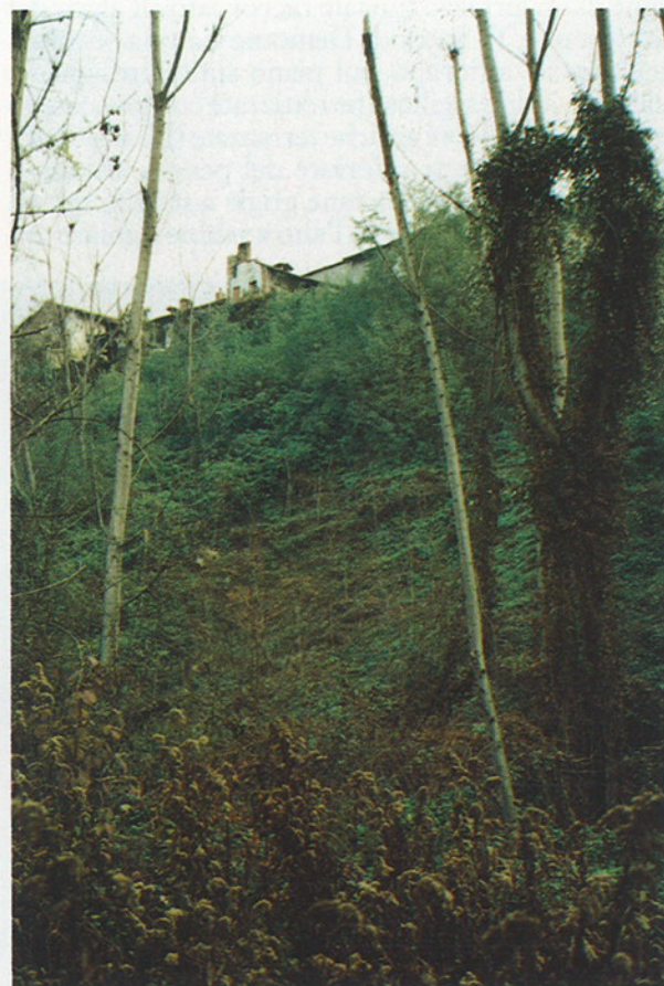
Fig. 2 - Particolare della scarpata originatasi per attività fluviale esplicitasi anche in epoca recente (prima metà del secolo). Numerosi edifici furono coinvolti nei secoli scorsi nei fenomeni franosi così come mostrato da carte catastali di età napoleonica e seguenti.
