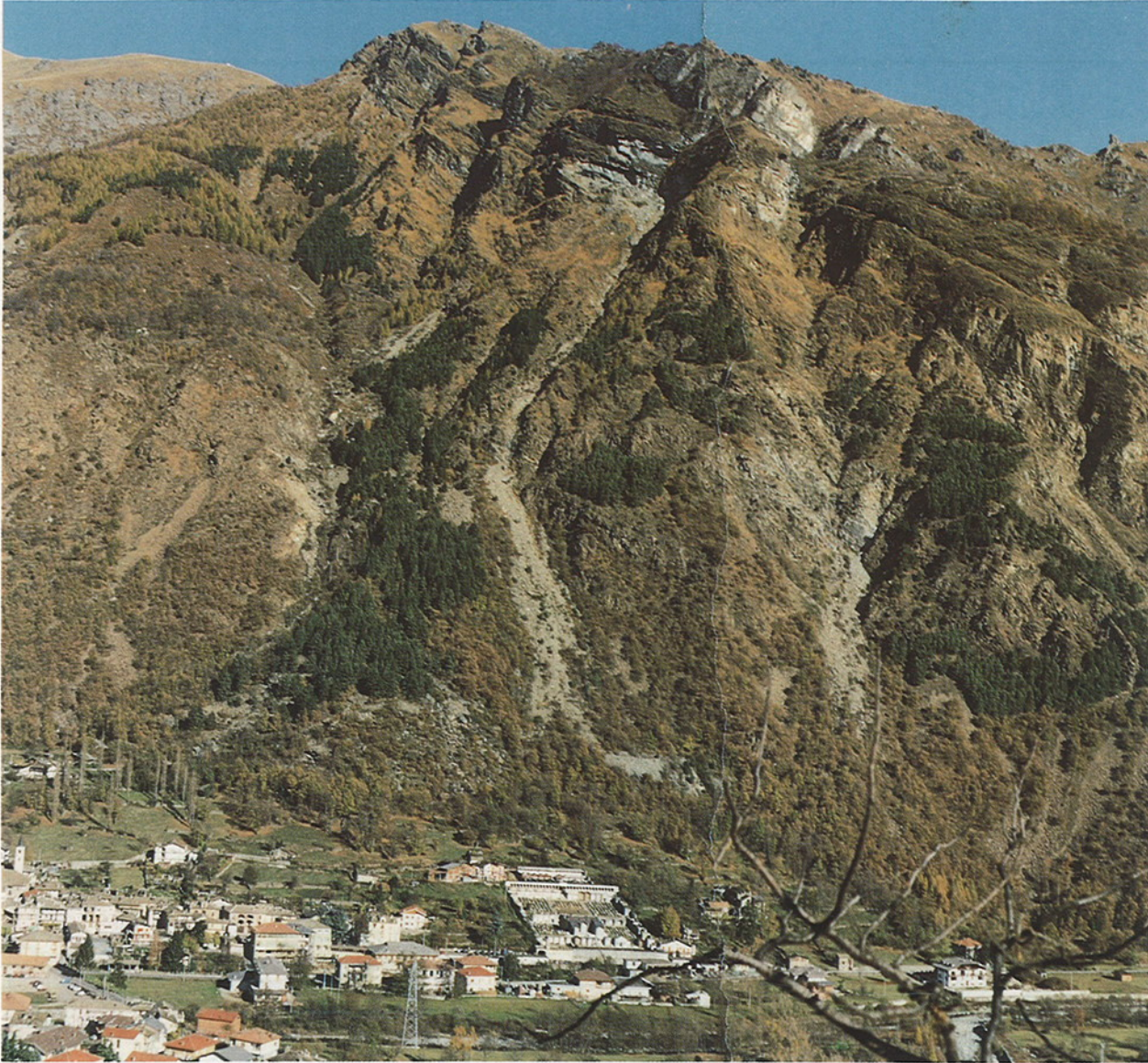
Fig. 1 - Questa fotografia mostra con netta evidenza la parete rocciosa detta "Deir Bianco" da cui si staccarono, la mattina del 14 gennaio 1959 alcune decine di migliaia di m^3 di roccia. Parte di questo materiale precipitò a valle lungo il canale roccioso frantumandosi fino a costituire la colata di detrito sopra al centro abitato, parte, quello più grossolano, continuò la sua corsa per salti, rimbalzi e rotolamenti fino a raggiungere e lambire le case di località Vigna. Visibile a ridosso del centro abitato l'antica frana per crollo parzialmente vegetata da essenze resinose e tutta la fascia di detriti disposta a raccordo tra pareti e fondovalle.
