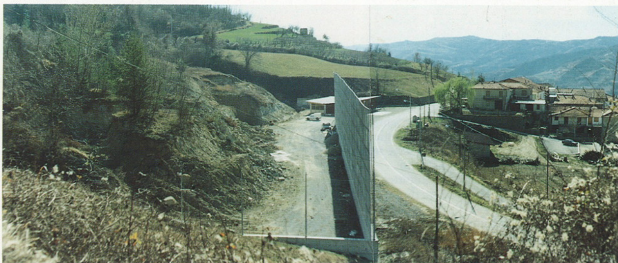
Fig. 2 - Particolare della parte inferiore della frana attivatasi nel 1926. Questa porzione dell'accumulo è oggi mascherata dalla strada Levice-Bergolo e dall'impianto sportivo, in corso di costruzione, al centro della fotografia. Proprio le operazioni di sbancamento attuate hanno riattivato parzialmente il movimento franoso che ha in parte invaso l'area sportiva.
