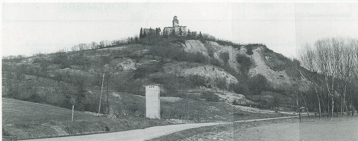
Fig. 1 - Ripido versante sud-occidentale della collina di Montecastello fotografato pochi giorni dopo il movimento gravitativo del 9 marzo 1978. Sono ben evidenti le frane complesse per scorrimento rotazionale passante a colamento e i relativi accumuli.
