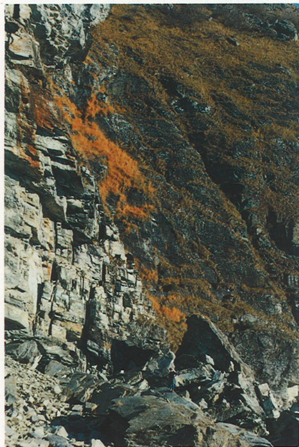
Fig. 3 - In primo piano i volumi rocciosi coinvolti nel crollo della parete del Deir Bianco avvenuto a causa di una mal condotta attività estrattiva. Sono evidenti i tre grandi sistemi di frattura tra loro ortogonali che hanno rappresentato il fattore predisponente il crollo della parete.
