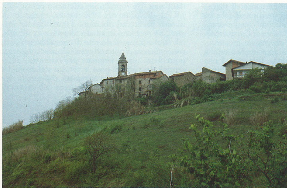
Fig. 1 - Settore meridionale della dorsale sulla quale sorge l'abitato. In concomitanza di notevoli eventi pluviometrici, potrebbero essere lesionate per cedimenti differenziali dei piani di posa le vecchie abitazioni e i relativi terrapieni, collocati sul ciglio di una scarpata dell'altezza di alcuni metri.
