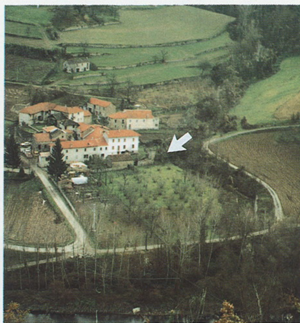
Fig. 1 - Bergamaschi (Bergolo). Particolare del punto di confluenza tra il Rio Bergamaschi e il F. Bormida di Millesimo. Sulla destra dell'abitato, in margine al canale di conoide, il luogo dove si trovava l'edificio lesionato dall'attività parossistica del Rio Bergamaschi nell'autunno 1951.
