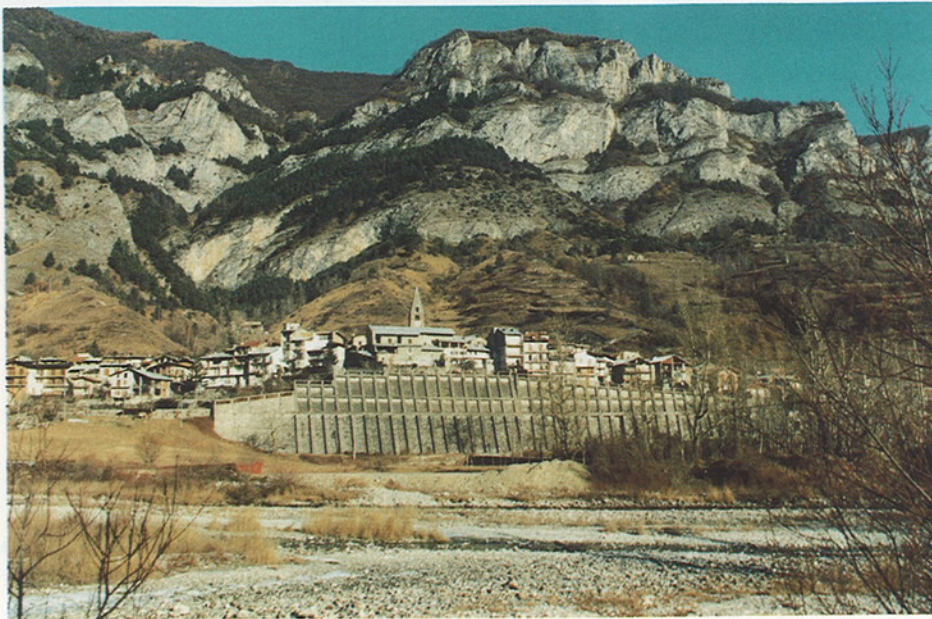
Fig. 1 - Veduta d'insieme del centro abitato posto sul bordo della scarpata d'erosione creata dal T. Stura di Demonte (in primo piano nella fotografia) a danno del vecchio conoide del Rio Villa; a sinistra, sotto l'abitato, l'attuale conoide attivabile.
