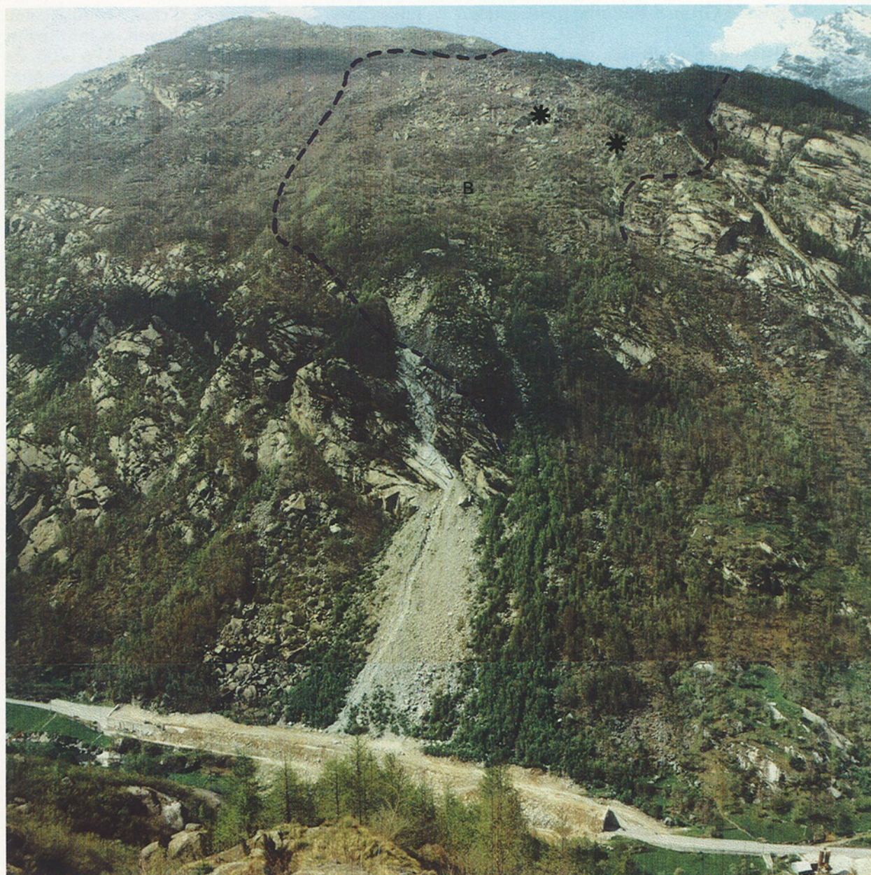
Fig. 1 - Nella fotografia è delimitato il settore orientale del grande e complesso fenomeno gravitativo di Rosone. In quest'area sono in atto i maggiori movimenti finora registrati. Ben visibili in primo piano gli effetti dovuti al collasso del piede della frana che ha portato all'interruzione della viabilità di fondovalle attualmente ripristinata da una galleria. In alto sulla destra la zona di partenza (*) dei grossi massi che hanno danneggiato Bertodasco orientale e Grumel e minacciato di colpire più volte Rosone (in basso a destra appena fuori dal fotogramma). Fra gli alberi la frazione di Bertodasco occidentale (B) quasi totalmente distrutta dai movimenti. In alto la parte di condotte dell'impianto idroelettrico dell'A.E.M. coinvolte nel movimento.
