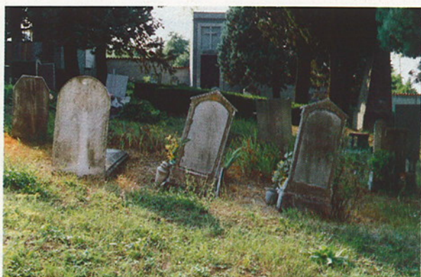
Fig. 2 - Situazione attuale all'interno del cimitero di Brusaschetto. Numerose lapidi appaiono inclinate a causa di lenti sprofondamenti del terreno.
