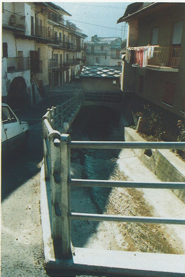
Fig. 3 - Il Rio Villa, visto da monte, all'inizio del sottopasso attraverso l'abitato.
