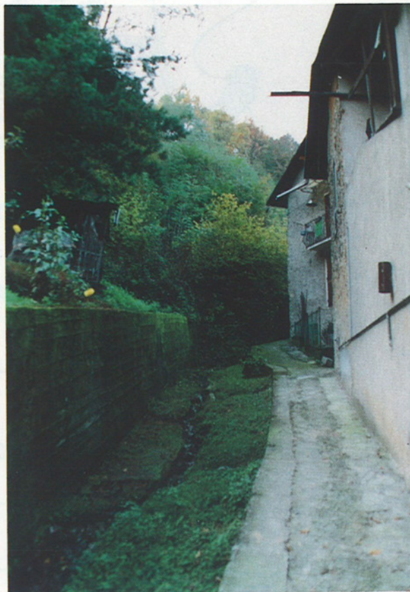
Fig. 1 - Intervento di consolidamento dell'alveo del Rio Franzano (o Croso Ramanaut) percorso durante gli eventi del novembre 1951 e 1968 da colate di fango e detriti.
