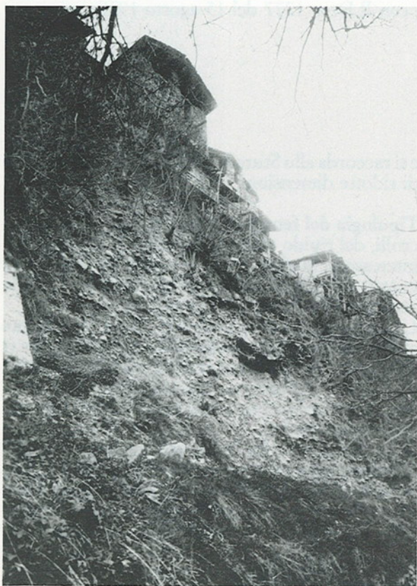
Fig. 2 - Aprile 1930. Vista particolare nella quale sono messi in evidenza i rapporti tra le abitazioni ed il ciglio della scarpata dell'antico conoide del Rio Villa (Archivio C.N.R.-I.R.P.I. di Torino).
