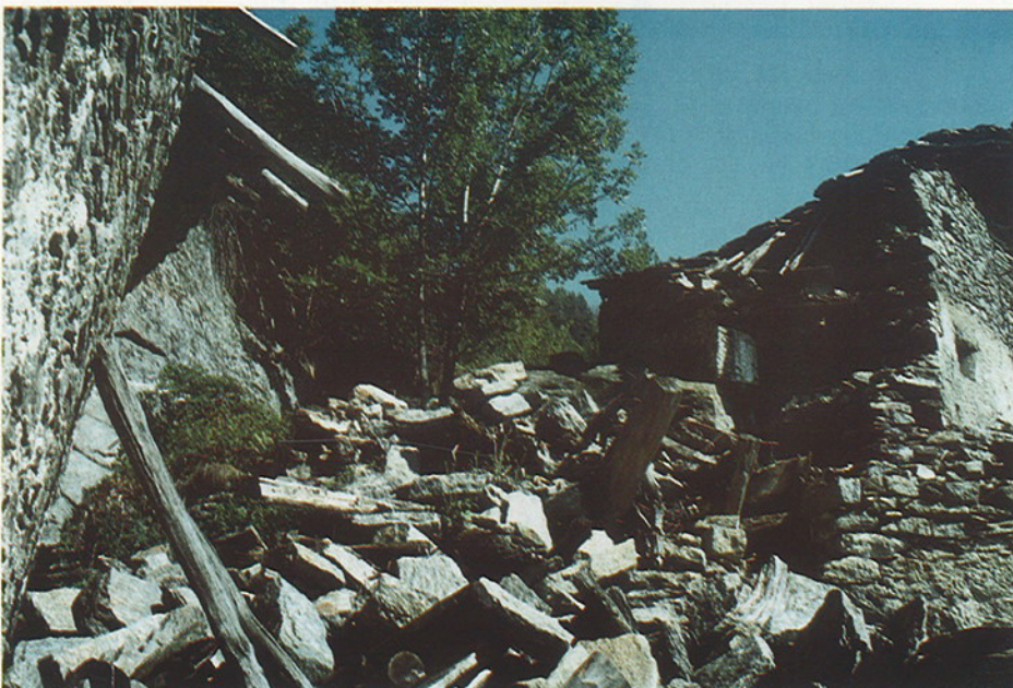
Fig. 2 - Particolare della borgata di Bertodasco Occidentale gravemente danneggiata dal movimento franoso. Visibile sulla sinistra degli alberi una delle superfici di rottura, con scarpata alta un paio di metri, che hanno tagliato la borgata facendo crollare o lesionando gravemente i fabbricati ivi costruiti.
