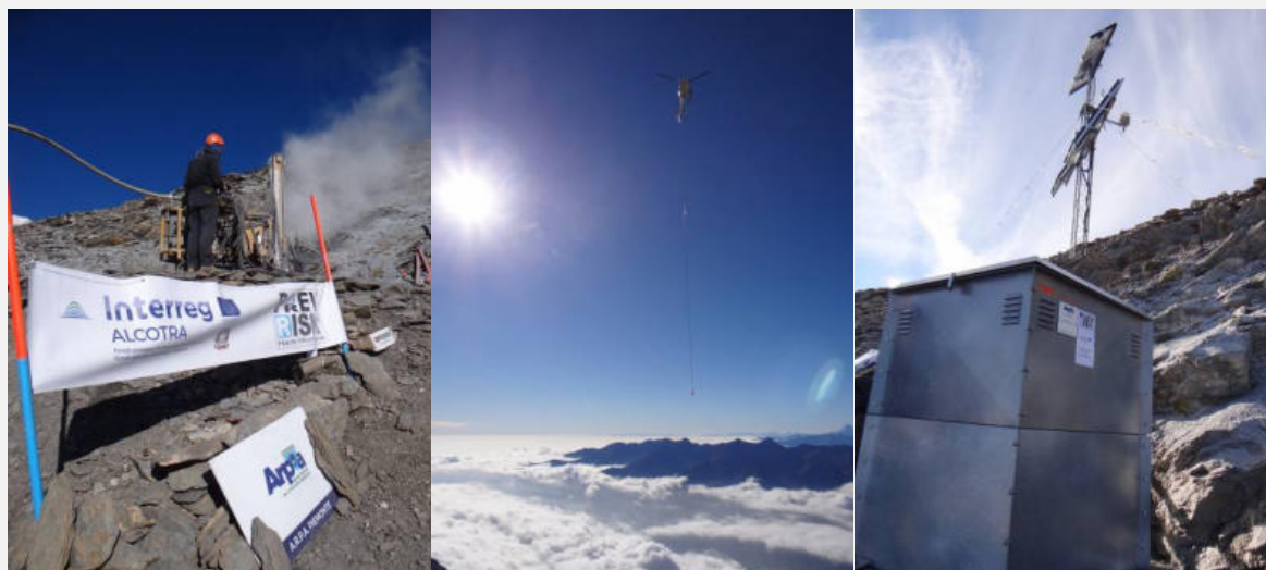
Figure 9 – Installation d'une colonne multi-paramètre DMS au Mont Rochemelon (Piémont, It). À gauche : forage destructif à air comprimé de 30 m de profondeur. Au centre : insertion de la colonne DMS par hélicoptère. À droite : boîtier métallique abritant les appareils de surface. Le pylône soutient le système d'alimentation photovoltaïque et les antennes de transmission des données.
