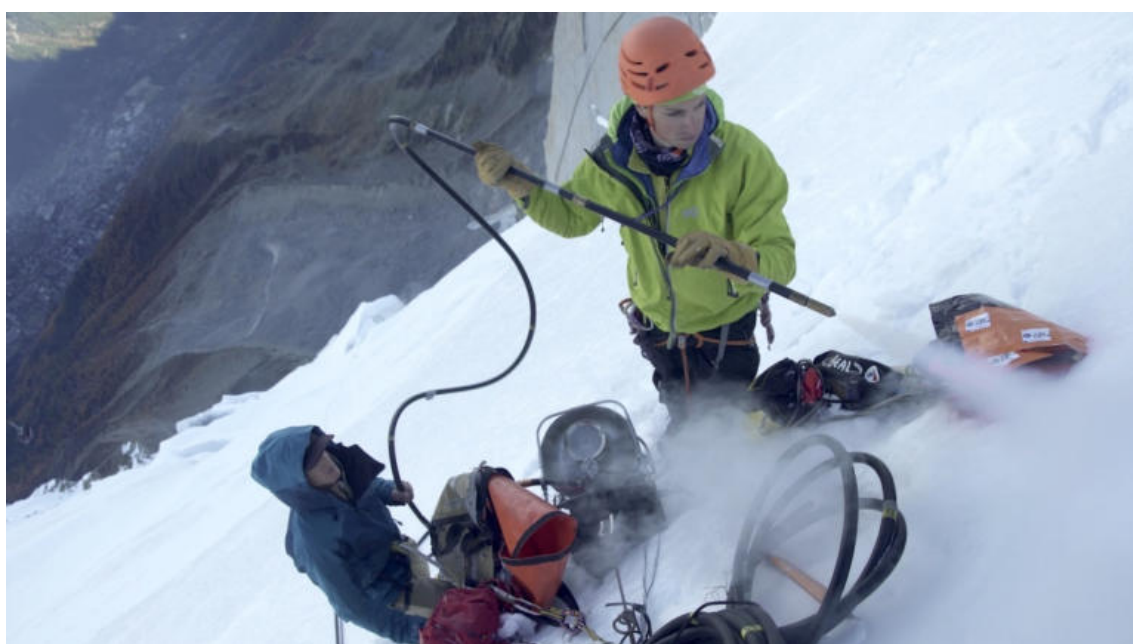
Figure 8 – Mise en place d'une ligne de capteurs de température dans l'un des glaciers suspendus de l'Aiguille du Midi (Chamonix, Fr). Un capteur de température implanté dans le rocher complète le dispositif.
