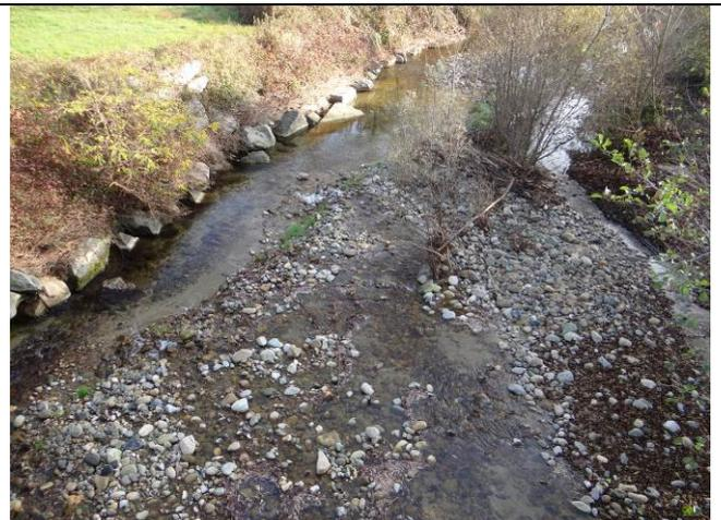
Figura 3. Particolare del fondo alveo e difese in sponda sinistra a valle del ponte su via per Cerrione a Mongrando.
