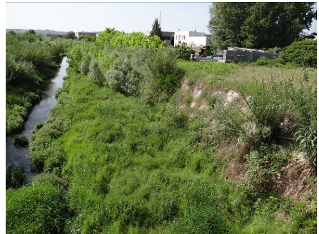
Difese spondali in blocchi a protezione dell'area industriale.
