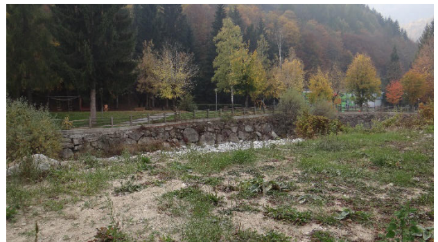
Difesa spondale in sponda sinistra.
