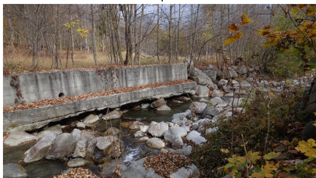
Sottoescavazione difese in sponda sinistra
