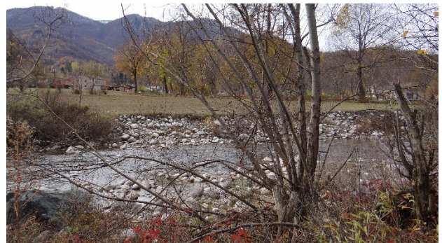
Dettaglio erosione in sponda sinistra.
