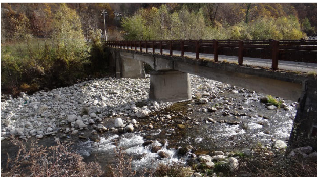
Dettaglio fondo alveo e sedimenti, in presenza di ponte stradale interferente.
