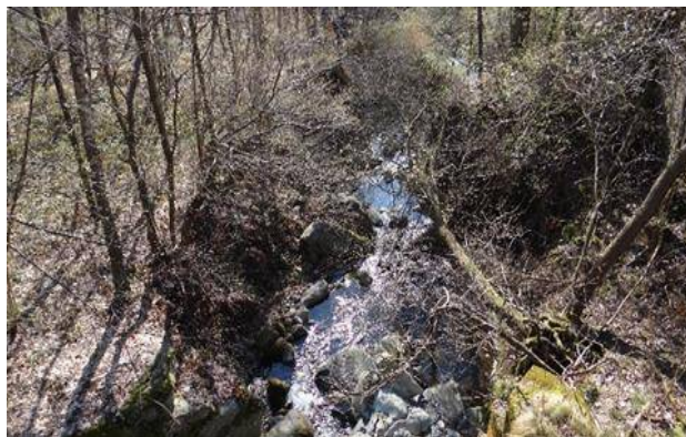
Particolare alveo a valle della presa
