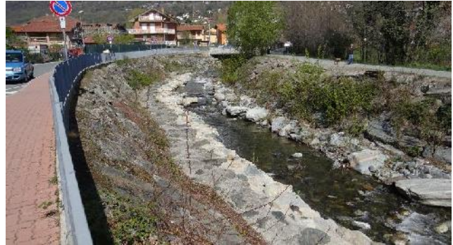
Dettaglio difese spondali e fondo in comune di Almese
