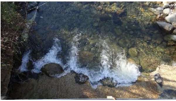
Soglia in corrispondenza del ponte in borgata Roggero
