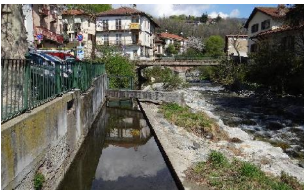
Presa per lavatoio, ponte interferente, difese spondali in comune di Almese
