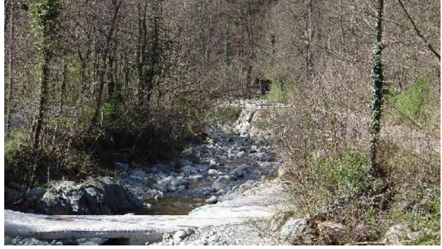
Guado e difese spondali in borgata Casei
