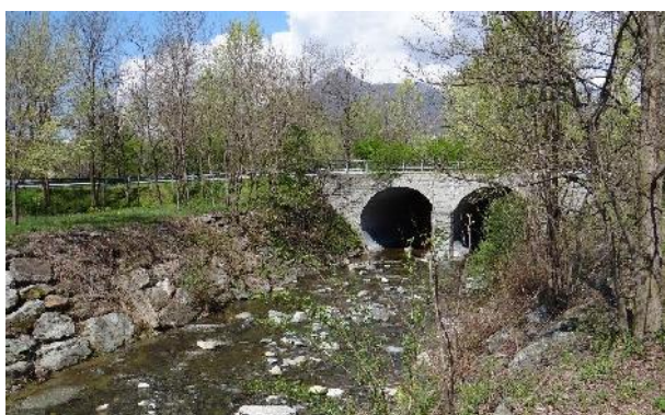
Ponte interferente e difese spondali ad inizio tratto
