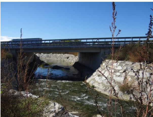
Ponte della A21 e difese di sponda nelle vicinanze della Stazione di Villafranca-Cantarana
