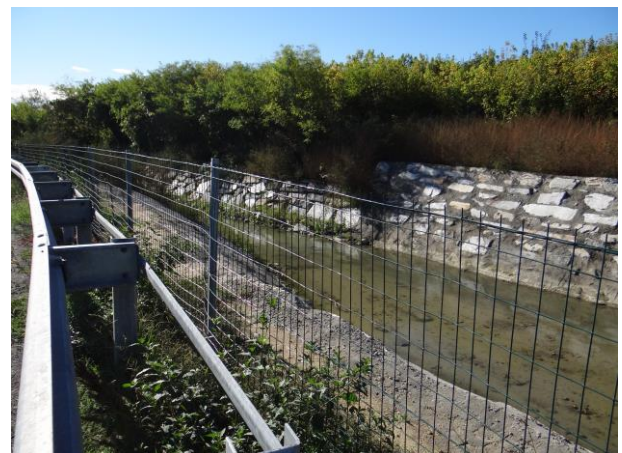
Difese e fondo dell'alveo a valle del ponte della A21
