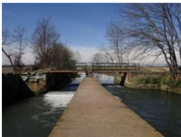
Il ripartitore dei deflussi.
