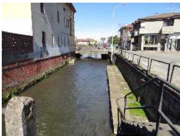
Alveo del torrente nell'abitato di Cerano.
