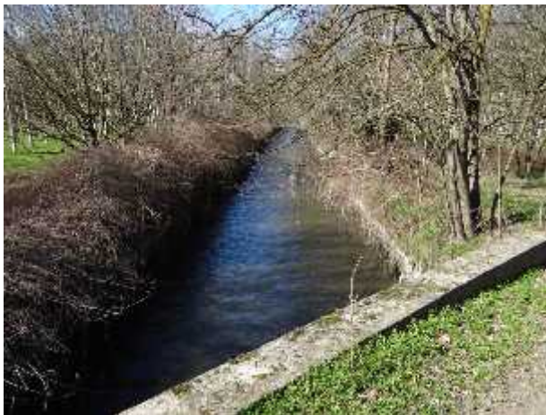
Traversa di derivazione in comune di Momo.
