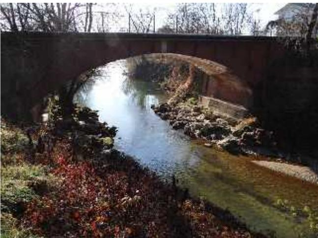
Il ponte di via Cameri presenta blocchi cementizi sia in destra che in sinistra, quasi a costituire una soglia, a difesa delle spalle.
