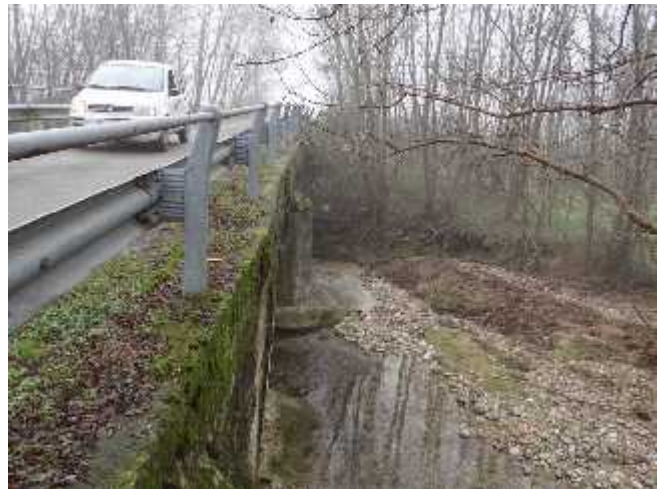
Attraversamento da Vaprio a Mezzomerico.
