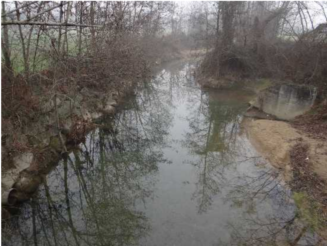
Alveo a monte del ponte di Castelletto: a sinistra difese spondali, a destra confluenza del torrente Agamo.
