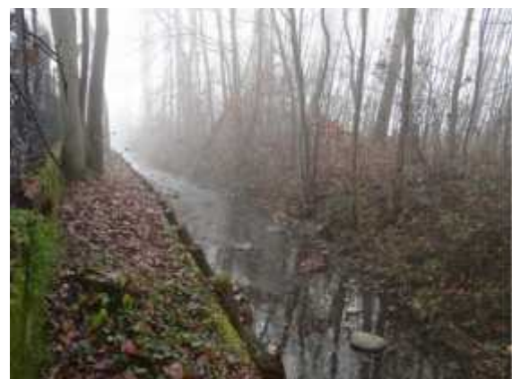
Difese spondali a Cordona.
