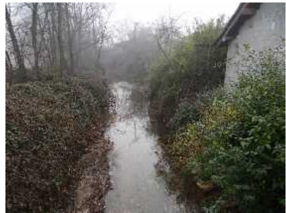
Vista dell'alveo a valle del ponte di Suno.
