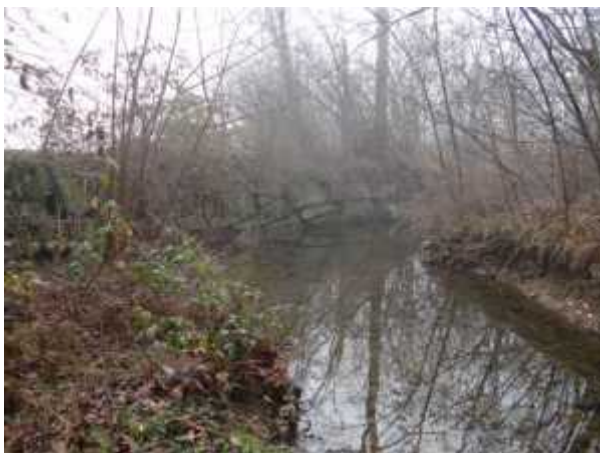
Difese spondali lungo Via Conturbia.
